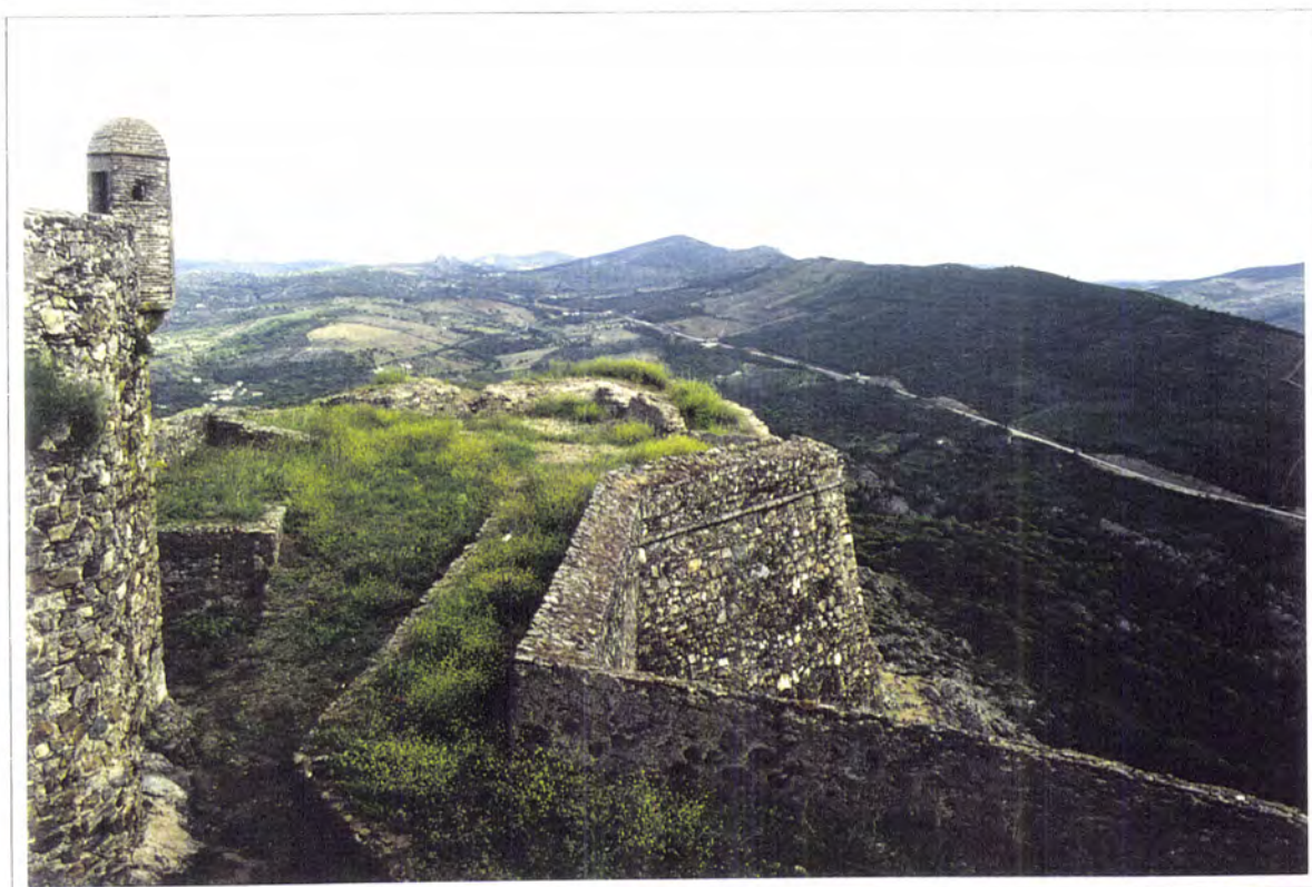
Fig. 6.3.35 - Fortificações de Marvão. Baluarte sul do Postigo do Torrejão
