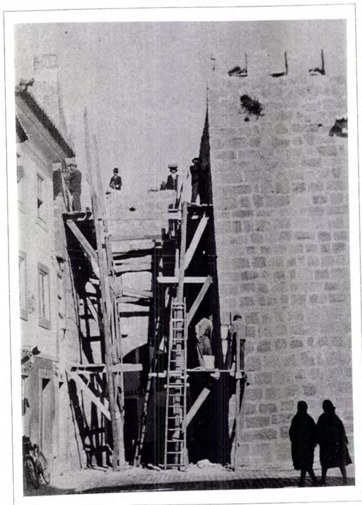
Fig. 6.5.42 - Nisa. Porta da Vila, vista de extramuros, durante a intervenção de 1943/45) (foto DGEMN)
