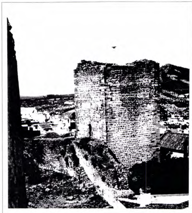
Fig. 6.5.51 - Portalegre. Castelo. Torre N antes da intervenção (foto DGEMN 24/9/1968)
