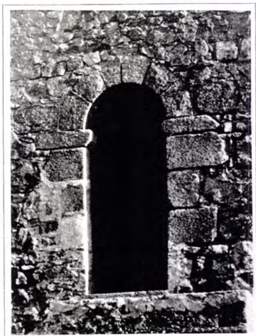
Fig. 6.5.26 - Castelo de Belver. Porta da Torre de Menagem antes da intervenção de 1935 a 1946 (foto DGEMN)
