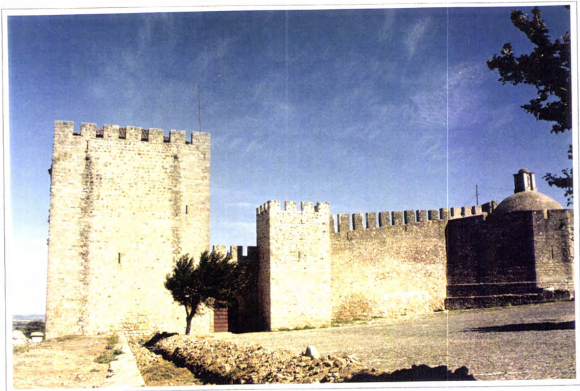
Fig. 6.4.3 - Castelo de Elvas. Quadrela SO com a Portal da Vila.
