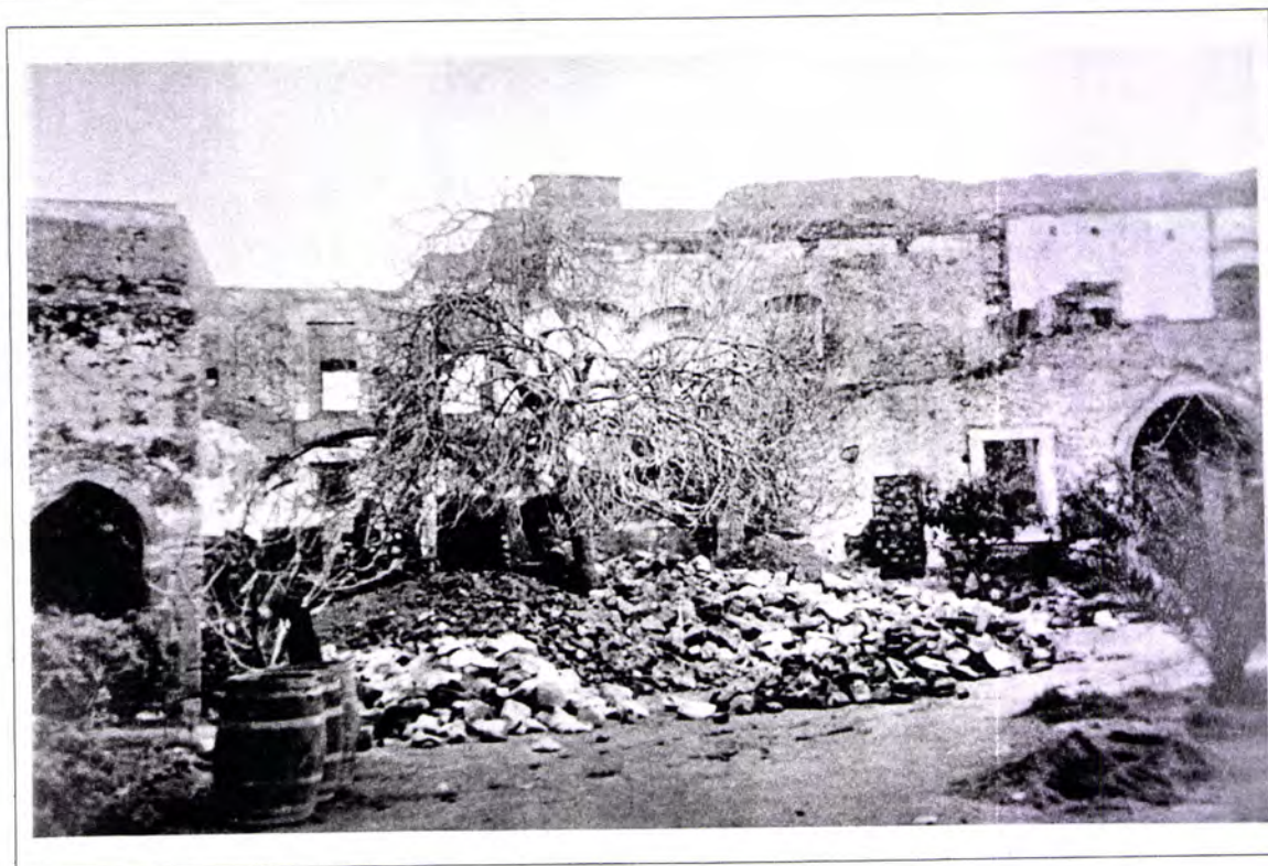
Fig. 6.4.96 - Castelo de Elvas. Edificações do pátio, antes das demolições efectuadas durante a intervenção (1940-1948) (foto DGEMN)
