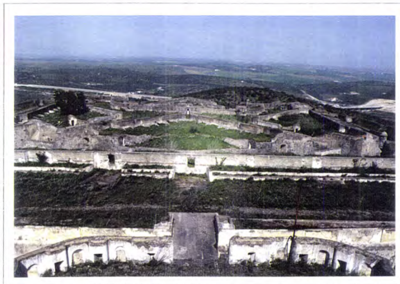
Fig. 6.4.69 - Forte da Graça. Obra corna
