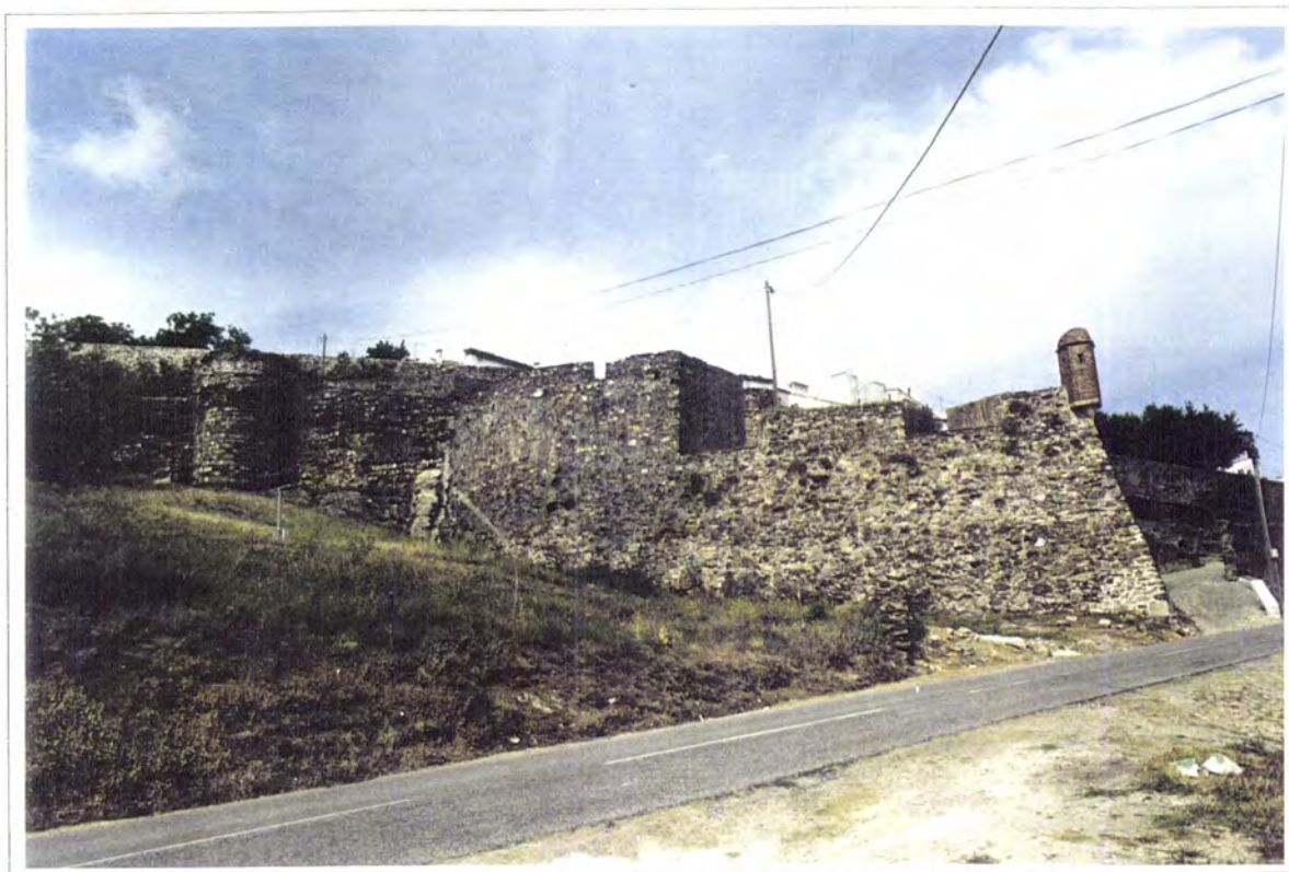
Fig. 6.3.31 - Fortificações de Marvão. Meio baluarte das Portas da Vila
