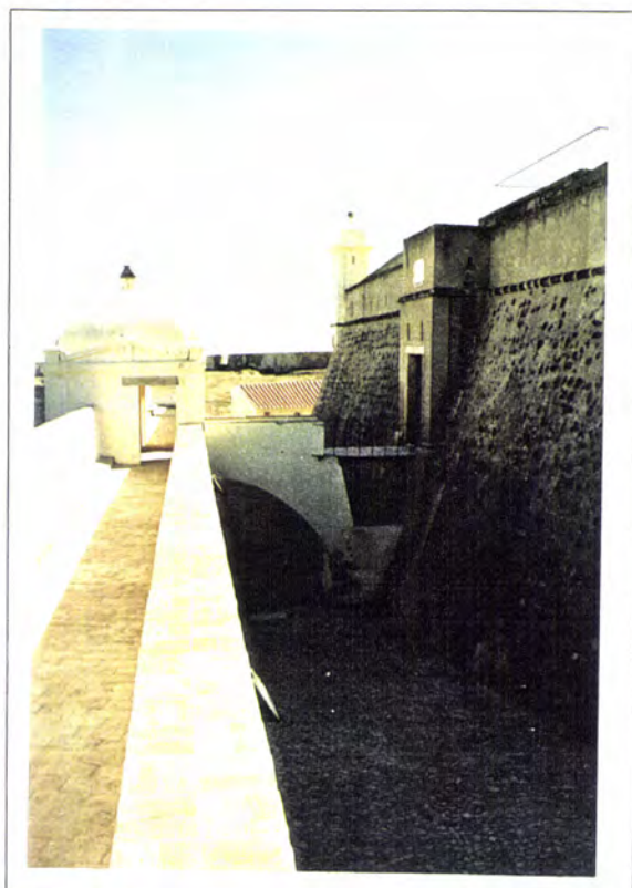
Fig. 6.4.63 - Forte de Santa Luzia. Passadiço de acesso ao reduto central (durante as obras de restauro, 1999)
