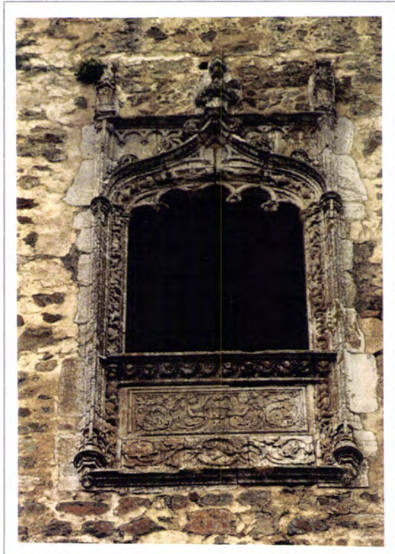
Fig. 6.2.8 - Castelo de Campo Maior. Janela da torre N
