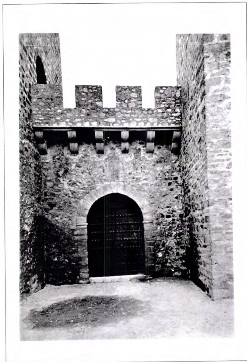
Fig. 6.4.100 - Castelo de Elvas. Porta da entrada (Porta da Vila) depois das intervenções (1940-1948) (foto DGEMN)
