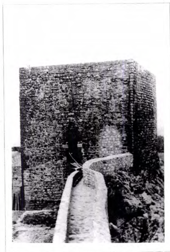
Fig. 6.3.48 - Castelo de Marvão. Segundo recinto. Torre de Menagem depois das intervenções (1938 - década de Quarenta) (foto DGEMN/DREMS)
