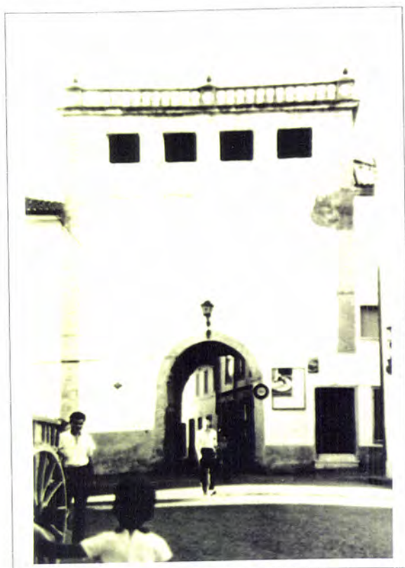
Fig. 6.5.47 - Portalegre. Cerca urbana medieval. Porta de Alegrete antes do restauro (foto DGEMN 15/10/1970)
