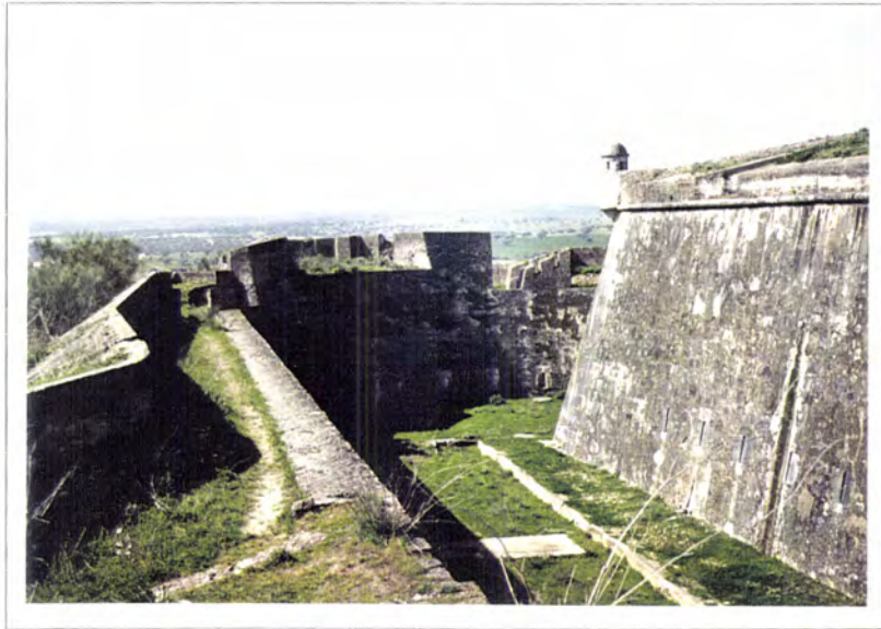
Fig. 6.4.68 - Forte da Graça. Caminho coberto da 1ª linha de defesa e 1º fosso
