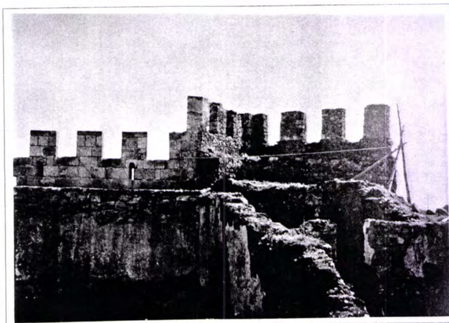
Fig. 6.5.20 - Castelo de Belver. Zona da entrada durante a intervenção de 1935 a 1946 (foto DGEMN)
