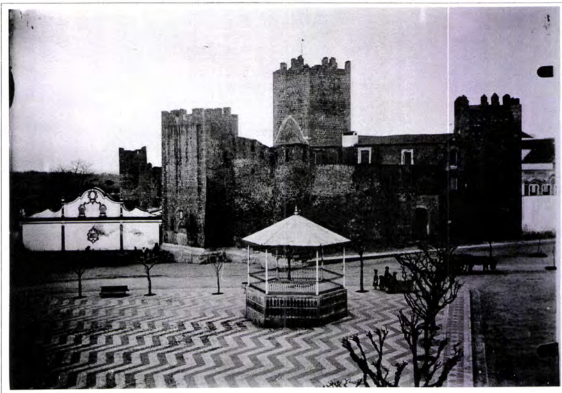
Fig. 6.1.15 - Castelo de Alter do Chão (foto s. d.). Nesta altura, a muralha NE não tinha ameias e a alcaidaria possuía cobertura
