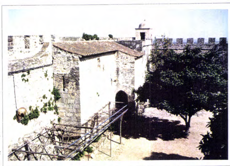
Fig. 6.4.11 - Castelo de Elvas. Construção que defende a escada de acesso os adarves
