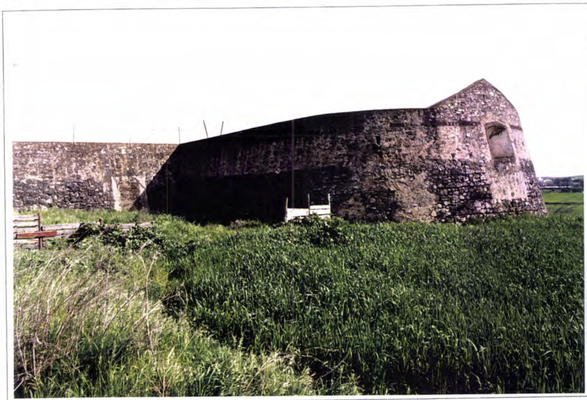
Fig. 6.2.21 - Fortaleza de Campo Maior. Meio baluarte de Santa Rosa, com orelhão, e Porta Falsa emparedada
