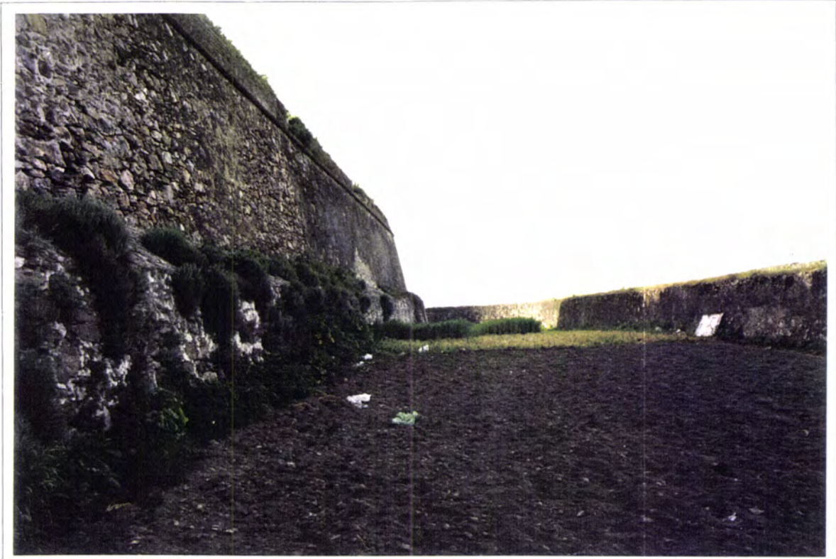
Fig. 6.2.33 - Fortificações de Campo Maior. Embasamento e escarpa do lado rectilíneo do meio baluarte de São Sabastião
