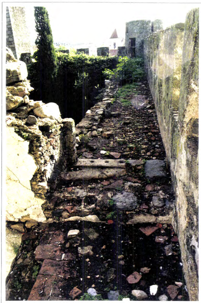
Fig. 6.1.14 - Castelo de Alter do Chão. Adarve da muralha (SO) e vestígios da porta de entrada na alcaidaria
