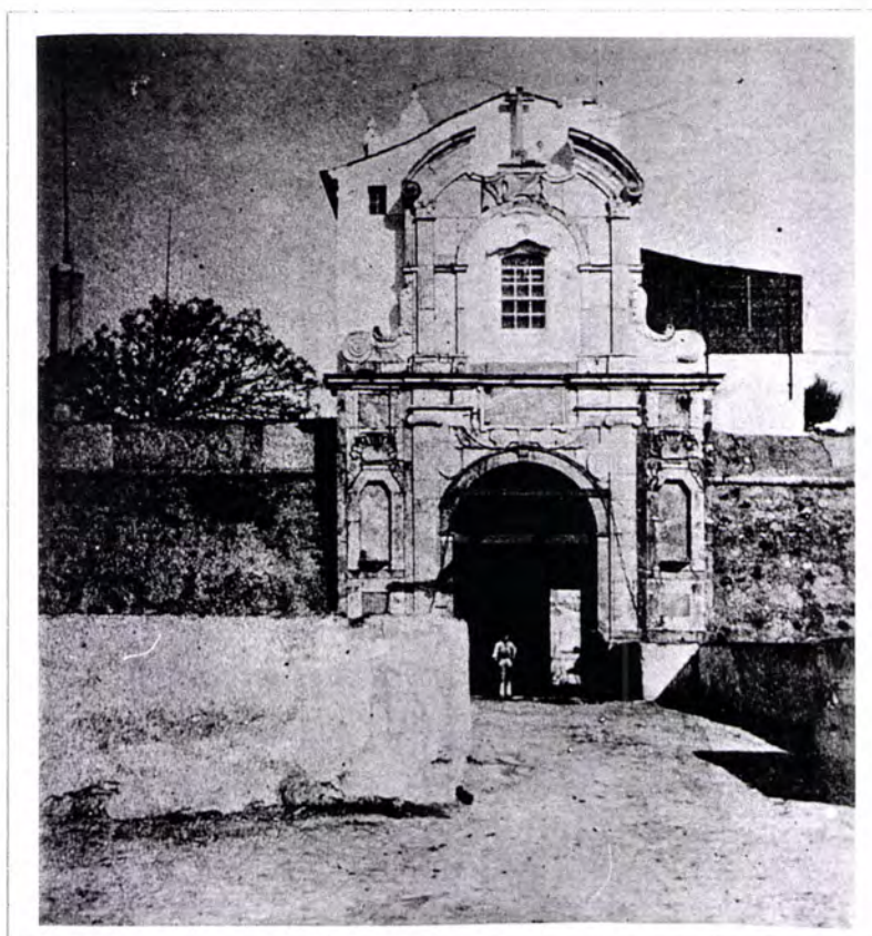
Fig. 6.4.107 - Fortificações abaluartadas de Elvas. Porta da Esquina, antes das intervenções de 1966/1977 (foto DGEMN)
