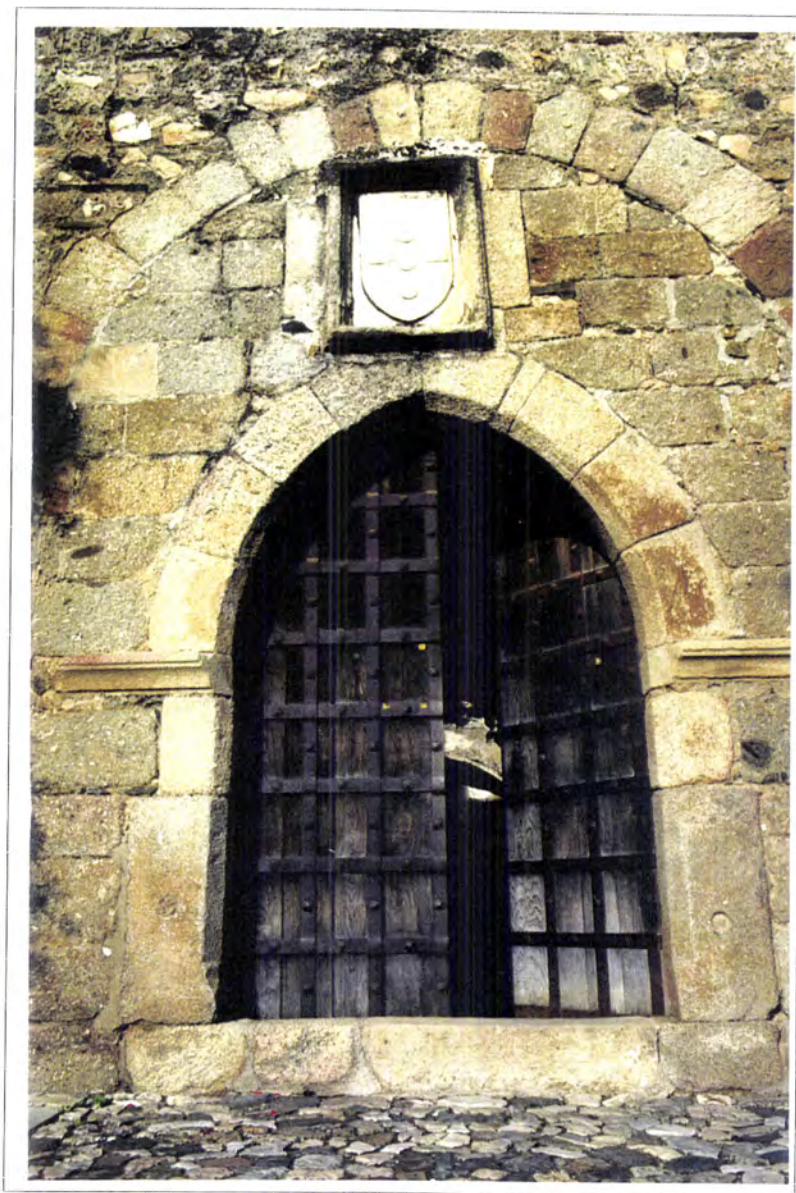
Fig. 6.1.2 - Castelo de Alter do Chão. Porta principal ou da vila
