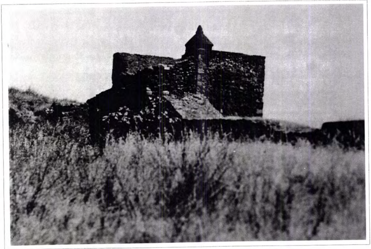
Fig. 6.2.46 - Castelo de Campo Maior. Torreão do tramo SO da cerca antes das intervenções de 1942-1945 (foto DGEMN/DREMS)
