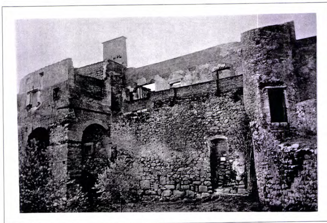
Fig. 6.4.103 - Castelo de Elvas. Quadrela NE, vista do exterior, antes das demolições efectuadas durante a intervenção (1940-1948) (foto DGEMN)
