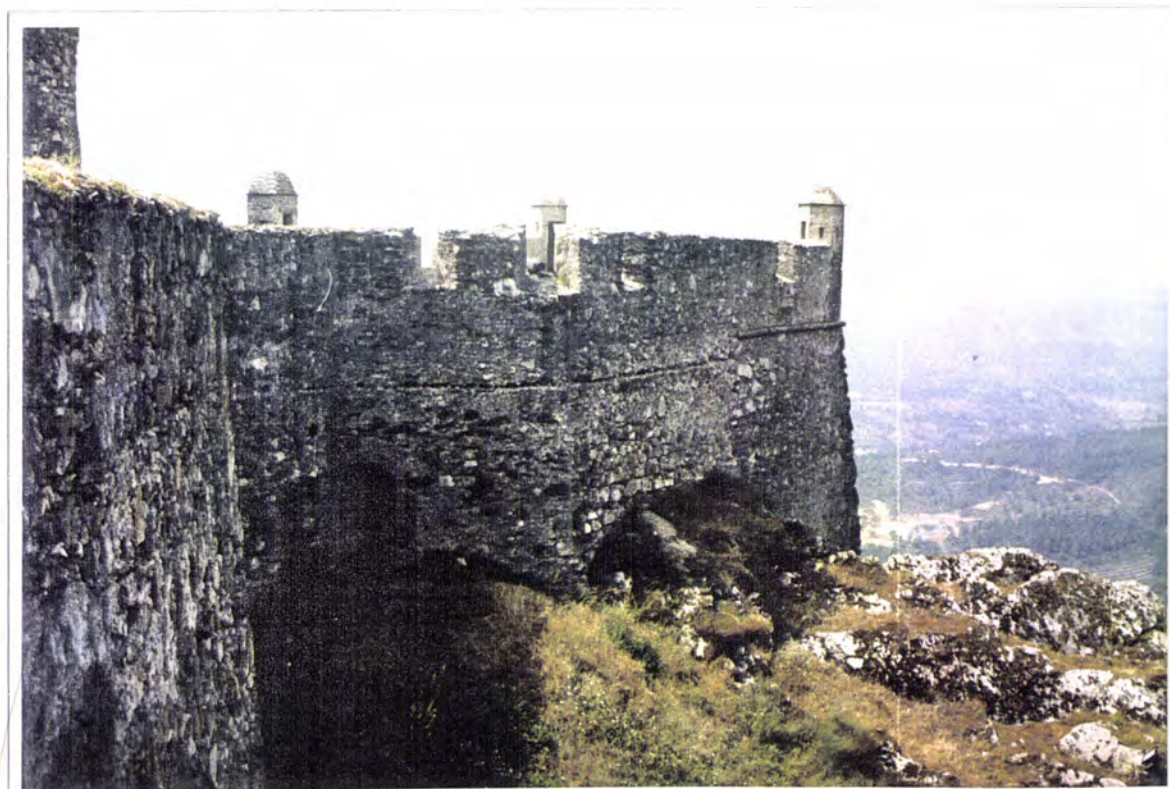
Fig. 6.3.14 - Castelo de Marvão. Baluarte O da Tenalha do Castelo. Porta da barbacã vista do exterior
