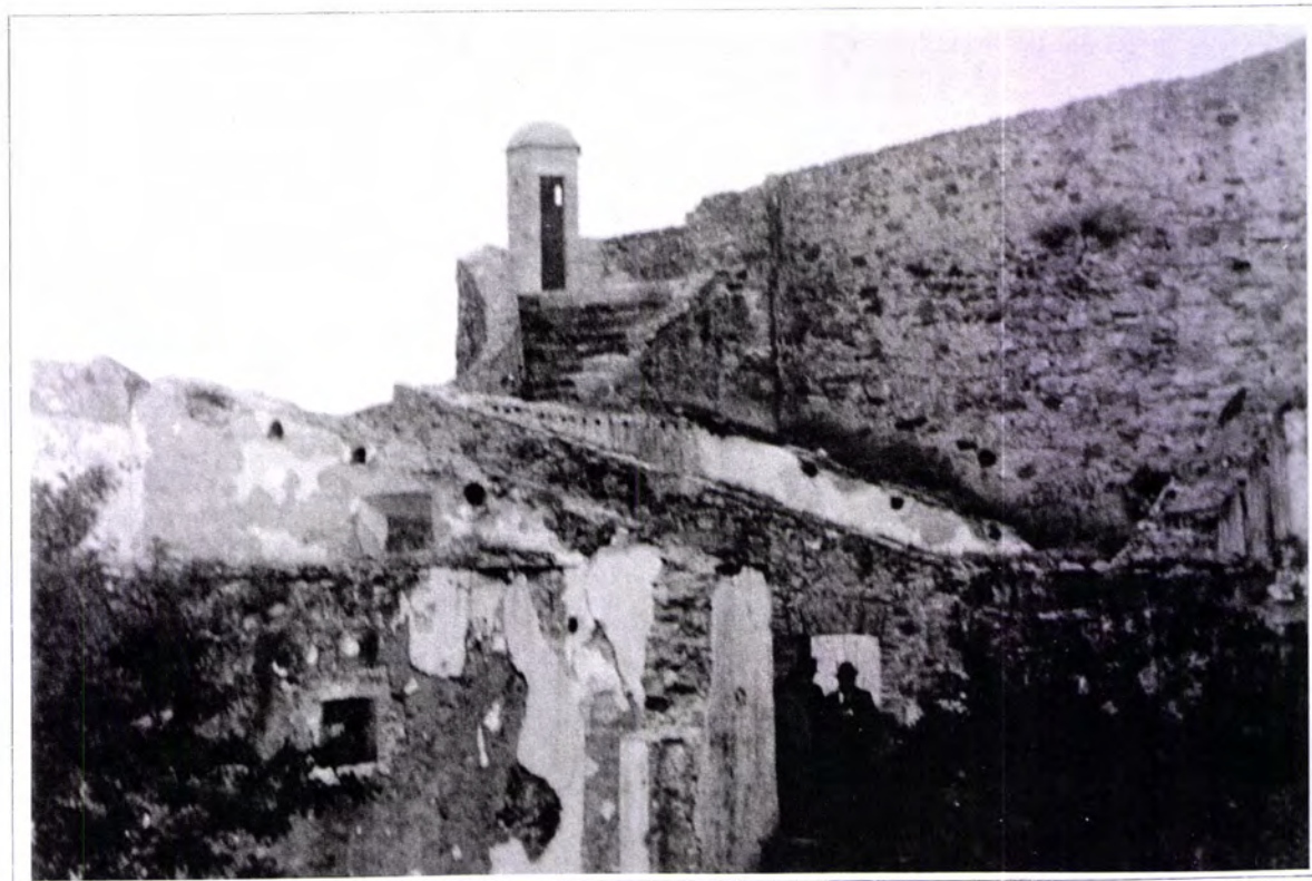
Fig. 6.3.43 - Castelo de Marvão. Segundo recinto, edifícios do troço SO. Intervenções (1938 - década de Quarenta) (foto DGEMN/DREMS)
