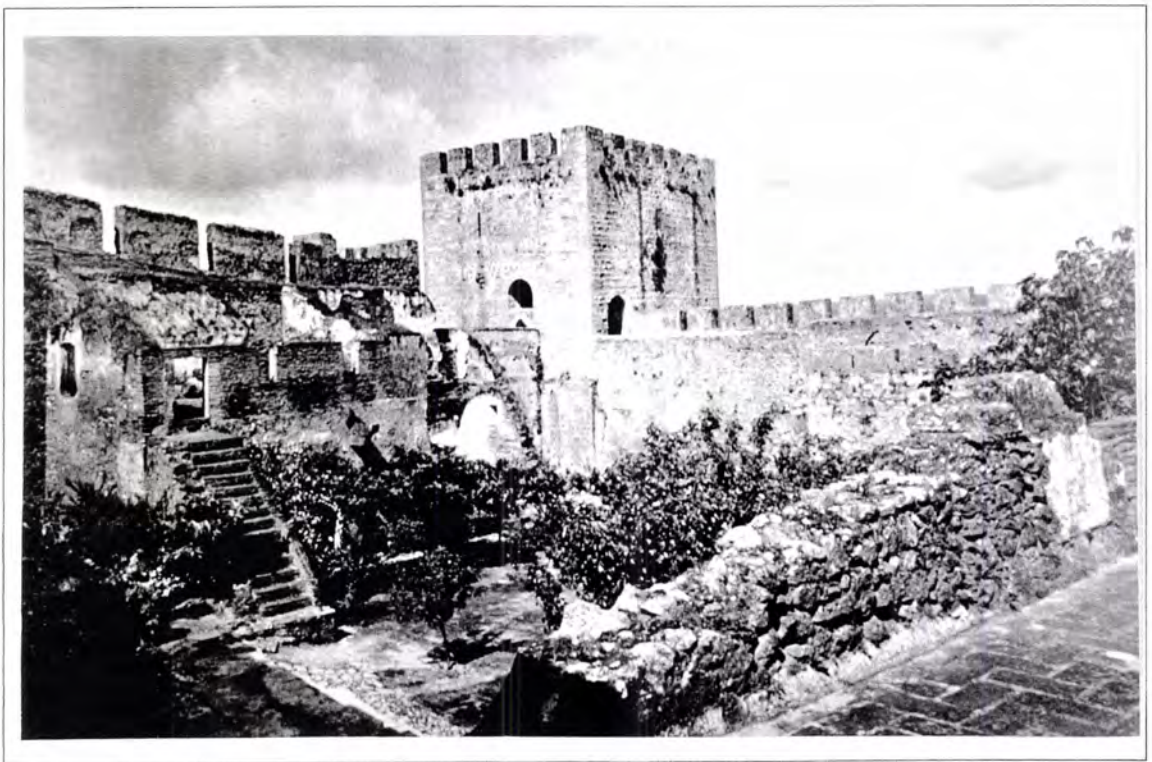
Fig. 6.4.91 - Castelo de Elvas. Edificações do pátio, antes das demolições efectuadas durante a intervenção (1940-1948) (foto DGEMN)
