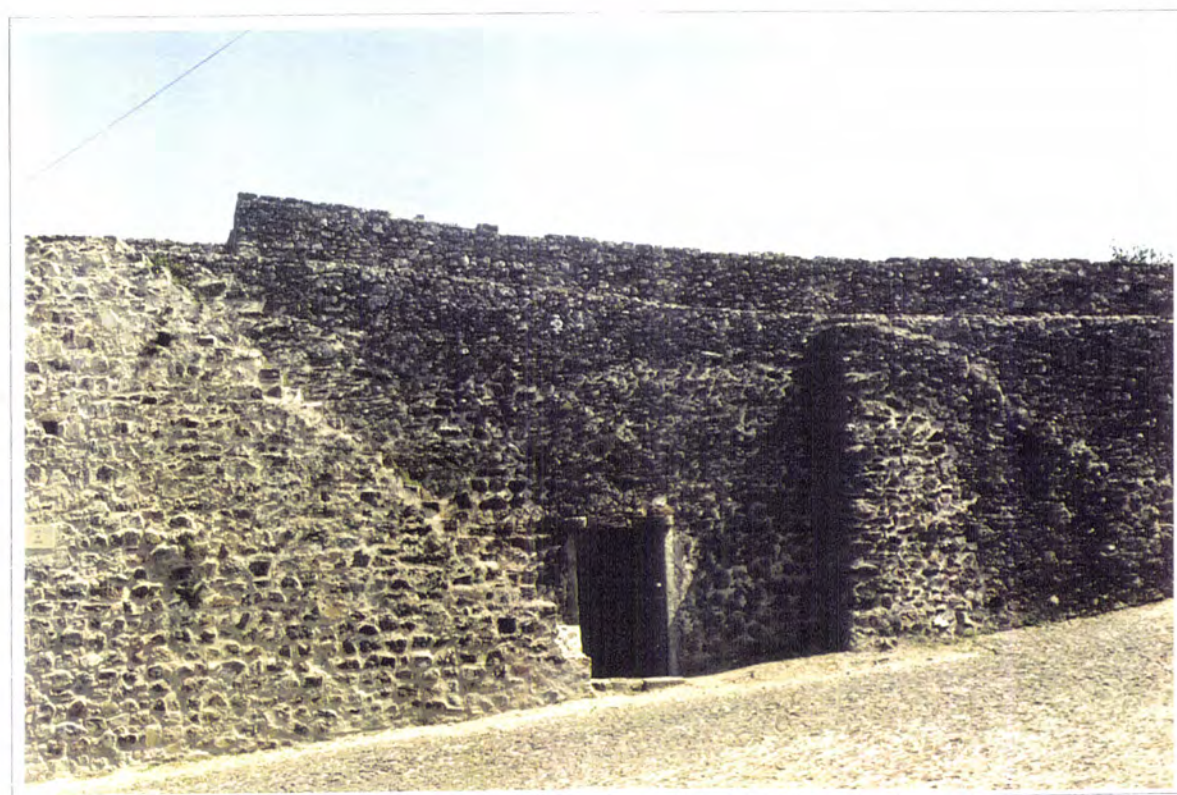
Fig. 6.3.32 - Fortificações de Marvão. Postigo do Torrejão e escadas de acesso aos torreões que o ladeiam
