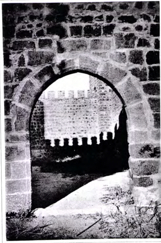
Fig. 6.5.11 - Castelo de Amieira. Porta principal depois da intervenção de 1945 a 1949 (foto DGEMN)
