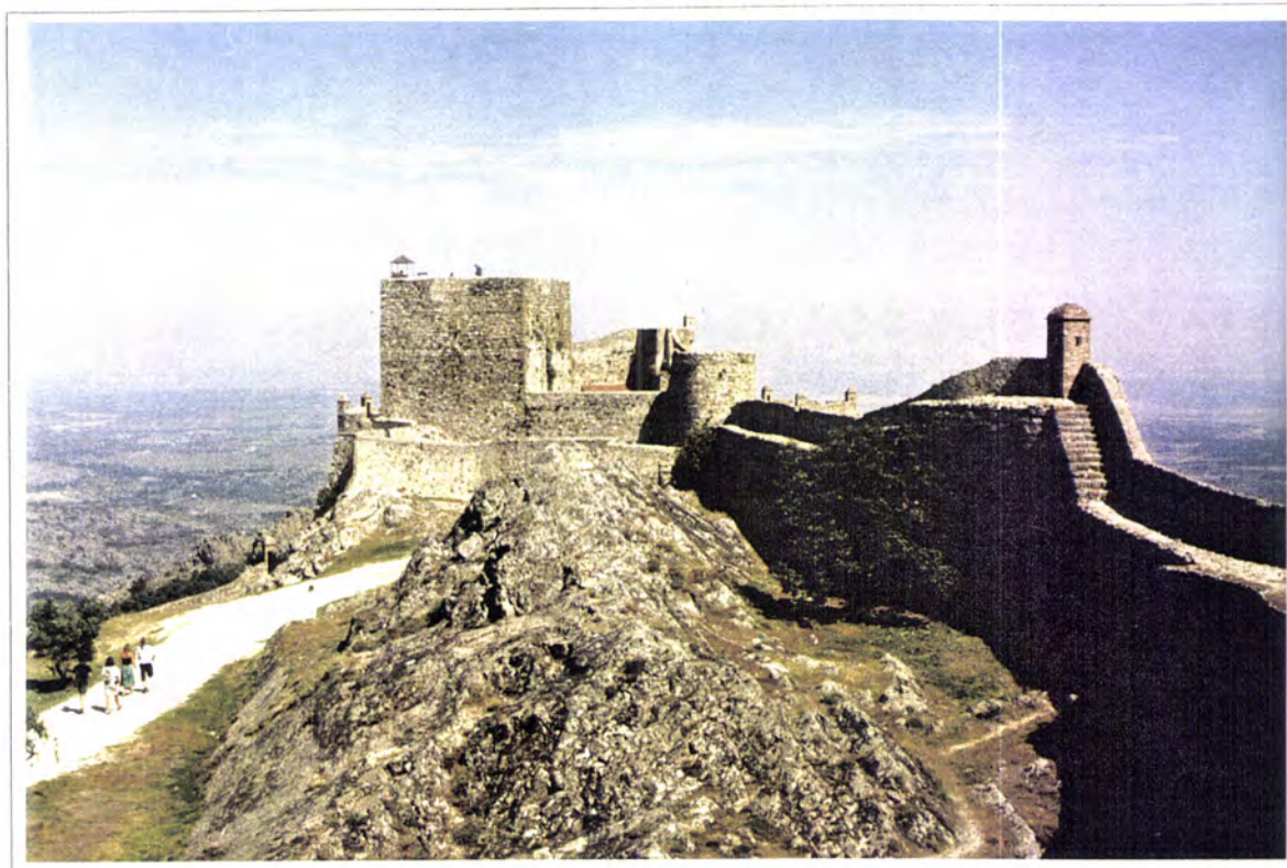
Fig. 6.3.17 - Castelo de Marvão. 1º recinto (albacar). Ao fundo, a entrada para o segundo recinto com a Torre de Menagem em evidência
