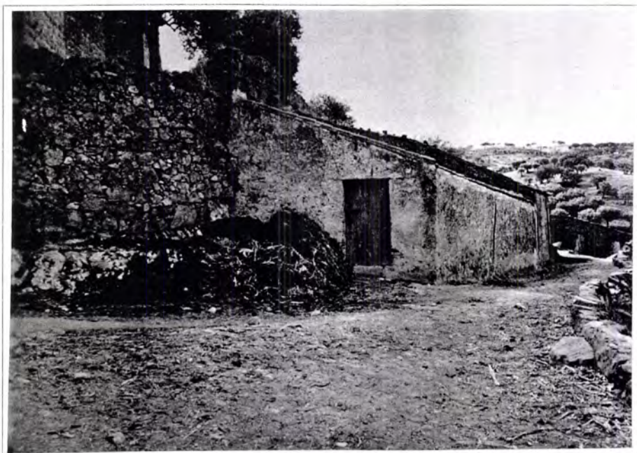
Fig. 6.5.6 - Castelo de Amieira. Barbacã, tramo O, antes da intervenção de 1945 a 1949 (foto DGEMN)
