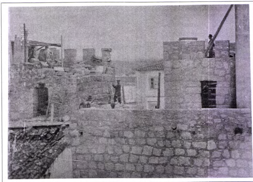
Fig. 6.5.40 - Nisa. Porta da Vila vista de intramuros. Obras de reconstrução (1943/45) (foto DGEMN)
