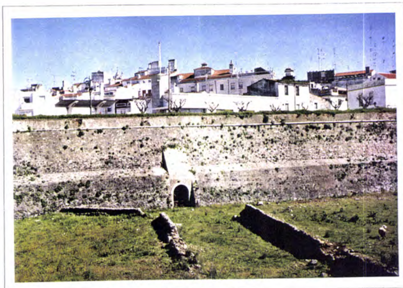
Fig. 6.4.46 - Fortificação abaluartada de Elvas. Cortina com poterna entre o Baluarte de Olivença e o de São João de Deus
