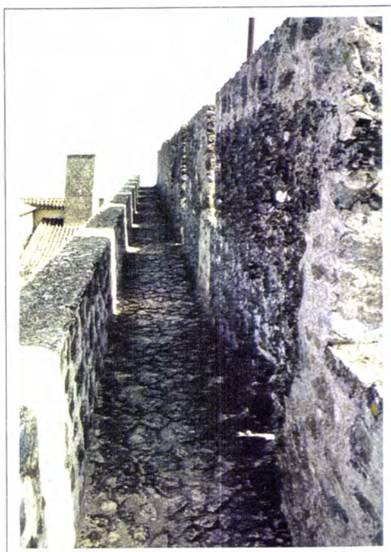
Fig. 6.4.25 - Castelo de Elvas. Adarve NE
