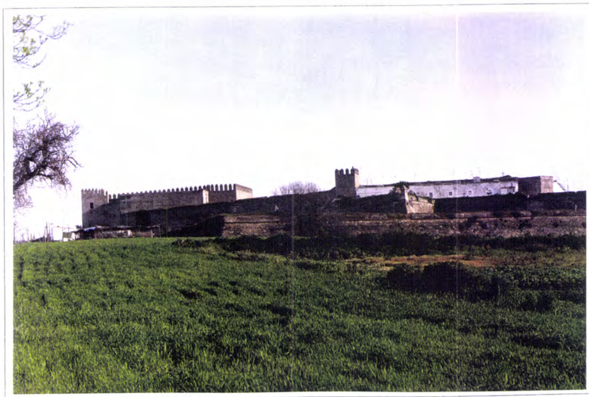
Fig. 6.2.14 - Fortaleza de Campo Maior. Meio baluarte de Lisboa com o revelim que protege a Porta da Vila, em primeiro plano
