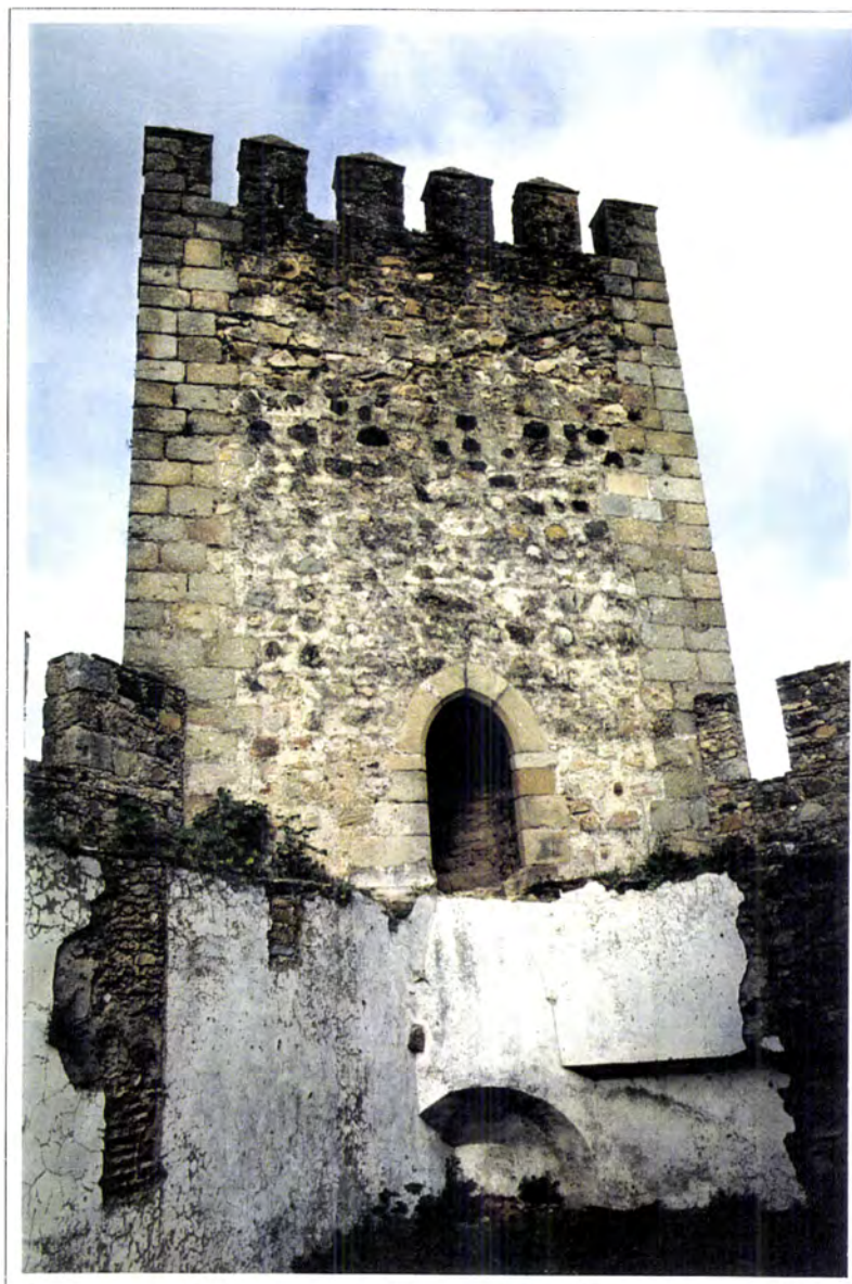
Fig. 6.1.28 - Castelo de Alter do Chão. Topo NE da alcaidaria ao nível do 2º andar
