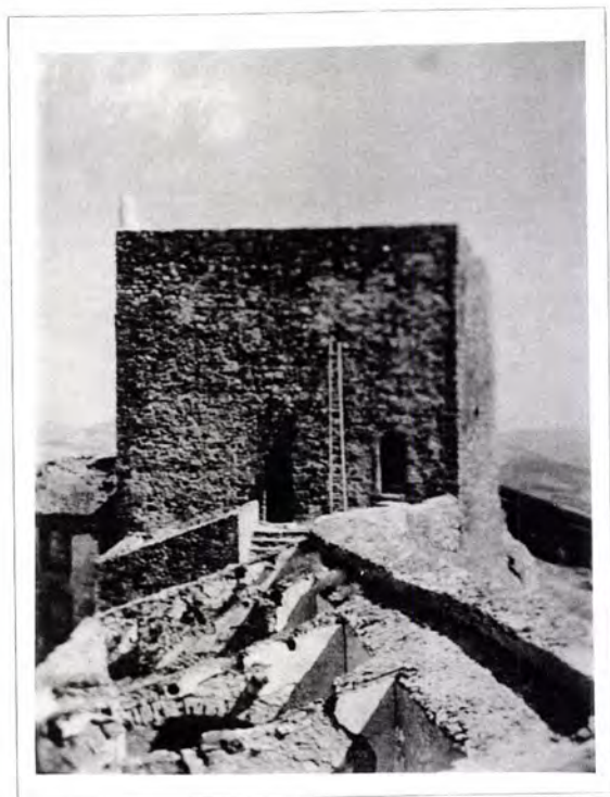
Fig. 6.3.47 - Castelo de Marvão. Segundo recinto. Torre de Menagem antes das intervenções (1938 - década de Quarenta) (foto DGEMN/DREMS)
