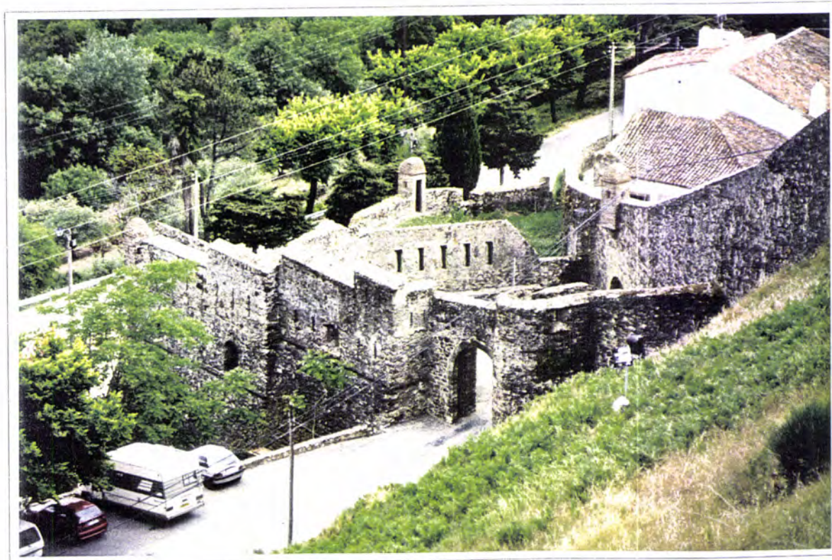
Fig. 6.3.26 - Fortificações de Marvão. Meio baluarte das Portas de Ródão
