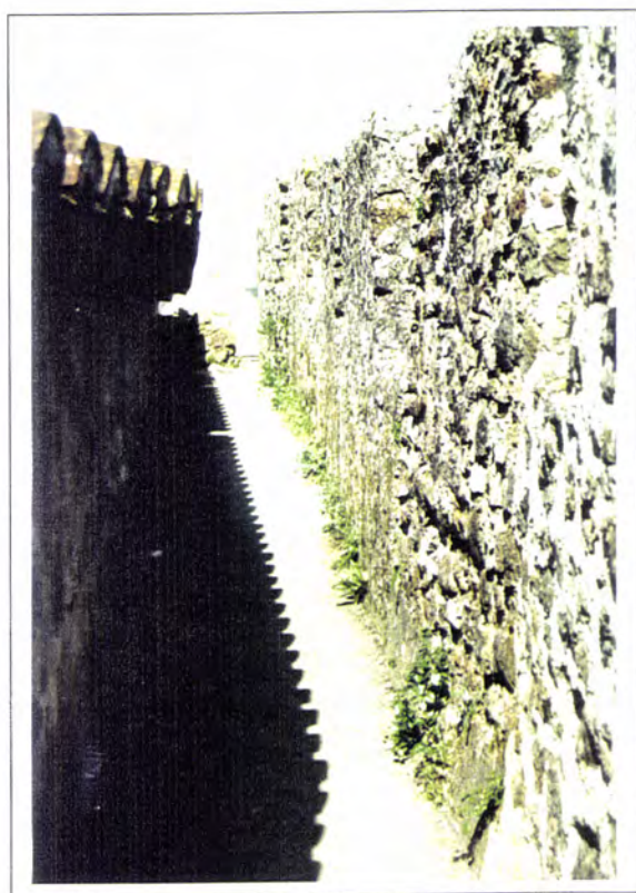
Fig. 6.4.24 - Castelo de Elvas. Adarve SE
