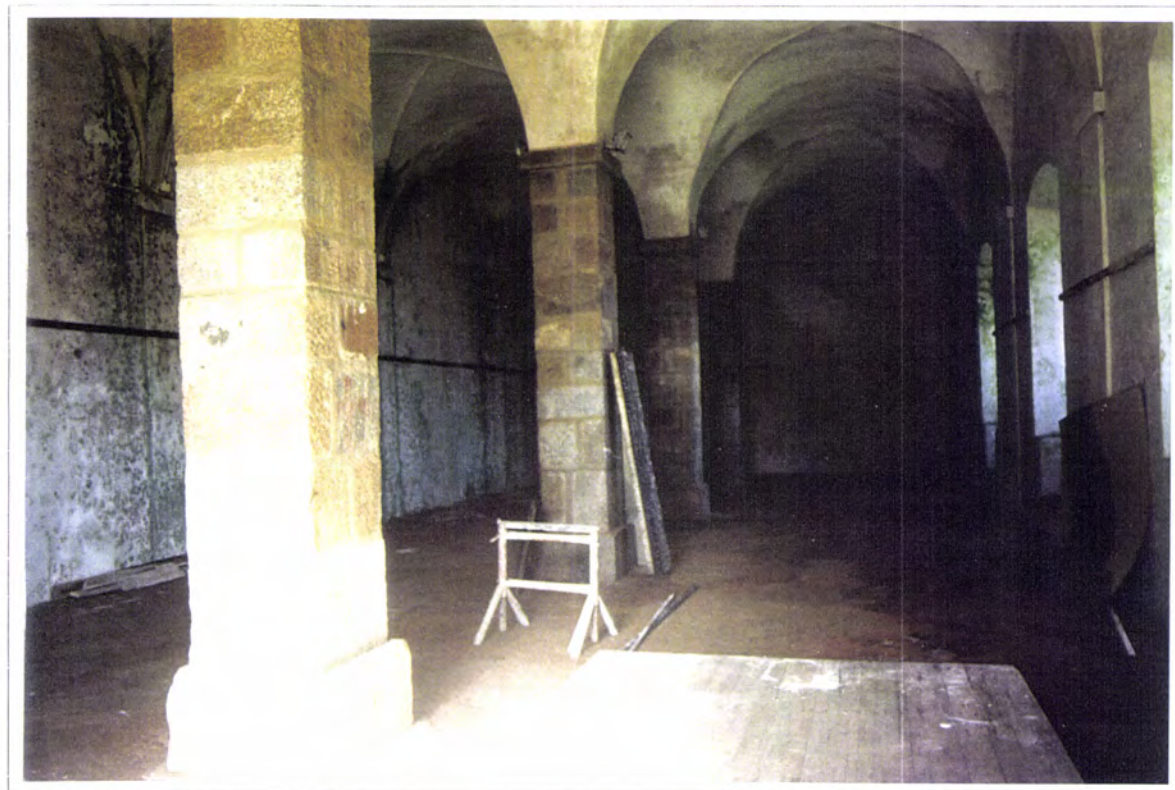
Fig. 6.2.29 - Castelo de Campo Maior. Armazém de víveres encostado ao paramento exterior do tramo NE
