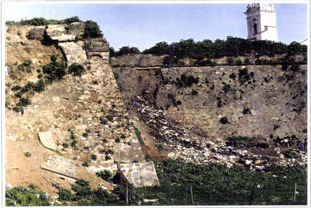
Fig. 6.2.23 - Fortaleza de Campo Maior. Meio baluarte de São Sebastião e cortina. Lixeira
