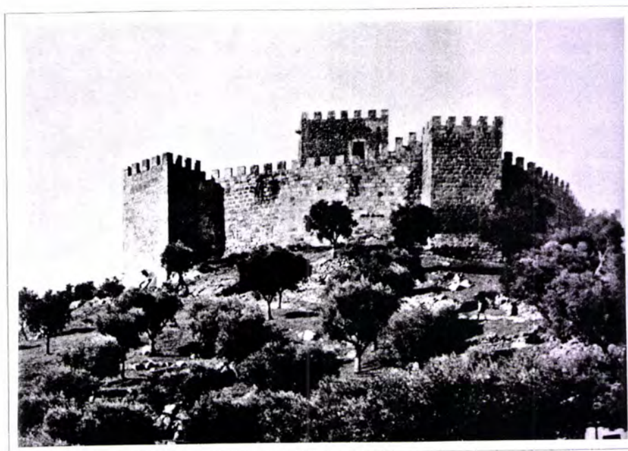
Fig. 6.5.17 - Castelo de Belver. Tramo E depois das intervenções de 1935 a 1946 (foto DGEMN)
