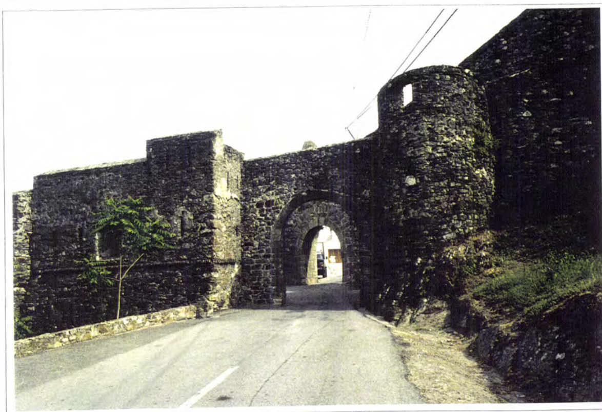
Fig. 6.3.23 - Fortificações de Marvão. Meio baluarte das Portas de Ródão
