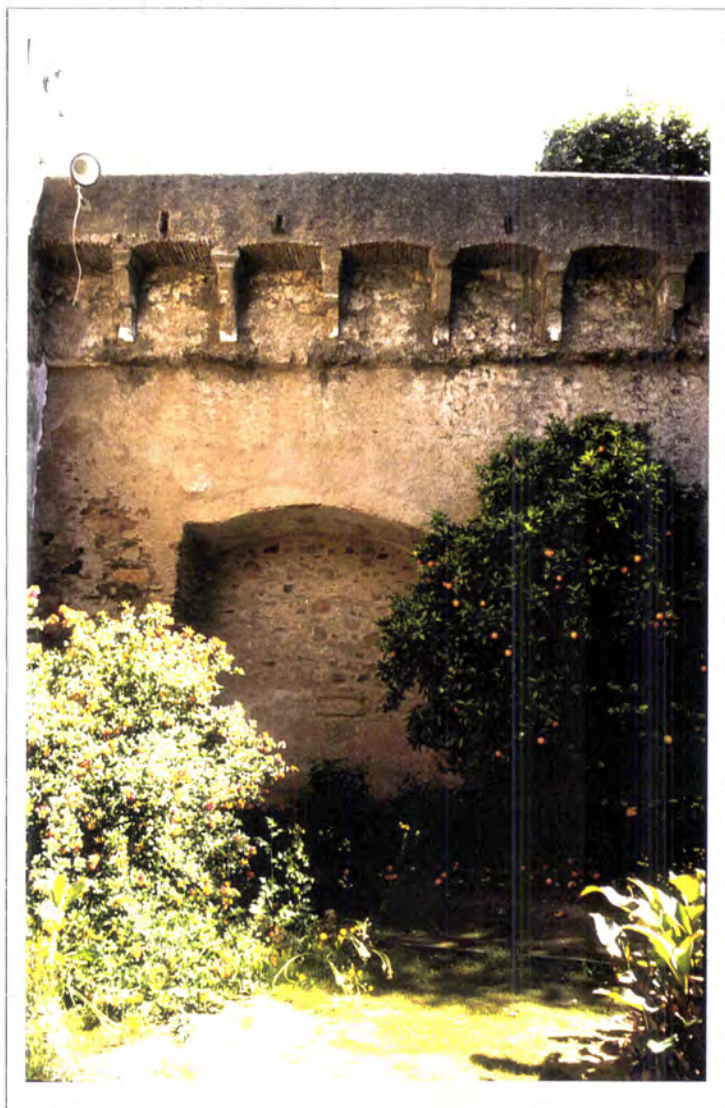
Fig. 6.1.16 - Castelo de Alter do Chão. Muralha NE, paramento
