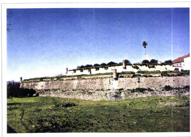
Fig. 6.4.47 - Fortificação abaluartada de Elvas. Baluarte de São João de Deus com cavaleiro
