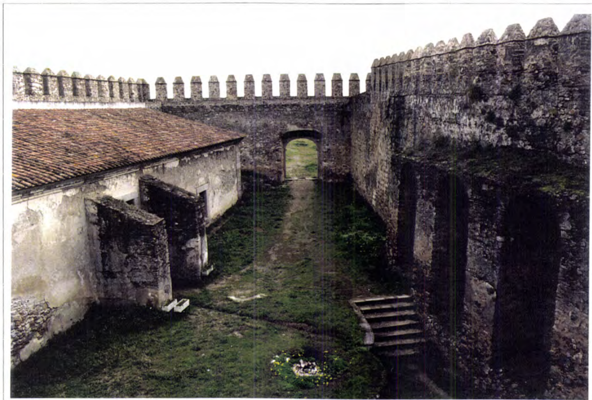
Fig. 6.2.6 - Castelo de Campo Maior. Pátio, vendo-se os contrafortes da muralha S0 que terão servido, simultaneamente, para empilhar balas de canhão
