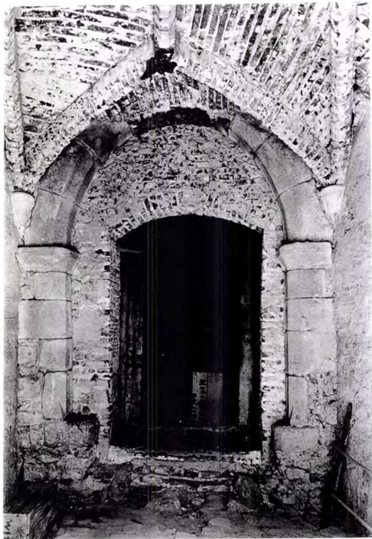
Fig. 6.4.98 - Castelo de Elvas. Alcaidaria. Portal da sala do piso térreo antes das intervenções (1940-1948) (foto DGEMN)
