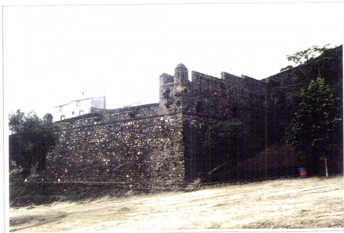
Fig. 6.3.24 - Fortificações de Marvão. Meio baluarte das Portas de Ródão
