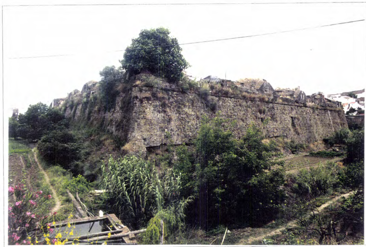
Fig. 6.2.16 - Fortaleza de Campo Maior. Baluarte de Santa Cruz
