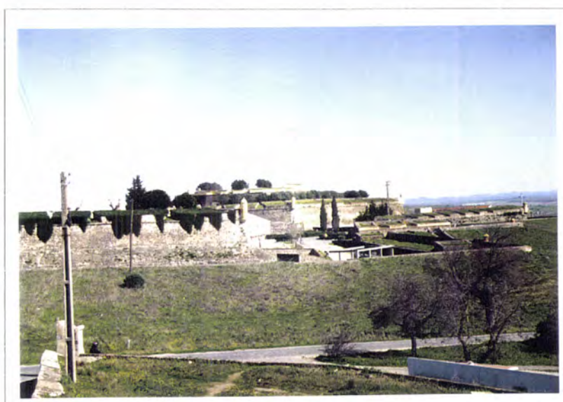
Fig. 6.4.53 - Fortificação abaluartada de Elvas. Obra Coroa
