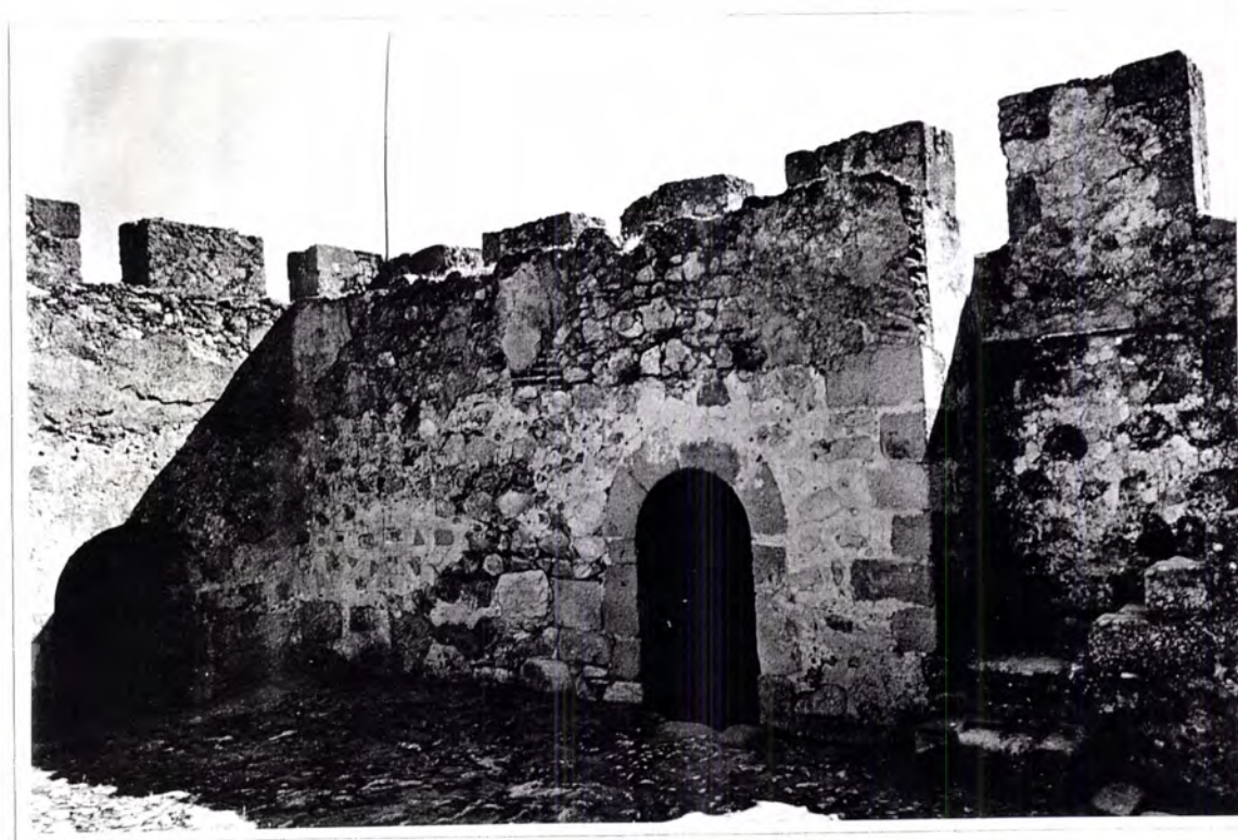
Fig. 6.4.106 - Castelo de Elvas. Eirado da torre de menagem, antes das intervenções (1940-1948) (foto DGEMN)
