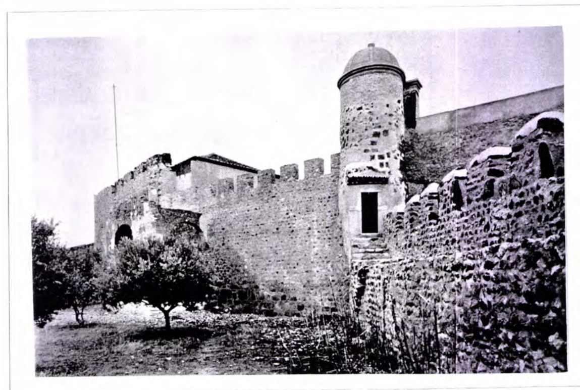
Fig. 6.4.104 - Castelo de Elvas. Quadrela NE, vista do exterior, depois das intervenções (1940-1948) (foto DGEMN)
