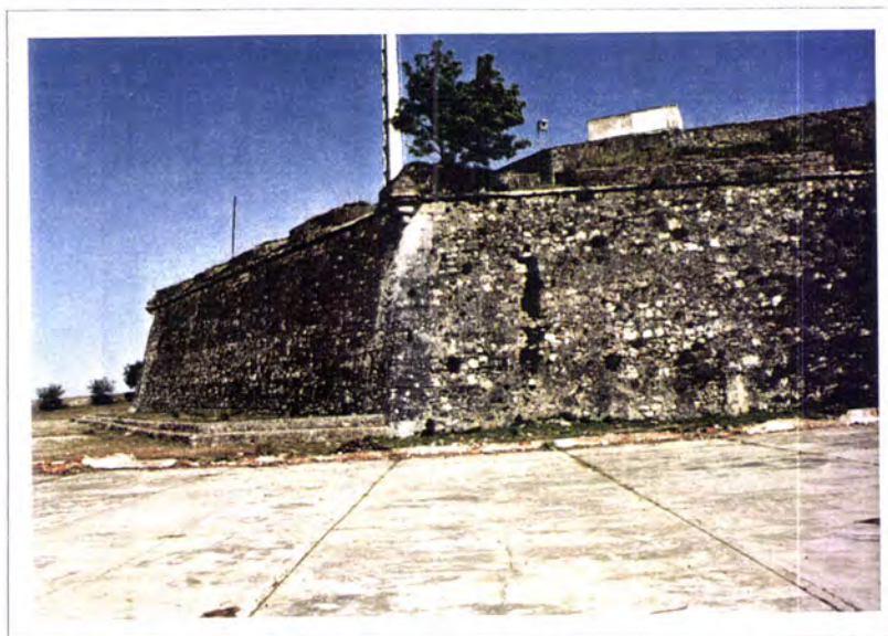
Fig. 6.4.50 - Fortificação abaluartada de Elvas. Meio baluarte do Trem ou do Cesto da Gávea
