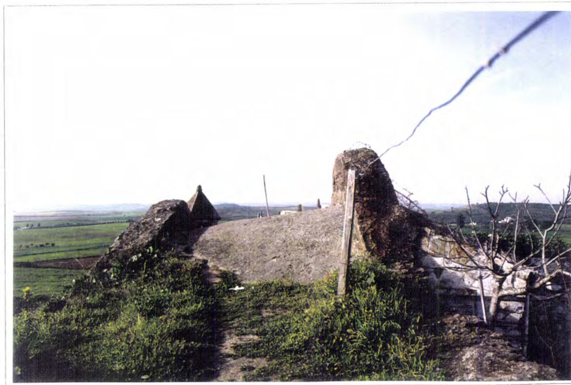
Fig. 6.2.36 - Fortaleza de Campo Maior. Cobertura de uma canhoeira
