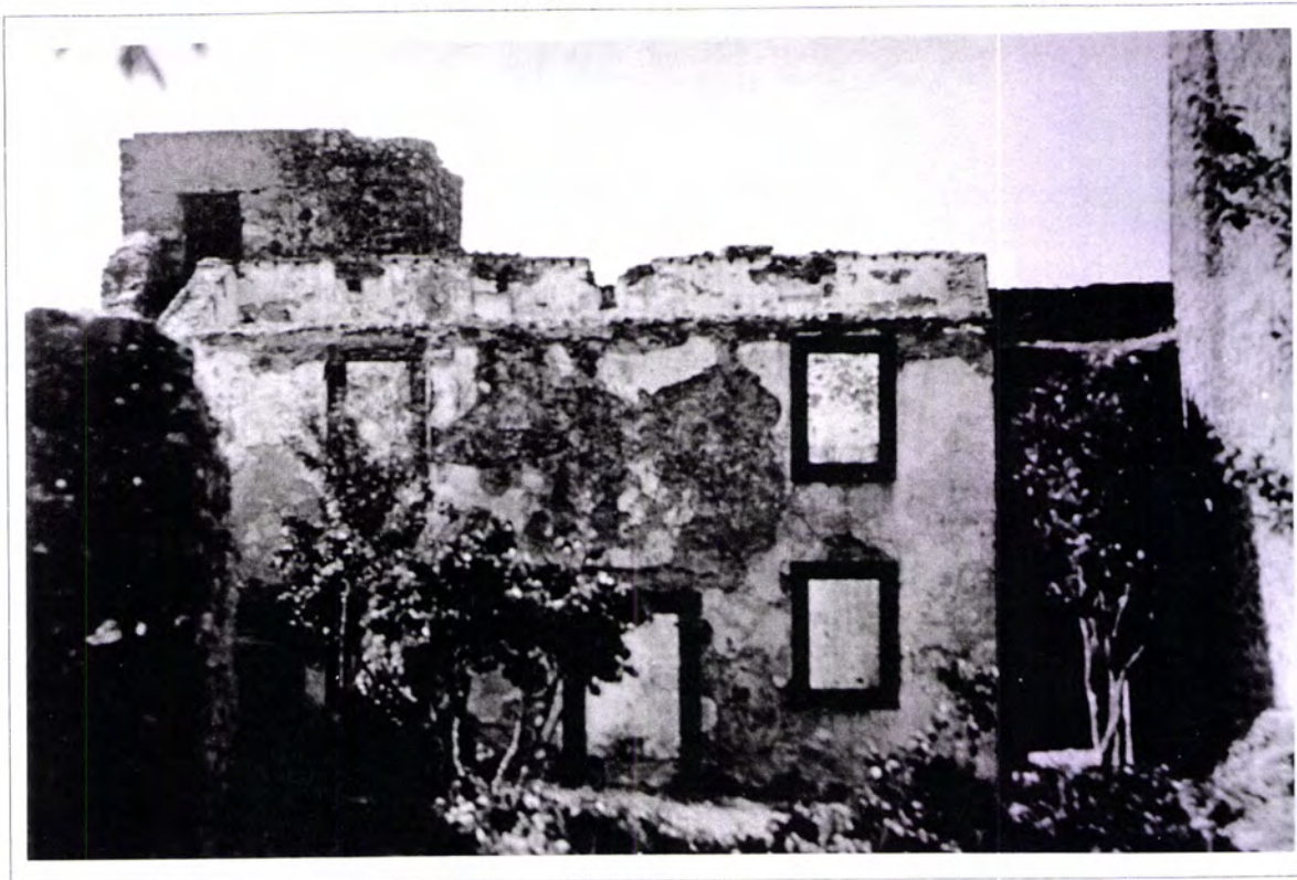
Fig. 6.3.42 - Castelo de Marvão. Segundo recinto, edifício do topo SE. Intervenções (1938 - década de Quarenta) (foto DGEMN/DREMS)
