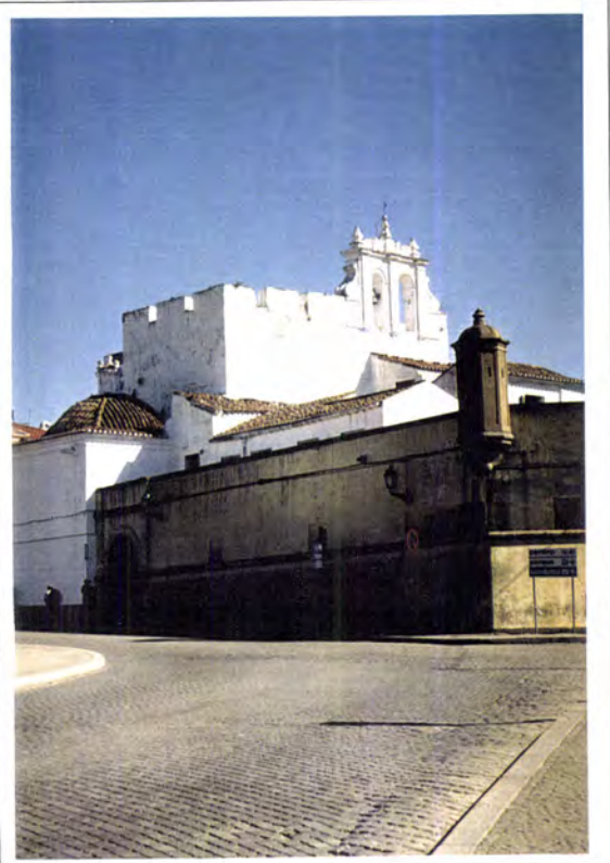
Fig. 6.4.43 - Cerca fernandina de Elvas. Torreão ameado junto ao Baluarte de São João de Deus
