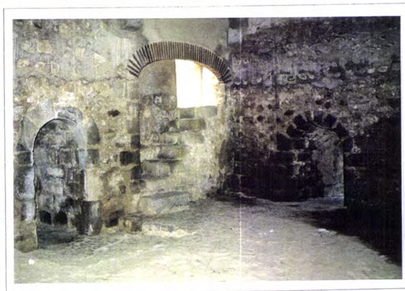
Fig. 6.4.17 - Castelo de Elvas. Torre de menagem. Sala superior. Da esquerda para a direita: entrada, escada para o eirado e seteira.
