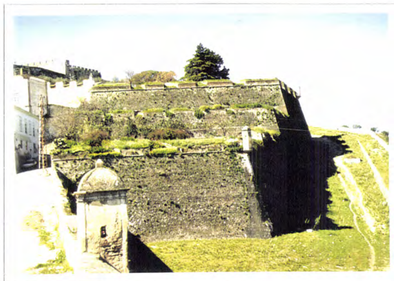
Fig. 6.4.52 - Fortificação abaluartada de Elvas. Meio baluarte de São João da Corujeira
