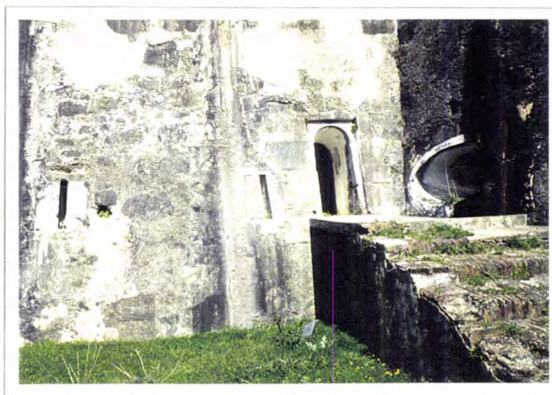
Fig. 6.4.72 - Forte da Graça. Frestas das casernas localizadas na base dos baluartes e das cortinas. Porta de entrada e canhoeira
