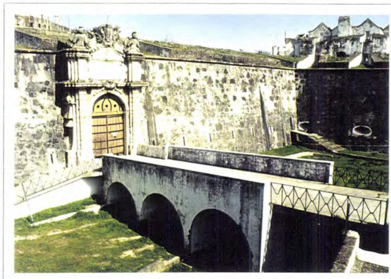
Fig. 6.4.71 - Forte da Graça. Primeiro fosso e porta interior
