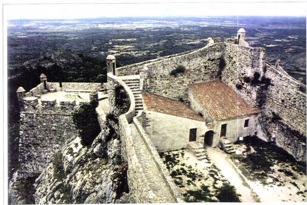
Fig. 6.3.7 - Castelo de Marvão. Pátio do segundo recinto. Fortificação abaluartada
