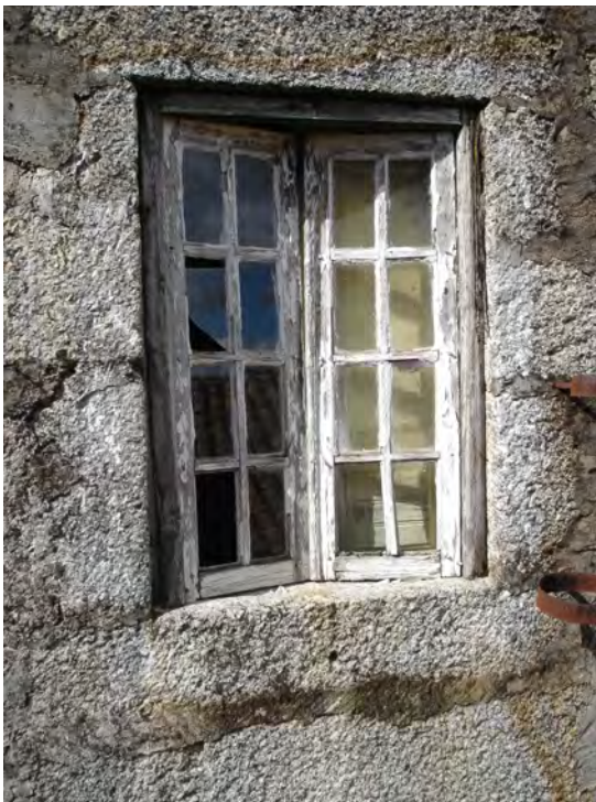
Ilustração 56 - Edifício n.º1 janelas de madeira, deterioradas, desagregação da pintura e vidros danificados ou ausentes (Ilustração nossa, 2012).
