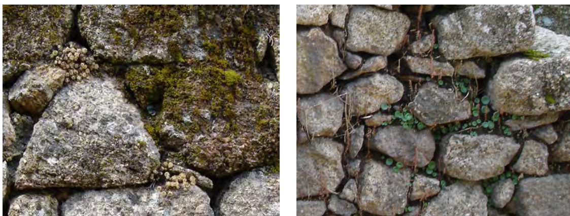
Ilustração 63 - Colonização por plantas superiores (Ilustração nossa, 2012).
