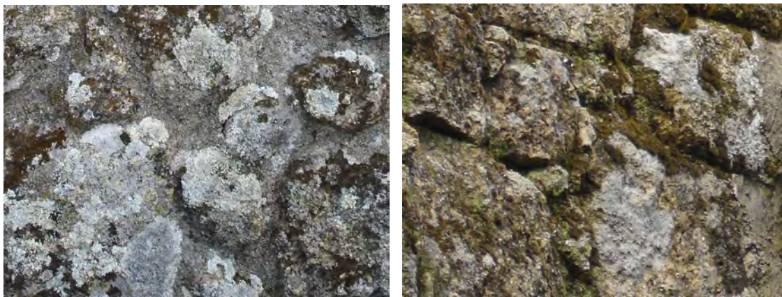
Ilustração 61 - Identificação de colonização por líquenes (Ilustração nossa, 2012).
