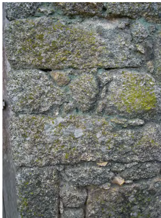
Ilustração 60 - Edifício n.º2 Colonização biológica na alvenaria de pedra (Ilustração nossa, 2012).
