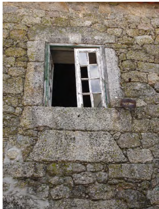
Ilustração 56 - Edifício n.º1 janelas de madeira, deterioradas, desagregação da pintura e vidros danificados ou ausentes (Ilustração nossa, 2012).
