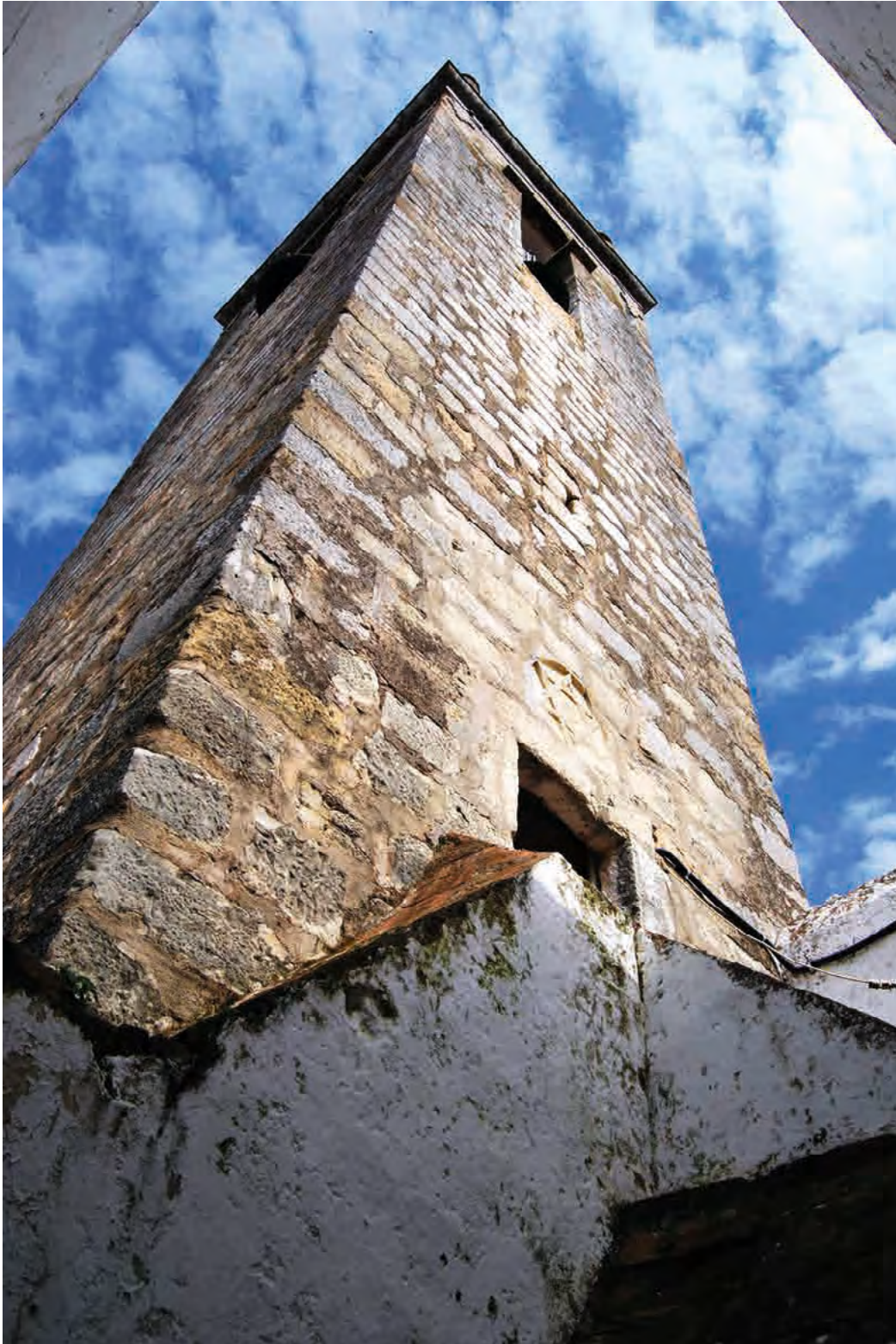
Fig. 7 – Torre da Igreja Matriz.
