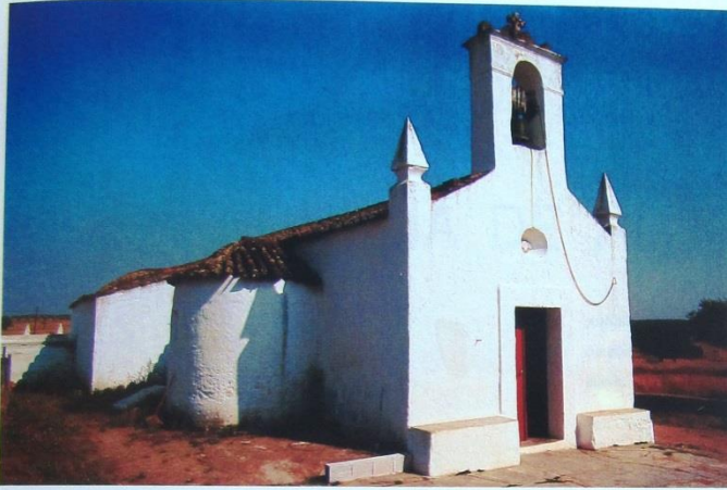
Vista geral da Igreja
