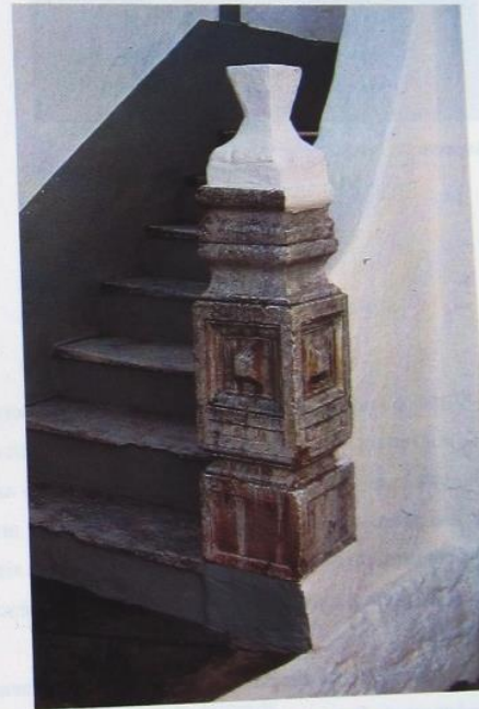
Pormenor da Guarnição da Escadaria
