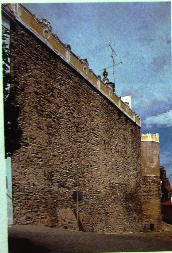
Pano da Muralha na Zona do Primitivo Castelo
