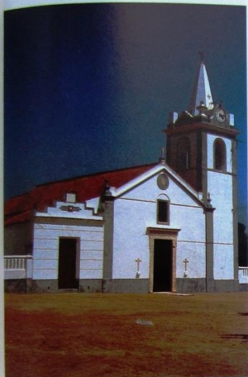
Vista geral da Igreja
