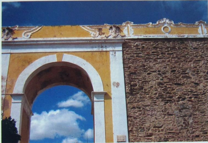
Pormenor dos Estuques da Porta do Adro
