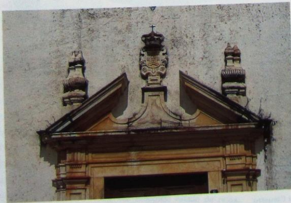
Pormenor da Cimalha do Portal
