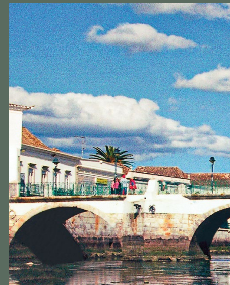
Ponte antiga sobre o rio Gilão (CMT)
