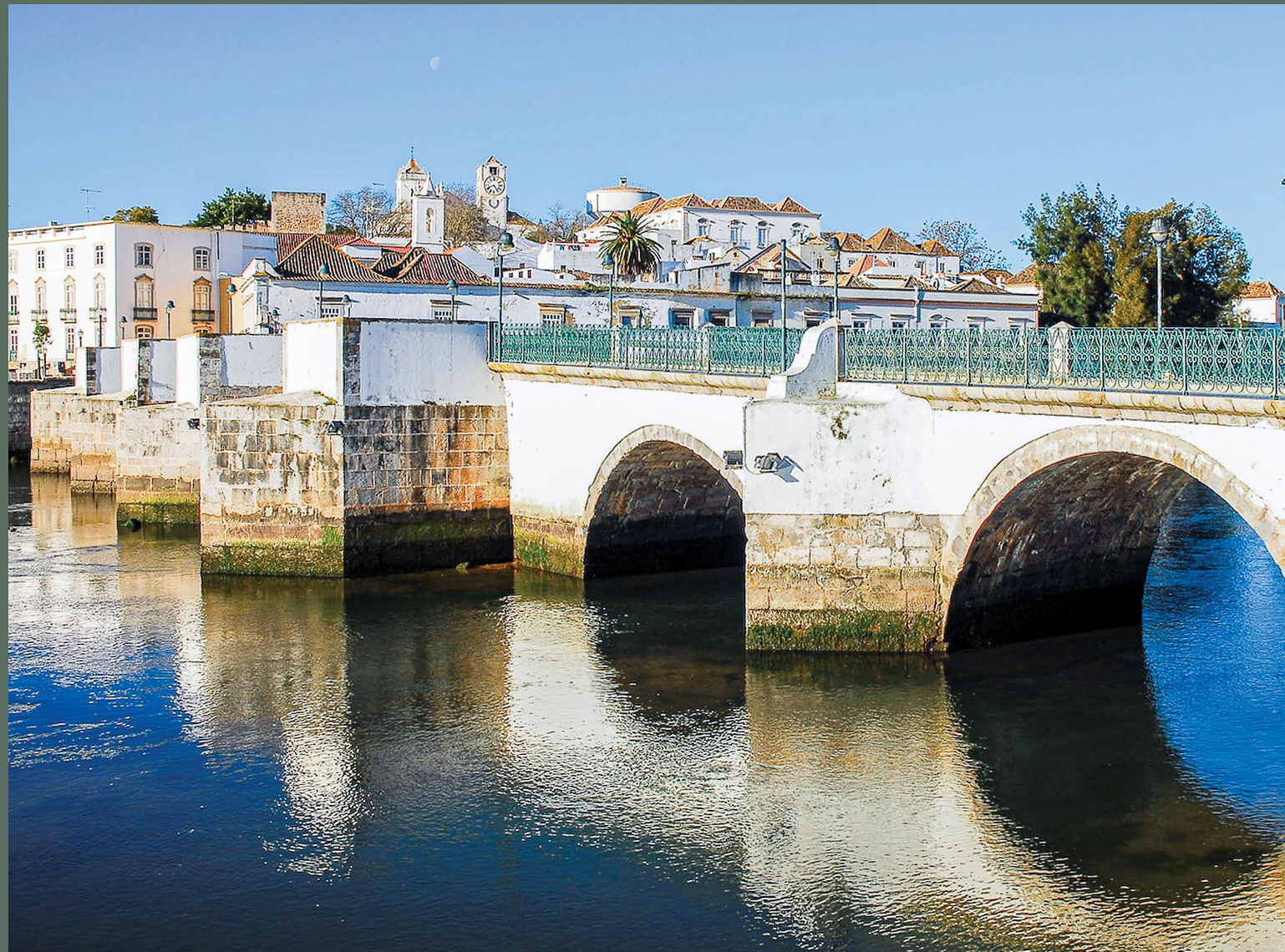
Ponte antiga sobre o rio Gilão (CMT)
