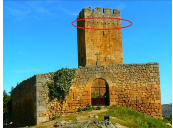
Figura 27 – Orifícios para a fixação do hurdício. Castelo de Longroiva. Adaptada do site [19]
