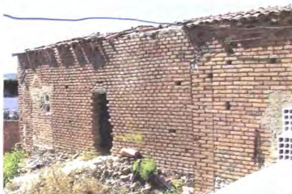
Figura 38 - Parede em tijolo maciço, rua Nova das Hortas nº 9
