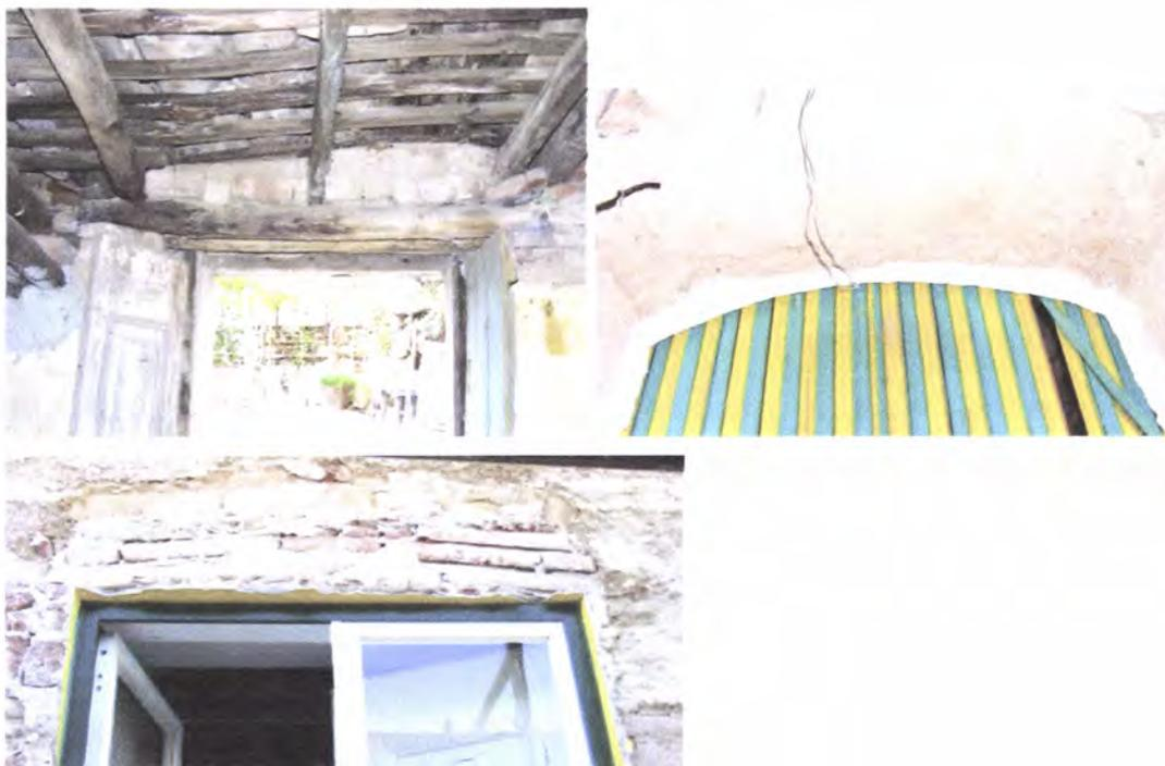
Figura 73 – 1, 2 e 3; Lintel de madeira, rua 25 de Abril, nº 32; porta escavada na parede, rua Luís Vaz de Camões, nº 38; e folha de tijolo num arco de janela, largo Visconde da Ribeira Brava, nº 21
