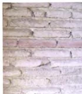
**Figura 175 - Paredes lateral de casão em adobe com uma fiada de tijolo, adossados com argamassa de barro, rua do Fojo, nº 6**
