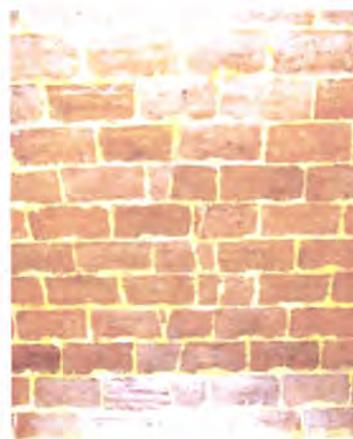
**Figura 105 - Fechamento das fiadas da abobadilha com cunha de tijolo, largo D. Violante**
