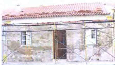
**Figura 207 - Substituição de telhado e de revestimento exterior, largo Visconde da Ribeira Brava, nº 21**
