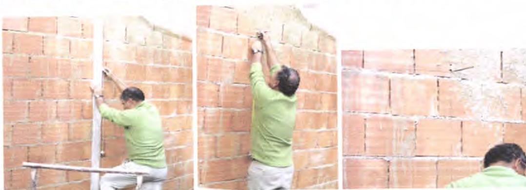
**Figura 101 - 1, 2 e 3: Sr. Manuel Francisco Fialho a exemplificar a marcação da flecha da abobadilha**
