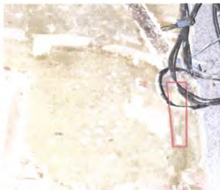
**Figura 170 - Tijolo na junta vertical, largo Visconde da Ribeira Brava, nº 8**
