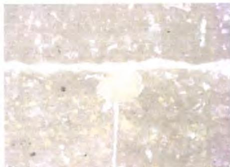
**Figura 167 - Parede de taipa com cintamento e junta vertical de areia e cal, rua SottoMayor Figueira, n° 19**
