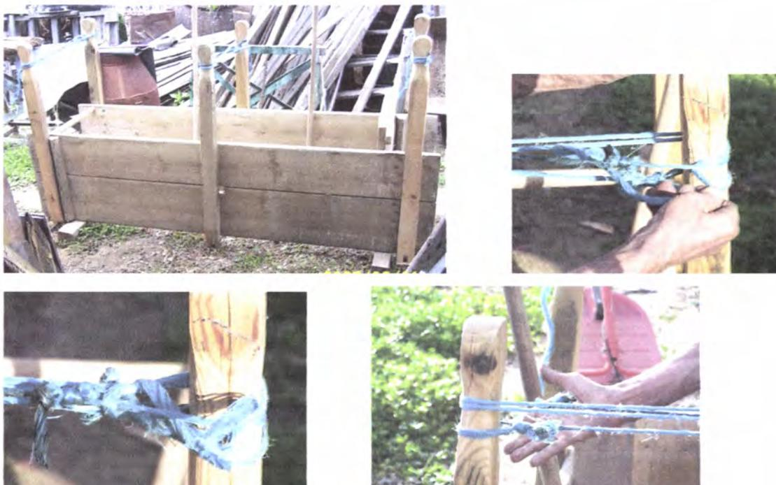
Figura 59 – 1, 2, 3 e 4; Costeiros e processo de os atar na parte superior
