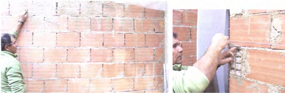
**Figura 102 – 1 e 2; Sr. Manuel Francisco Fialho a exemplificar a marcação do ponto intermédio para a marcação da volta da abobadilha e a marcar a volta da abobadilha**
