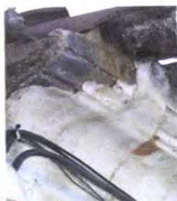
**Figura 195 - Sobreposição de camadas de cal de diferentes cores, rua da Boavista, nº 23**
