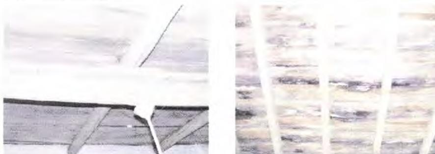
Figura 212 – 1 e 2; Cobertura com infestação de insectos e aberturas entre as ripas por retracção da madeira, rua dos Gregos nº 9, e cobertura com humidades, bolores e apodrecimento da madeira, rua da Guarda, nº 43
