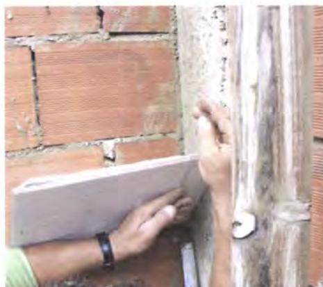
**Figura 104 - Sr. Manuel Francisco Fialho a exemplificar como se utiliza o cintel do intradorso para corrigir a abobadilha**
