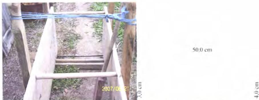
Figura 54 - 1 e 2; Posição dos côvados no taipal e com as suas dimensões
