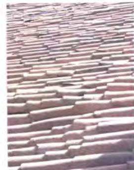
**Figura 39 - Telhado de telhas de canudo, largo Visconde da Ribeira Brava, n.º 21**
