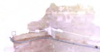
**Figura 176 - Parte inferior de uma paredes lateral interior em tijolo, encimado por adobe, rua de S. João, nº 3**
