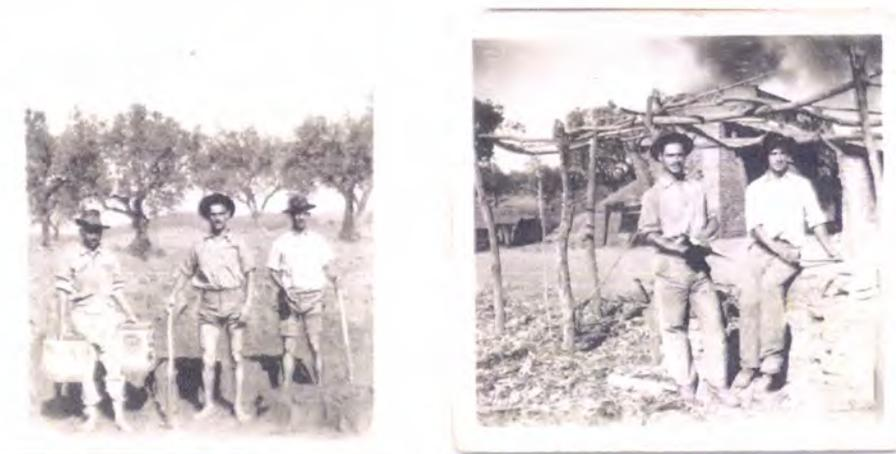
**Figura 85 - 1 e 2;** Sr. Francisco Batuca e os irmãos no telheiro dos Pisões a amassar o barro com as latas e as enxadas e no poial com a pedra, os galápios (nas mãos do irmão e no chão) e a rasoira (mãos do Sr. Francisco, à direita nas fotos); forno de cozer tijolo a fumegar ao fundo
