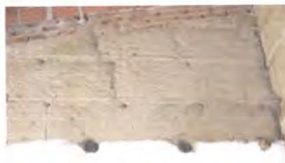
**Figura 177 - Paredes de adobe na parte inferior, taipa na intermédia e tijolo na superior de ligação com o telhado, rua de S. João, nº 3**
