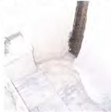
**Figura 210 - Degradação dos revestimentos interiores devido a eflorescências e criptoflorescências. rua da Boavista, nº 34**
