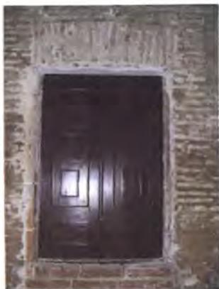
**Figura 182 - Ombreira de tijolo ao cutelo e perpendicular e arco abatido, largo Visconde da Ribeira Brava, nº 8,**
