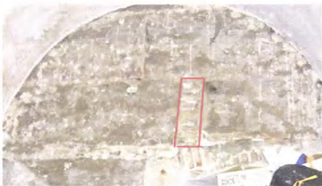
**Figura 169 - Tijolo na junta vertical, rua SottoMayor Figueira, nº 19**
