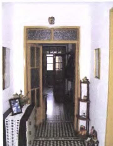
**Figura 193 - Corredor com pavimento de ladrilhos de cimento prensado, rua do Fojo, nº 6**
