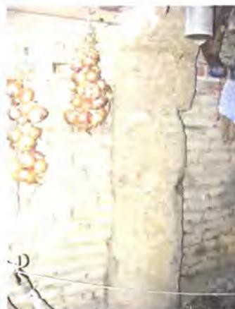
**Figura 69 - Parede interior lateral em adobe ligada à parede estrutural do meio, rua do Fojo, nº 6**
