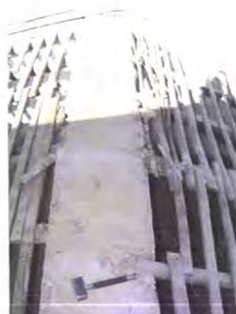
**Figura 107 - Telhado de duas águas de ripa-de-salto-de-rato, largo Visconde da Ribeira Brava nº 21**
