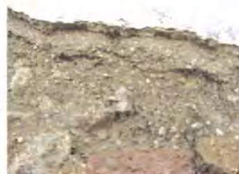
**Figura 196 - 3 camadas de reboco e caiação: barro e areia e cal, muro da rua dos Gregos/ tv. do Beco**
