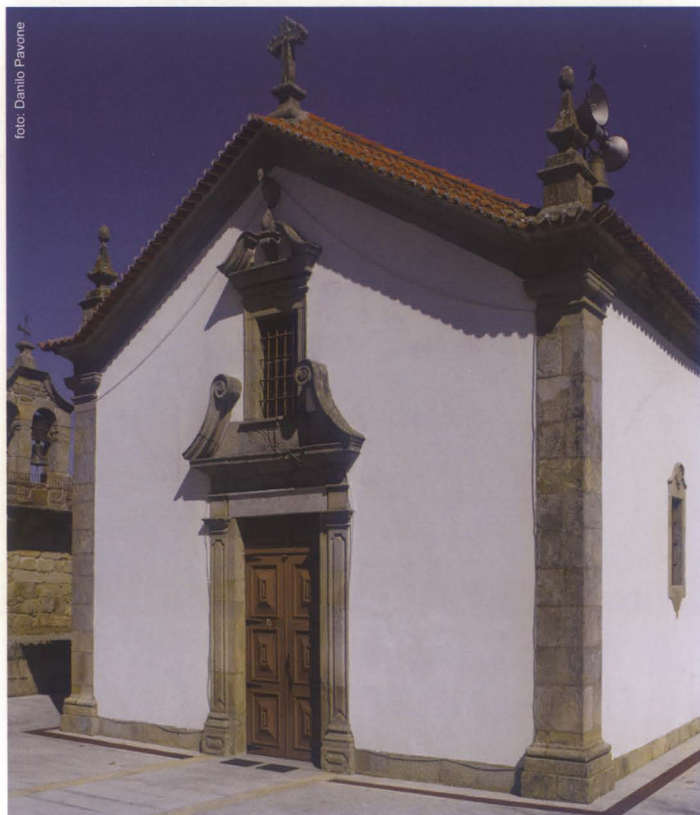
Fig. V - Fachada principal da Igreja de Santa Maria de Açores
