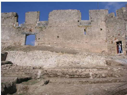
Fig. 212 – Barbacã após a intervenção de restauro.
