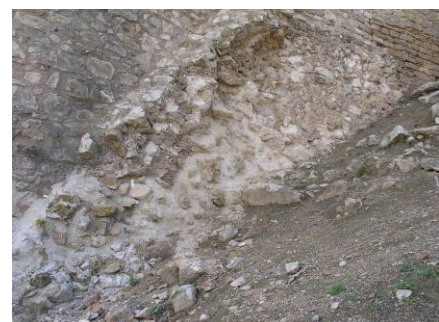
Fig. 221 – Fundações da zona norte do torreão.
