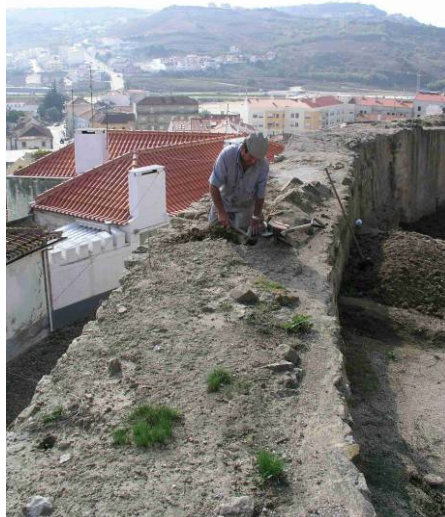
Fig. 222 – Limpeza e capeamento da muralha.
