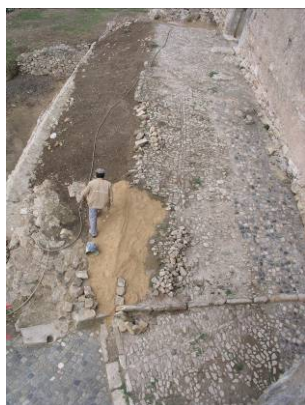
Fig. 214 – Recuperação da calçada.
