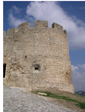
Fig. 218 – Torreão após intervenção.
