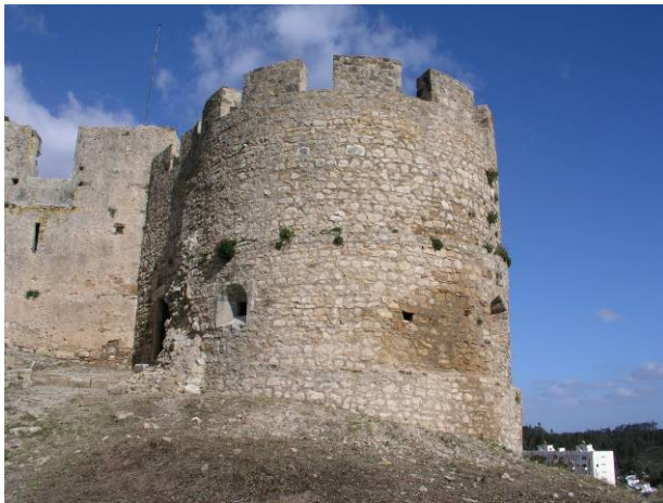
Fig. 217 – Torreão antes da limpeza e consolidação.
