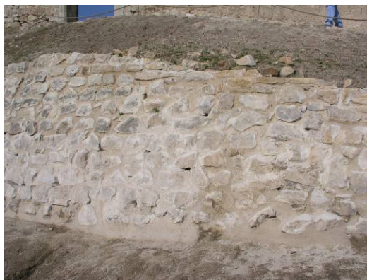
Fig. 213 – Pormenor do trabalho de consolidação.
