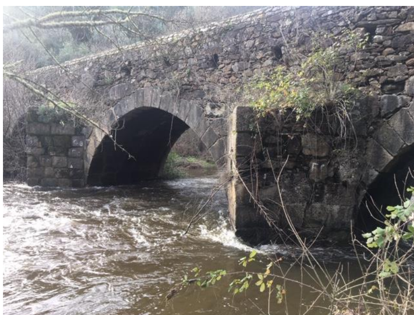
Figura 36 - Pormenores da Ponte 2
