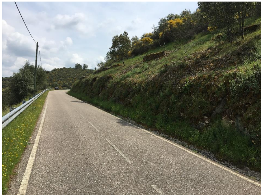
Figura 38 - Estrada construída por cima das Muralhas Exteriores
