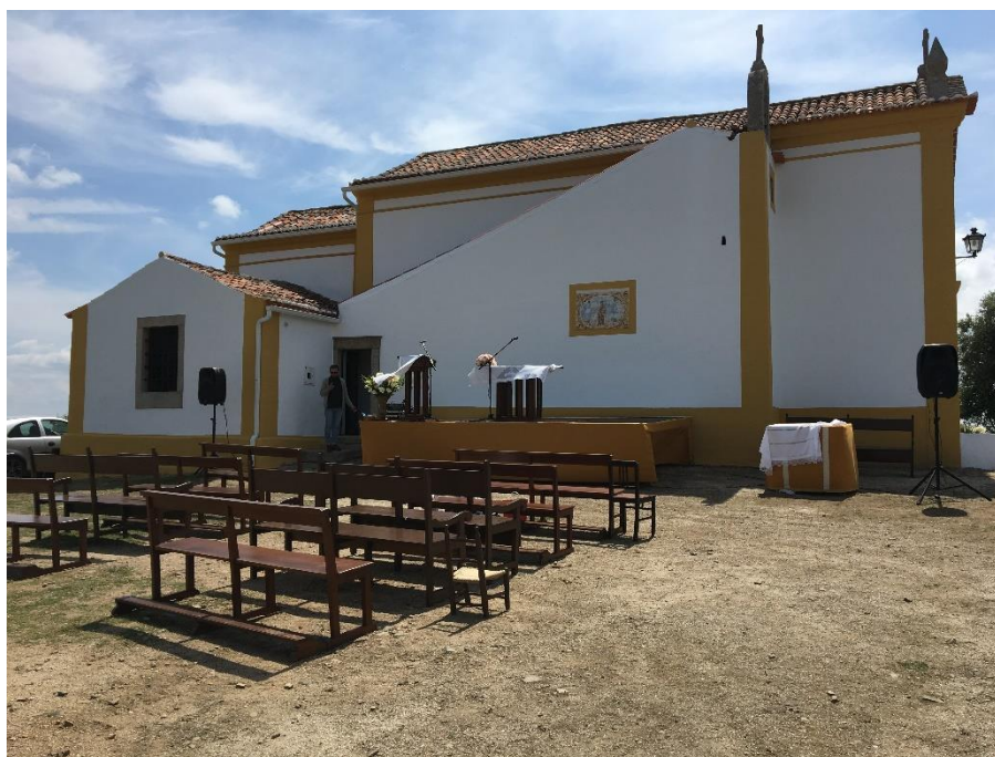
Figura 51 - Vista lateral da Capela
