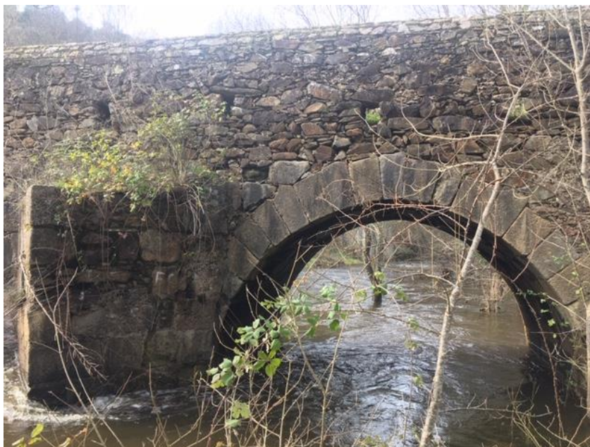
Figura 35 - Pormenores da Ponte 1
