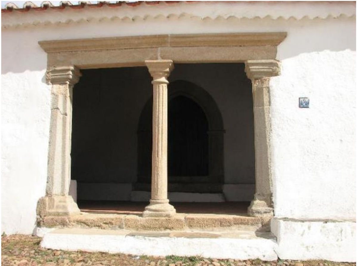
Figura 22 - Colunas à entrada da capela nossa sra. dos prazeres
