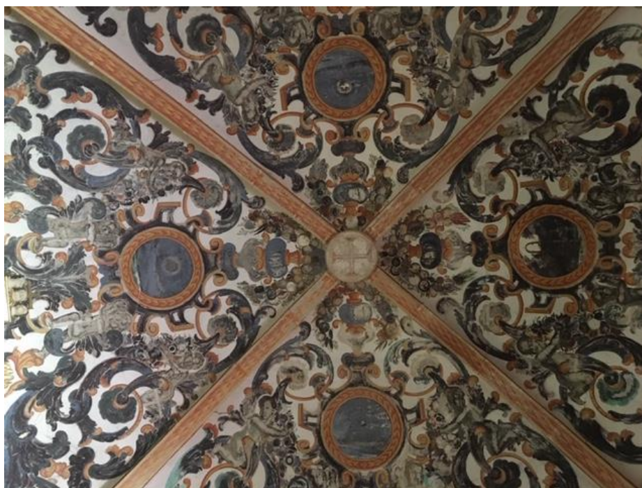
Figura 24 - Tecto da capela Nossa Senhora dos Prazeres
