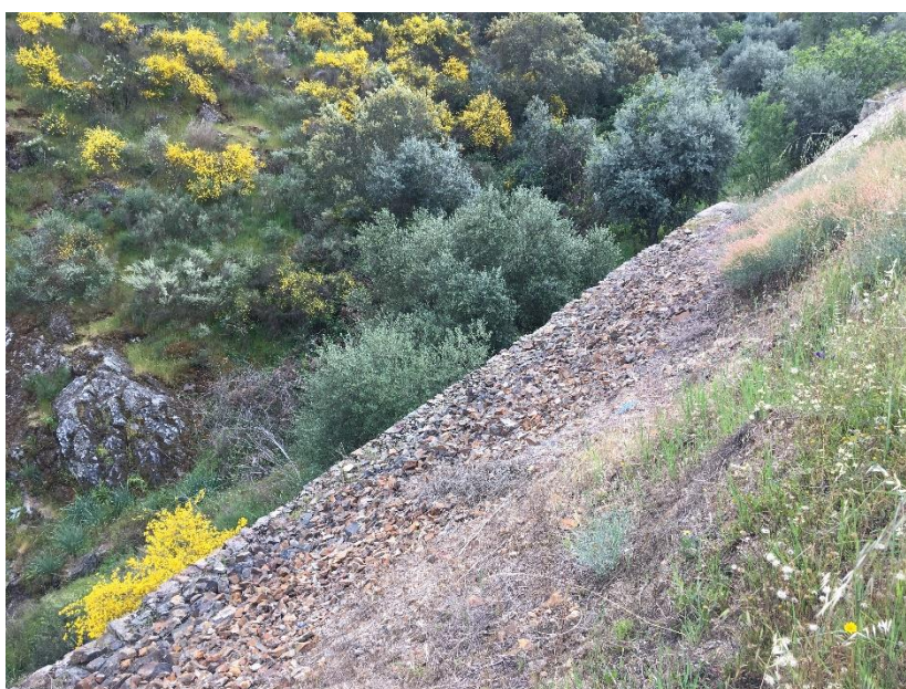
Figura 40 - Pormenor da Muralha Exterior
