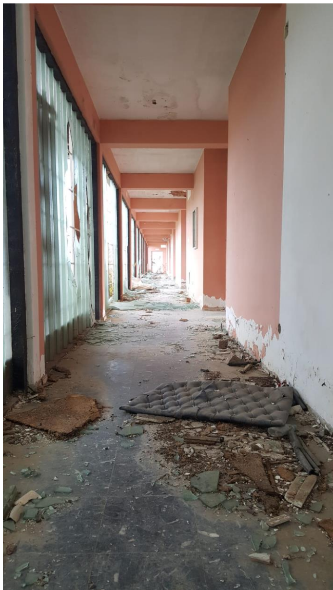
Figura 32 - Corredor de acesso aos quartos
