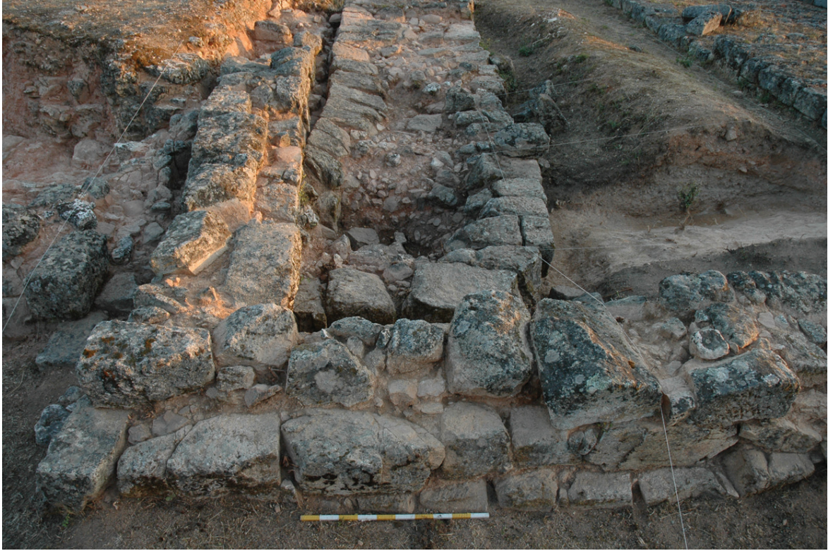
Figura 10 –Muro de armazém Setecentista Norte sobre a torre de menagem medieval.
