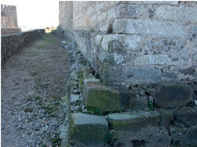
Fig. 5. Pormenor da sapata escalonada, no canto nordeste da torre de menagem.
