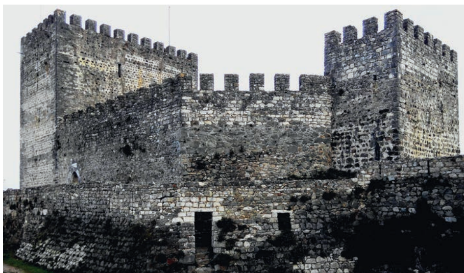
Fig. 19. "Último reduto" do Castelo de Leiria. Registo após intervenção da DGMN, atualidade.
