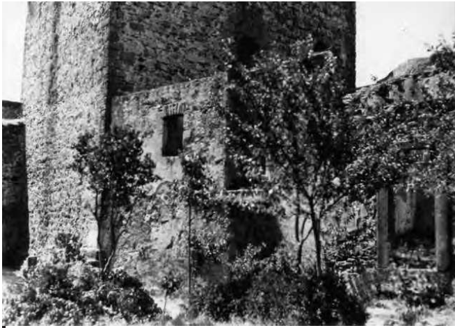
Fotografia documentando a existência de um paio que se encontrava adossado à Torre de Menagem (SIPA FOTO.00167006, 1942)
