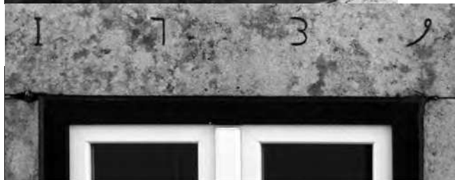
Janela sul do 1º andar da Rua do Espírito Santo n.º 1, com a datação insculpida no lintel (1739)
