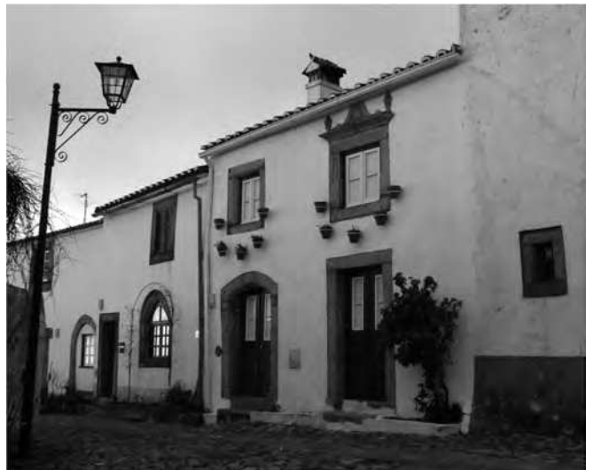
As mesmas fachadas na actualidade; a janela de arco quebrado foi aberta pela família Gil, actual proprietária da casa, há cerca de 30 anos, no antigo vão da porta da “loja” e com pedras existentes no edifício, muito embora o lintel original da referida porta fosse “redondo” e tenha desaparecido quando o vão foi fechado
