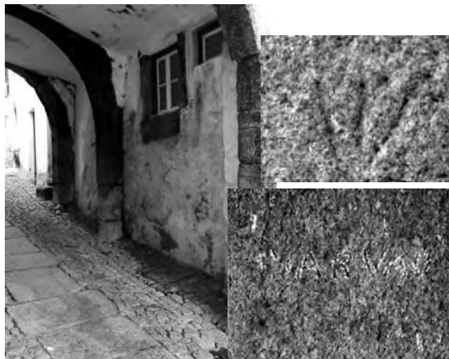
A janela do rés-do-chão onde esteve refugiada uma família espanhola em 1941. Ao lado, a marca de um canteiro que aparelhou as pedras do primeiro tramo do arco (sul), o que pode fazer recuar a sua datação até ao séc. XVI; pelo menos este tramo sul já existia em 1765, parecendo ter sido ampliado até 1814 (confrontar plantas; o último arco, norte, não tem marcas de canteiro). Na jamba nascente do arco central está escrita a palavra Marvão
