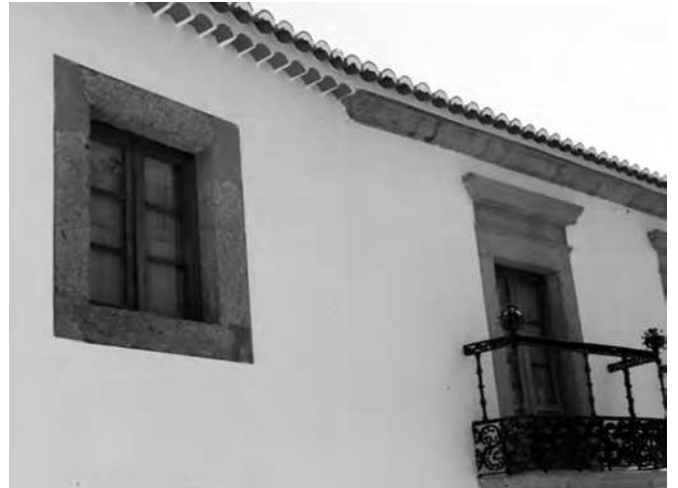
Beirado com uma fiada de telhas e em pedra (Rua do Espírito Santo)
