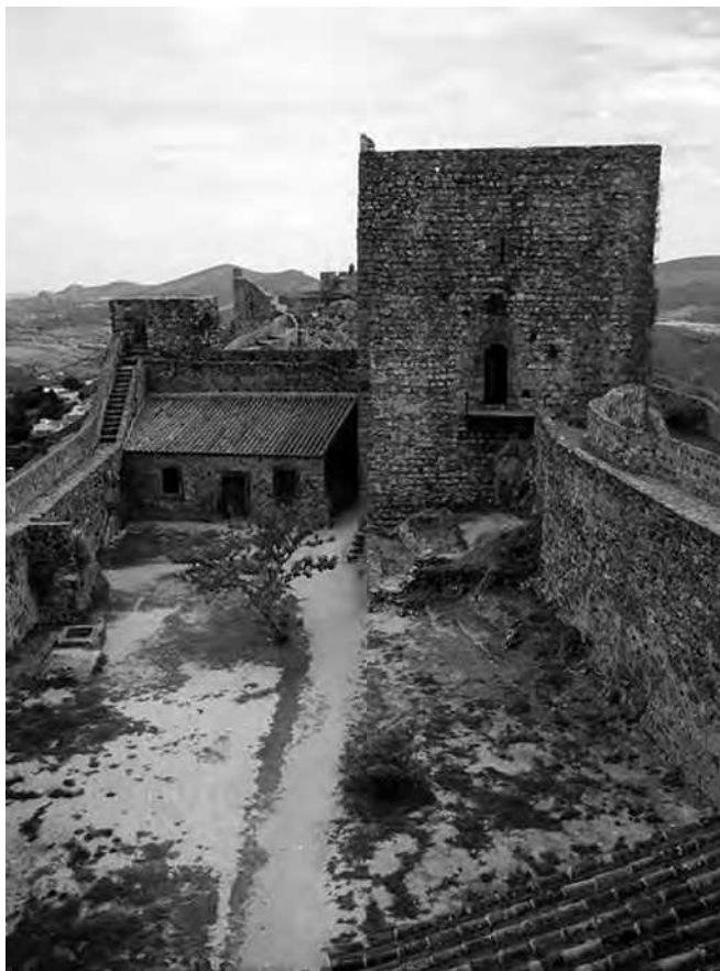
A Torre de Menagem e o respectivo pátio antes da última intervenção (SIPA FOTO.00033679, Domingos Bucho, 1997)
