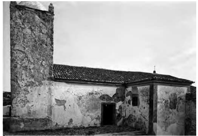
A Igreja de São Tiago em estado ruinoso (SIPA FOTO. 00166823, 1950)
