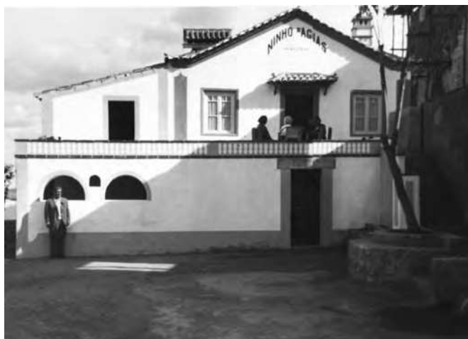
A Estalagem Ninho de Águias no ano da conclusão das obras de construção civil (1951), com JCD em baixo, à esquerda. Foto oferecida pelo amigo Domingos José Pereira que anota o evento nas costas da fotografia
