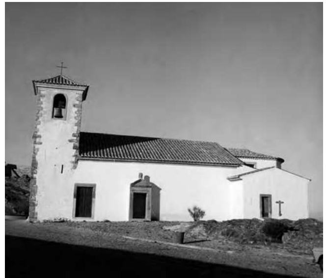
Igreja de Santa Maria em avançado estado de restauro, pela DGEMN, onde ainda se vê uma porta da sacristia que passará depois a janela (SIPA FOTO.00166903, 1973)
