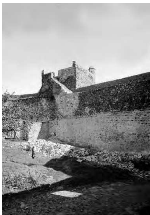
Demolição de edifícios militares, pela DGEMN, em 1942 (SIPA FOTO. 00167027, 1942)
