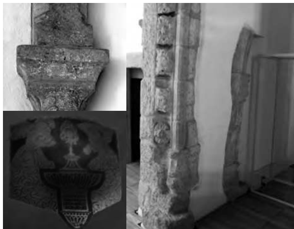
Capitel de um colunelo da capela-mor, esgrafito da sacristia da Irmandade do S. Sacramento e vestígios de arco primitivo que albergaria um altar ou capela do lado da Epístola, a que corresponderia outro do lado do Evangelho
