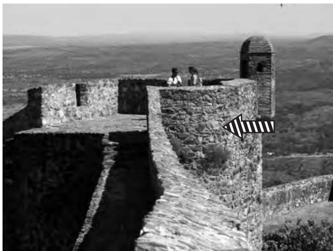
Vestígios do cubelo (uma meia-face, arredondada, do torreão) (2015)
