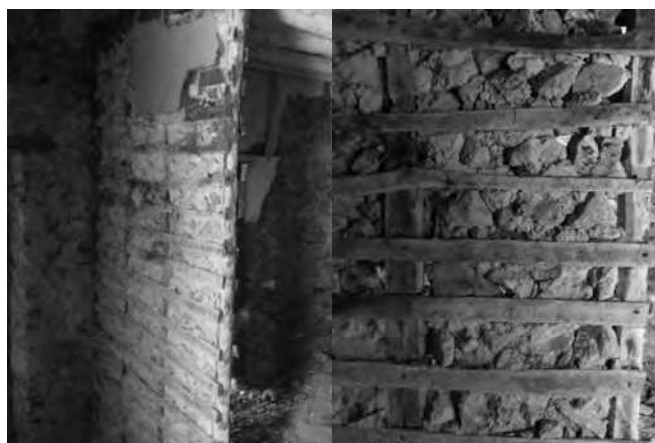
Paredes de tabique numa casa da Rua 24 de Janeiro (2015)
