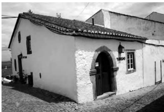
Antigo posto de turismo de Marvão e café “O Castelo”. (SIPA FOTO.00033662, s. d.). Antes destas funções, o edifício foi armazém de cal e de picão, onde o jardineiro Artur Marchão (até c. 1976) fazia diariamente, no período frio, as braseiras que ia instalar nos paços do concelho para aquecimento dos funcionários
