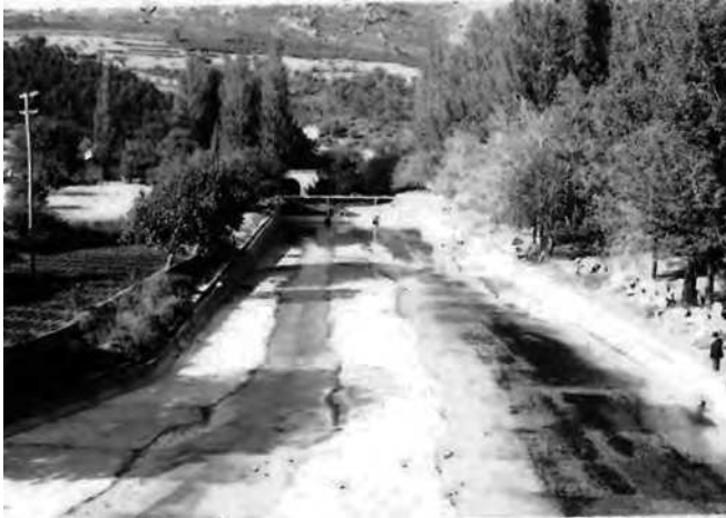
A piscina fluvial da Portagem em construção
