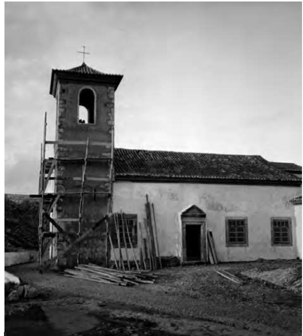
A reconstrução da torre sineira, em 1960, pela DGEMN (SIPA FOTO.00166861)
