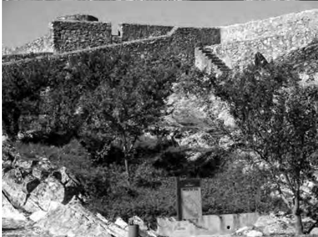
Extradorso da cisterna com o depósito de água actual no seu topo nascente, tendo-se escavado, para tal, a plataforma artilheira que aí existe, a defender a entrada no Castelo. Na foto de baixo, a referida plataforma vista de SE (2015)
