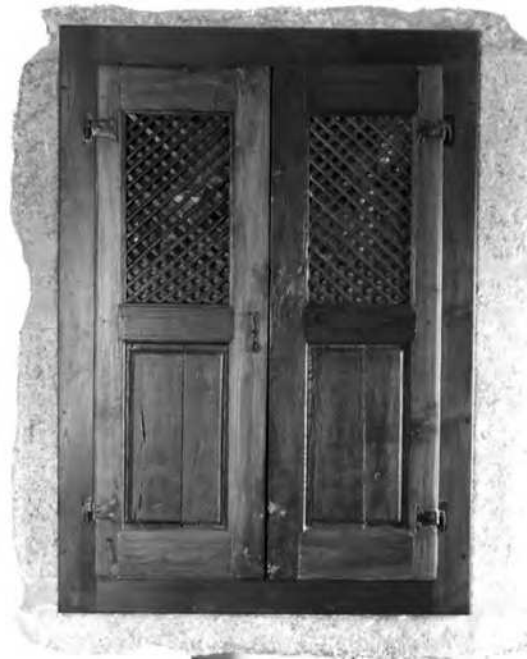
Armário de parede com portas de rótula e fecho de ferro
