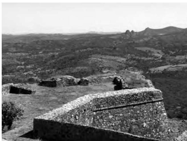
Postigo do Torrejão: interior do baluarte SO (2015)
