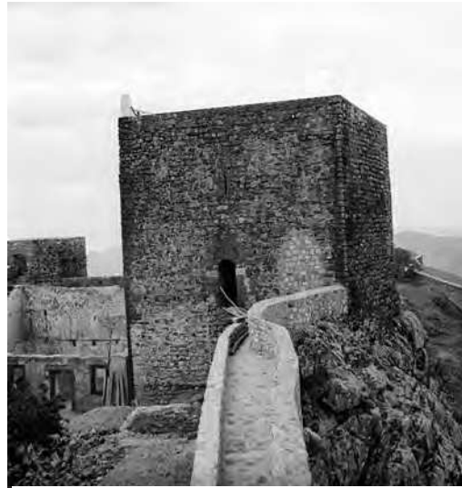
Em consequência das demolições dos armazéns adossados à muralha poente, foi (re)construído o adarve, em 1945 (SIPA FOTO.00166945, 1945). Diga-se que o anterior acesso à Torre de Menagem se fazia por escadas
