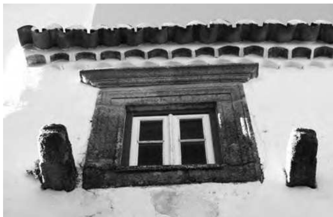
Janela da Rua de Cima n.º 16
