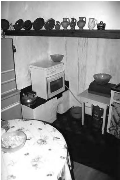
Chaminé "modernizada" mas com o fogão a gás apoiado nas antigas fornalhas (Travessa dos Marroios n.º 8 (2004)
