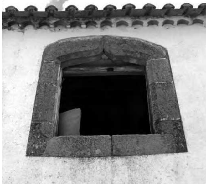
Rua 24 de Janeiro (foto s. d.) e janela de arco conopial pertencente ao n.º 11
