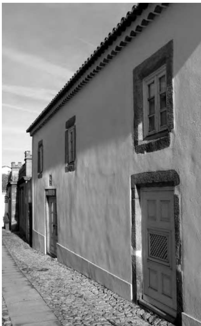
O outro edifício, fronteiro à Casa das Maltezas, que também pertenceu à Ordem de Malta, como o respectivo emblema o atesta
