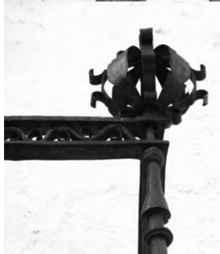
Sacada decorada pelo intradorso e gradeamento em ferro forjado
