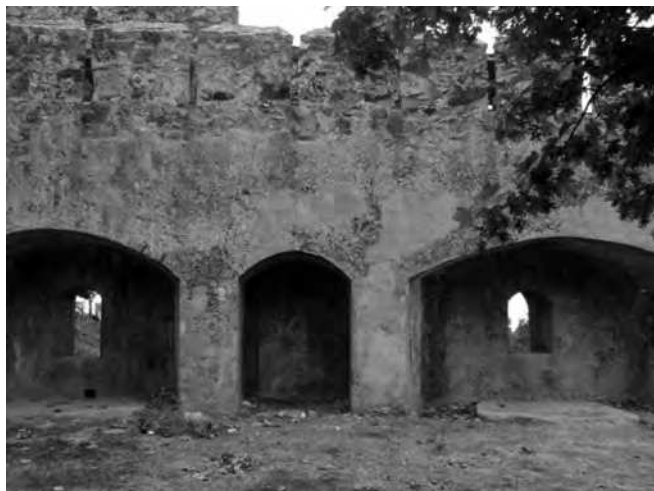
Piso inferior do meio-baluarde, face NO (2015)
