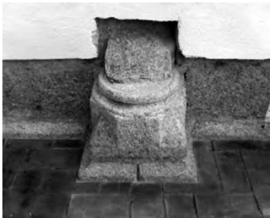
Base de coluna na nave da igreja
