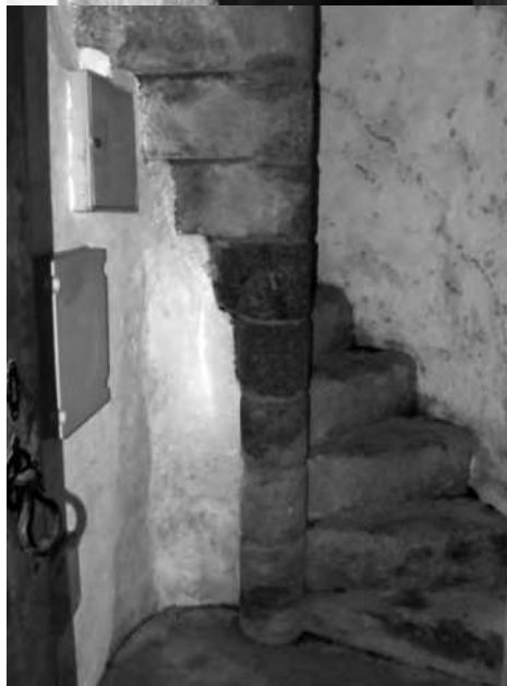
Porta (foto Raul Ladeira) e escadas de acesso à torre sineira
