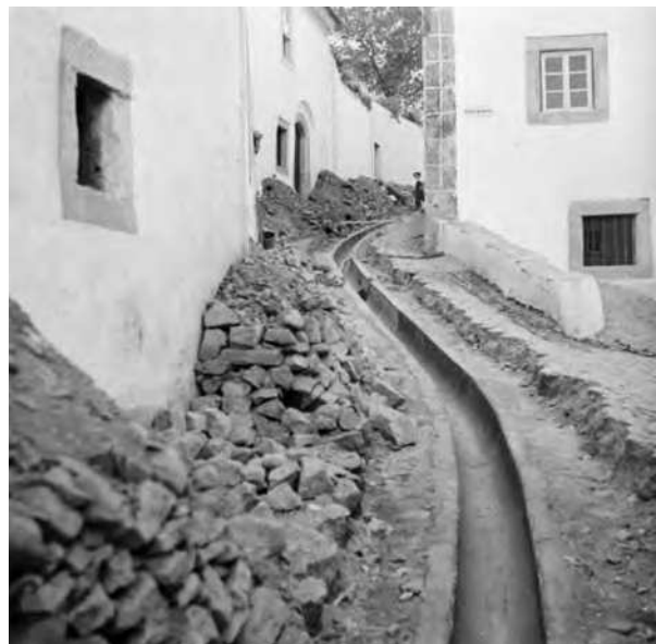
Construção de esgotos e repavimentação da Rua da Porta da Vila (SIPA FOTO.00166967, s. a., 1948)
