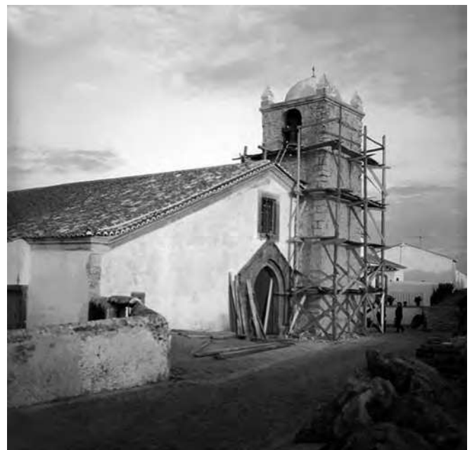
A Igreja de São Tiago em obras de conservação e restauro (SIPA FOTO.00166814, 1971)
