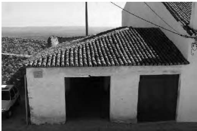
O edifício da sede dos bombeiros de Marvão antes da sua reabilitação para posto de turismo
