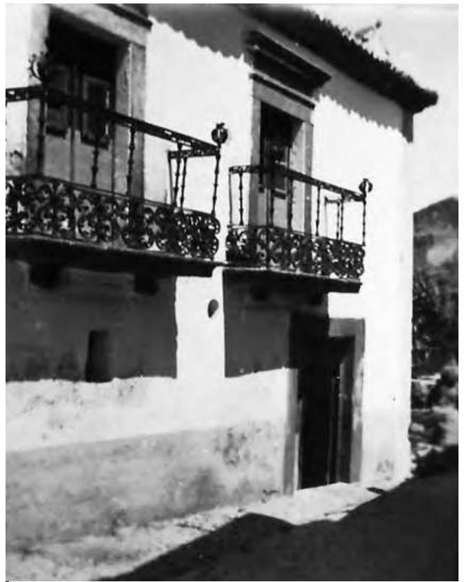
A “Casa do Governador” antes da sua reabilitação para as funções actuais (foto anterior a 1934, uma vez que ainda não tinha sido construído o urinol na Travessa do Chabouco)
