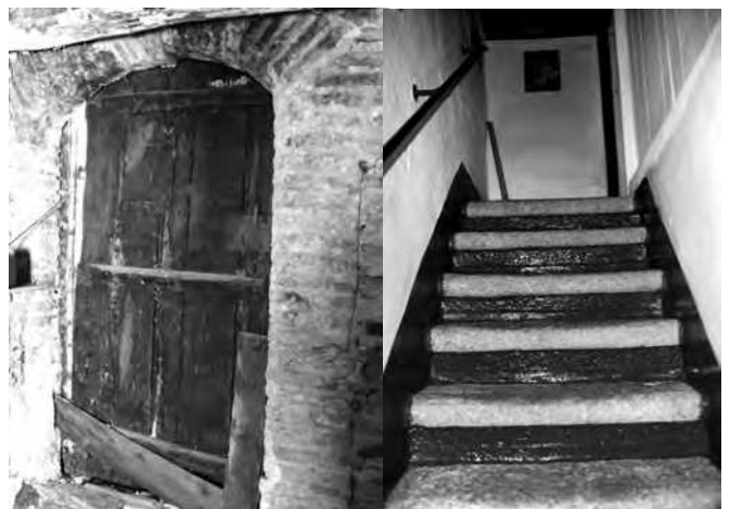
Vão interior executado com tijolo burro e escadas de granito
