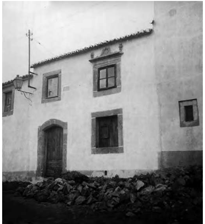
Edifício da Rua de Santiago n.º 5 (pertencente, hoje, à família Madeira) com a constituição que apresentava em 1951, durante as obras de introdução dos esgotos (SIPA FOTO.00167048)
