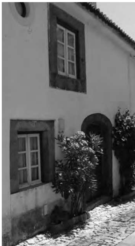
Rua de Santiago n.º 8: a porta principal foi transformada em janela e a da loja passou a principal
