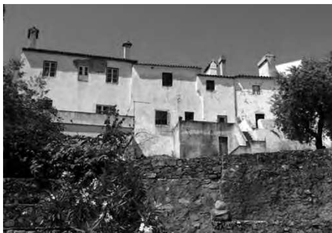
Rua do Castelo: tardozeiros de três pisos e quintais das casas do lado nascente
