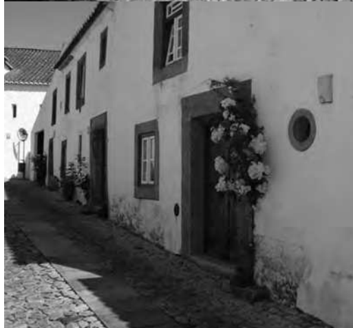
Rua de Santiago n.º 7 (à esquerda) e n.º 10 Casas de uma só porta com fresta rectangular ou com óculo para iluminar a escada
