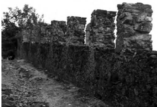
Duvidosos vestígios de ameias na barbacã nascente do lado norte (2015)
