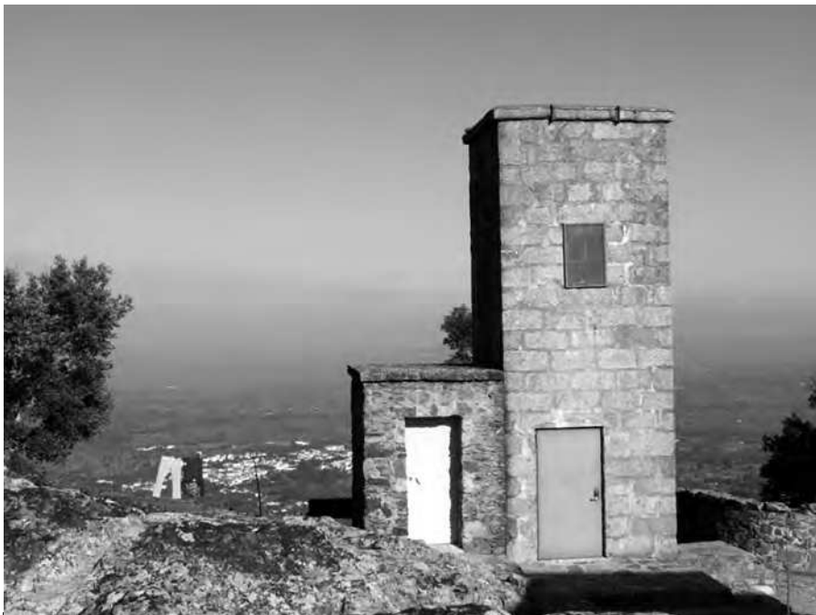
O posto de transformação no topo da Rua do Castelo (anos 40 do séc. XX)
