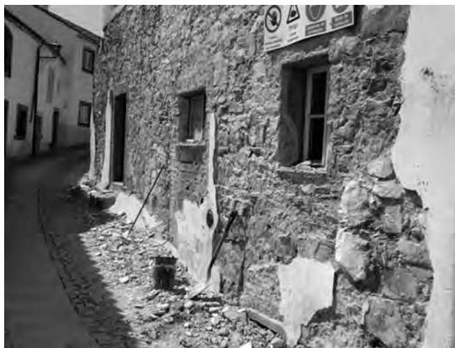
Rua de 24 de Janeiro n.º 18: a porta da loja (vão intermédio) foi transformada em janela
