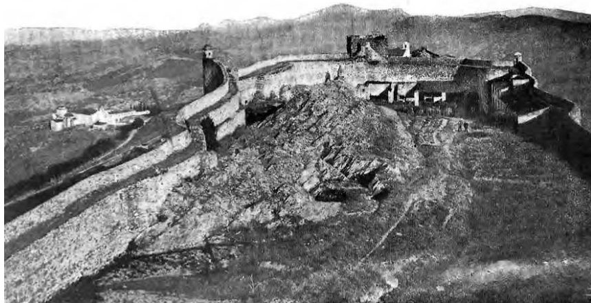
O albacar com os edifícios à sua entrada, demolidos uns, reabilitados outros, a partir de 1942 (ver SIPA FOTO.00167027, 1942 e 00167006, 1942). Foto publicada por COELHO, Possidónio, 1916: entre pp. 48 e 49
