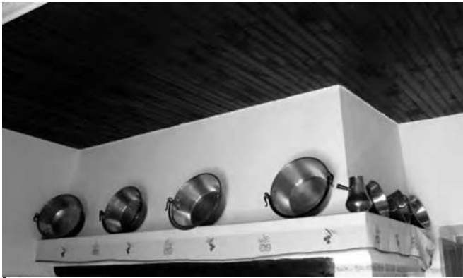
Tecto com forro de madeira emparelhada (família Alves Garcia)
