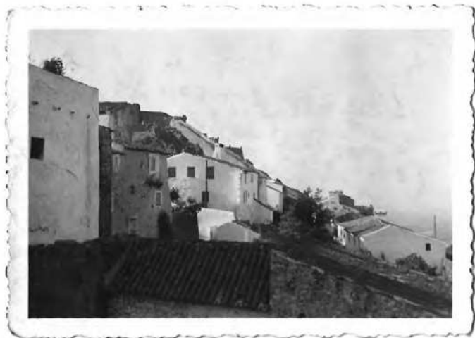
Traseiras da Rua de Cima. Foto s. d. tirada da Praça
