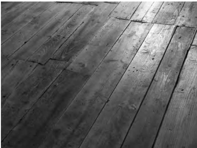
Pavimento de soalho, de pinho e de castanho, da Sala do Tribunal da Câmara Velha.
