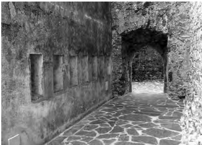
Entrada protegida, no pátio da Torre de Menagem, por parede frestada (2015)
