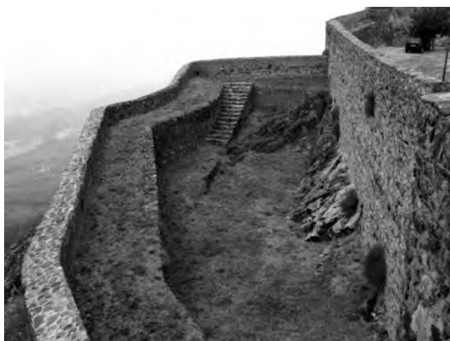
Postigo do Torrejão: prolongamento da fortificação para O, com fosso, muro não escarpado, adarve e parapeito (2015)
