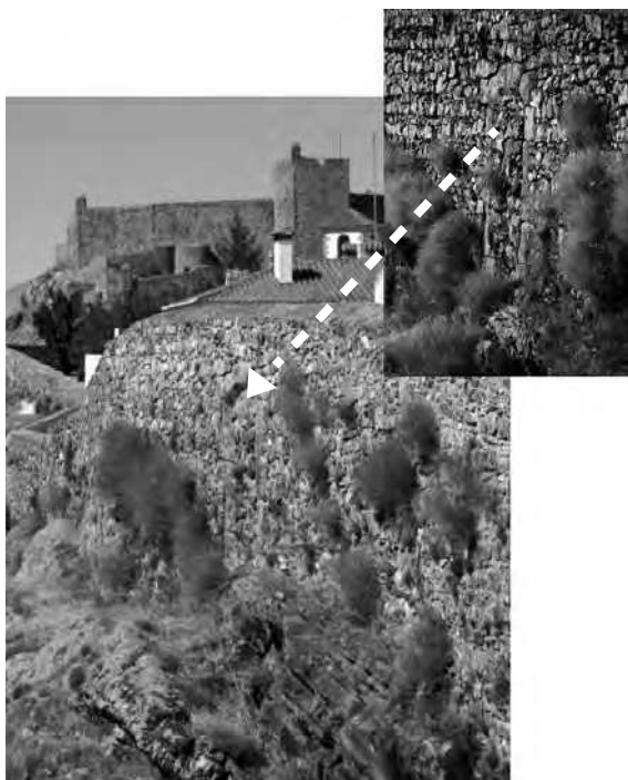
Porta empedrada no troço de muralha poente, junto ao actual parque infantil (descoberta por António Gil) (2015)
