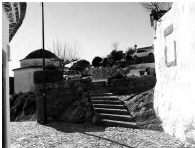
Rua do Embique onde curvava, à direita, para o Quartel do Corro. Na parede do lado direito, a moldura de uma janela documentando ter existido ali uma habitação (hoje simples muro de quinta)
