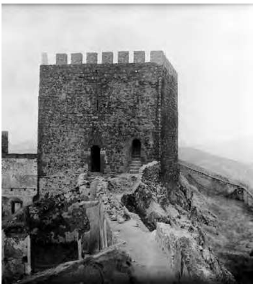
Início da reconfiguração da Torre de Menagem, eliminando a sua anterior reabilitação para paio da pólvora e acrescentando-lhe ameias que, posteriormente, foram demolidas (SIPA FOTO.00166942, 1942)
