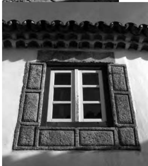
Rua da Porta da Vila n.º(s) 6A e 6 com o pormenor da sua janela
