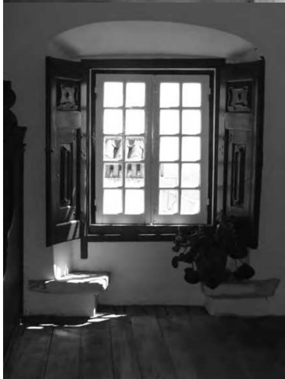
Janelas com conversadeiras (Rua do Espírito Santo n.º 1, em 2011) e sala do antigo tribunal da Câmara Velha
