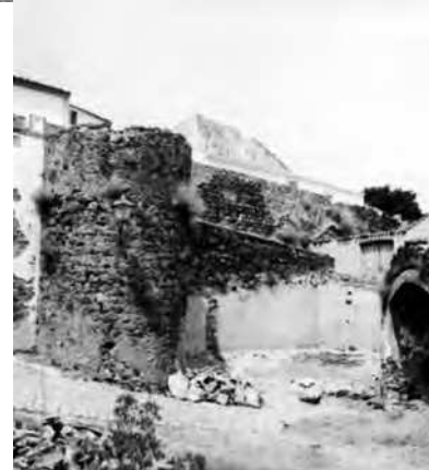
Foto de cima: uma das portas da Porta da Vila (porta da barbacã ou intermédia) com quatro ameias que nos parecem ornamentais (SIPA FOTO. 00166943, 1942). Em baixo, a mesma porta, do lado norte, observando-se a demolição de uma Casa da Guarda e, atrás, na liça da barbacã, um armazém militar destelhado (1942) (SIPA FOTO.00166941, 1942)
