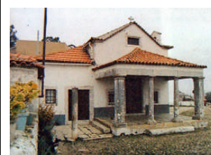
Capela de N.S. da Saúde, em Montemor, Loures (com pórtico de 3 vãos, sobre duas colunas e dois pilares; in Loures Tradição... pág.94)
