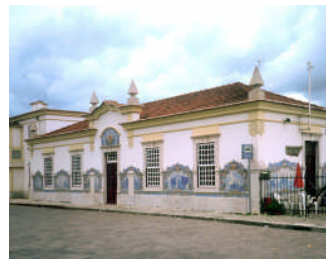
Estação de C.F. de Santiago do Cacém
