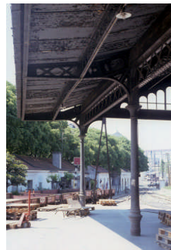
Cobertura em estrutura metálica da estação de Alcântara-Terra, em Lisboa
