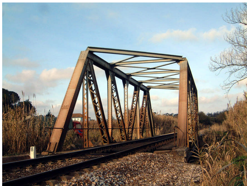
Ponte ferroviária em ferro, de 1933
