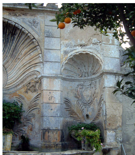
Chafariz da Quinta da Pegada, com obra de massa
