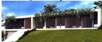
Urbanização do Bom Sucesso, proj. 2004, obras em 2006 (in Expresso 4/6/05; in Expresso 28/1/06)
