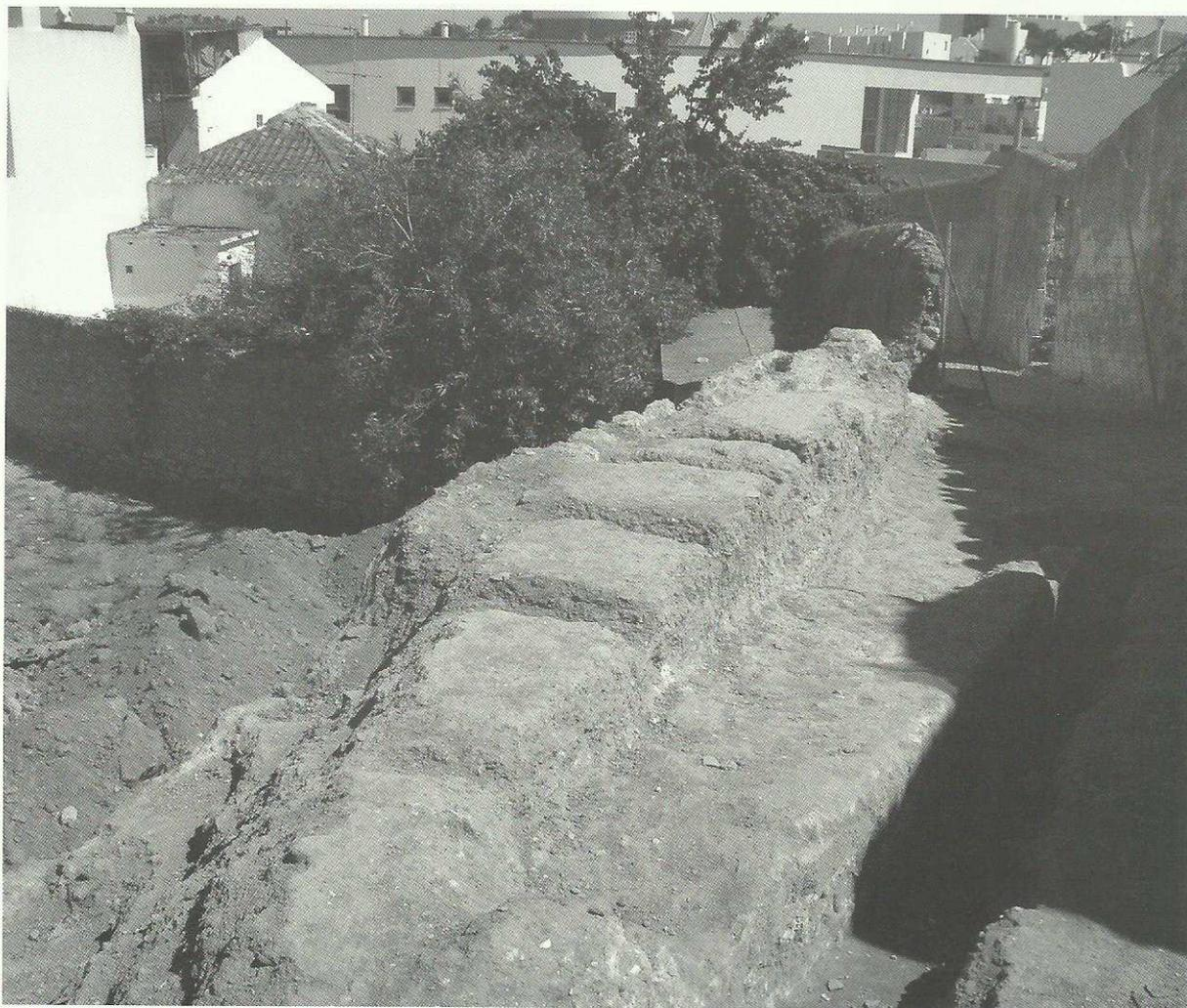
**Fig. 4** – Vista da parte superior da barbacã vendo-se o negativo dos taipais e observando-se a espessura da construção
