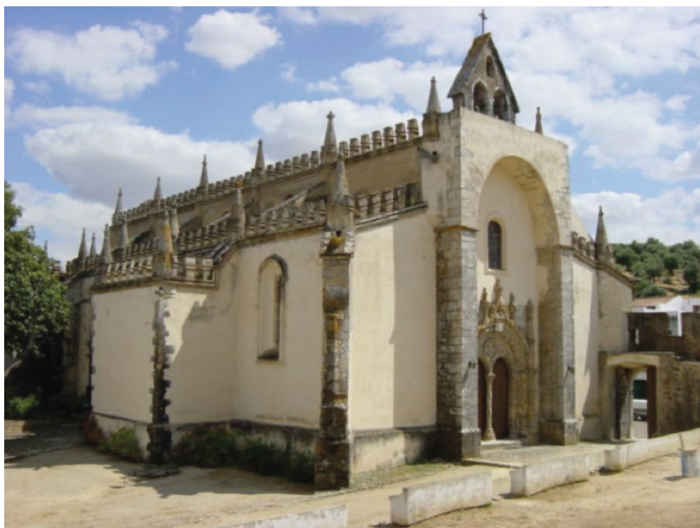
Fachada da Igreja Matriz
