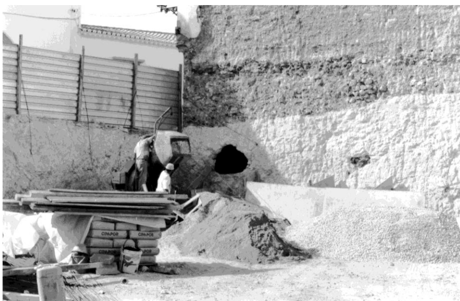
Figura 3. Vista das zonas cortadas dos dois silos (foto M. V. Gomes, RI/00-31).
