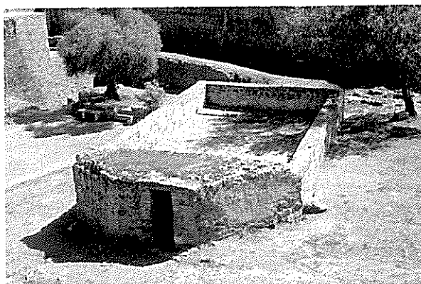
Fig. 11 - Cisterna do castelo, ampliada em época moderna.
