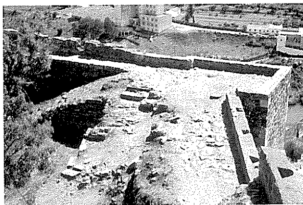
Fig. 9 - Ângulo da fortificação onde se elevava a torre do alcaide-pequeno arrasada a seguir à Restauração para a colocação de artilharia.
