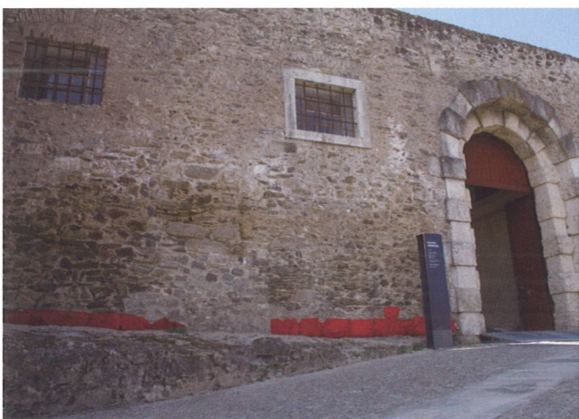
Fig. 9 | Fila de pedras de calcário na base da fachada da porta de entrada
