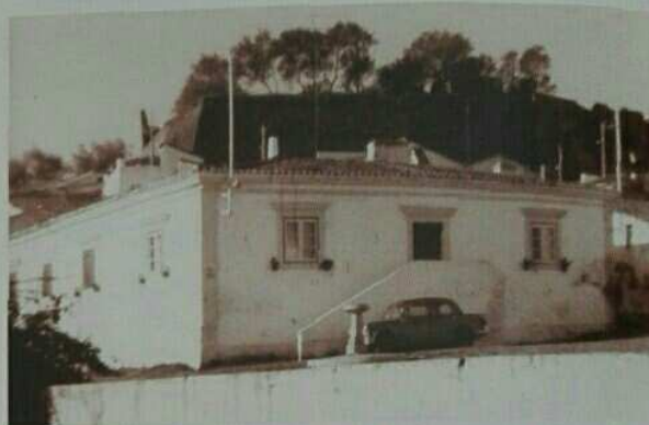
Título / Title: Edifício da Casa dos Condes Data / Date: décadas de 60/70 do séc.XX Acervo / Chatters: Câmara Municipal de Alcoutim
