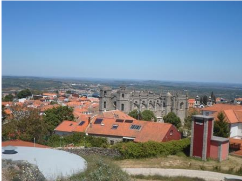
A construção de depósitos de água, à direita, e postos de eletricidade, à esquerda, dificultam uma visualização da cidade a partir do topo da Torre de Menagem. (Fonte: Vanessa Pita, 2012).
