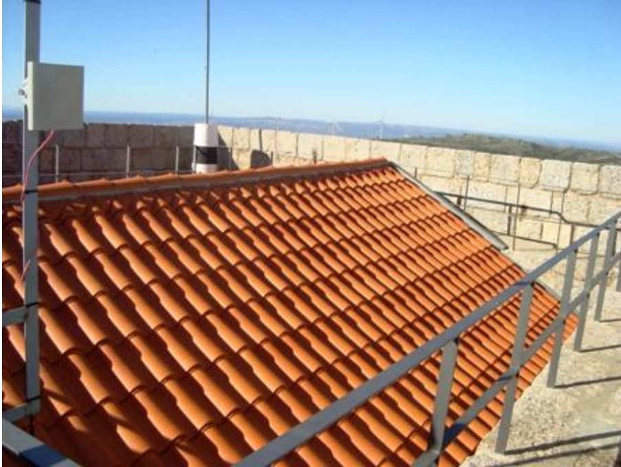
Imagem 3: Cobertura em telhado da Torre de Menagem. (Fonte: Vanessa Pita, 2012).
