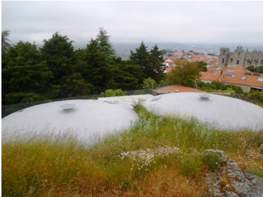
Dois dos quatro depósitos de água localizados nas imediações da Torre de Menagem. (Fonte: Vanessa Pita, 2013).
