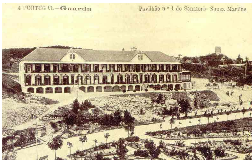
Pavilhão n.º 1 do Sanatório Sousa Martins em 1914. (Fonte: SARAIVA, António (coord.) (2008). A Guarda em Postal Ilustrado de 1901 a 1970 . Guarda: Agência para a Promoção da Guarda PolisGuarda, SA., p. 171).
