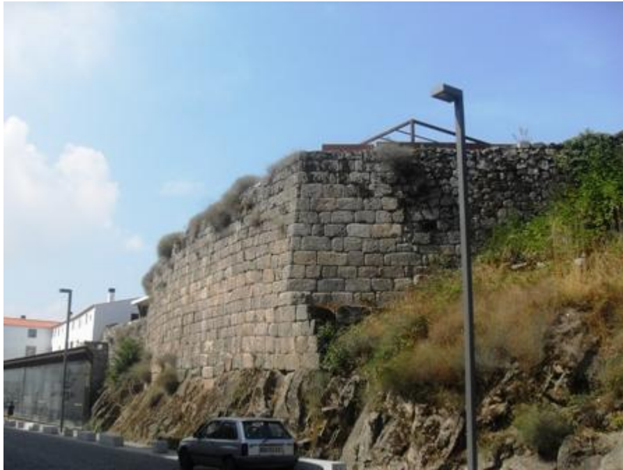
Troço de muralha localizado junto à cidadela do Torreão. (Fonte: Vanessa Pita, 2013).
