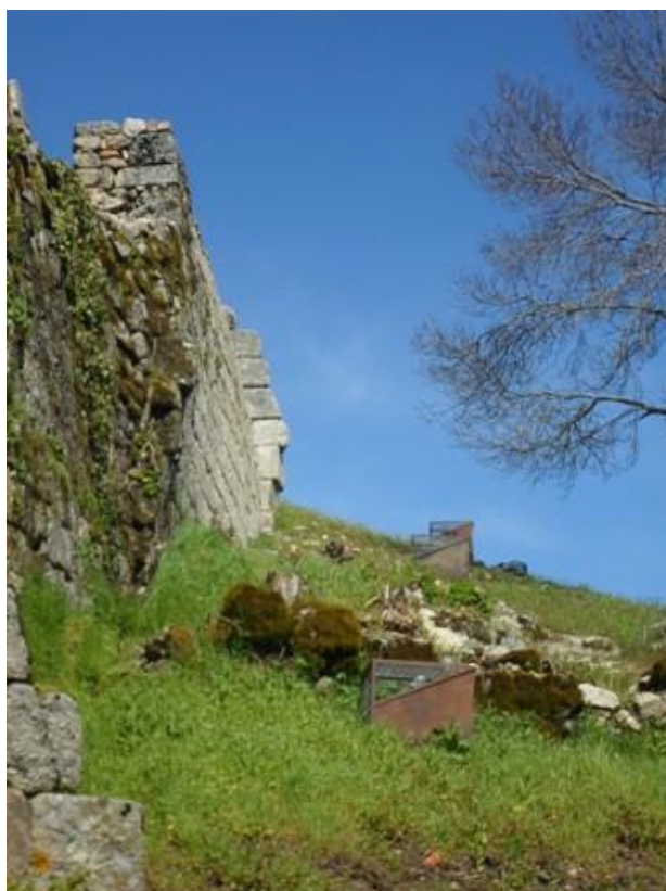
Holofotes instalados no âmbito da iluminação cénica da muralha. (Fonte: Vanessa Pita, 2013).
