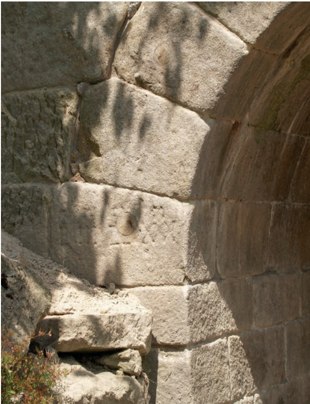
Fig. 6. Arranque do arco românico da ponte de Donim.
