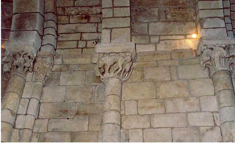
Fig. 9. Longosvales. Capitéis do interior da capela-mor.
