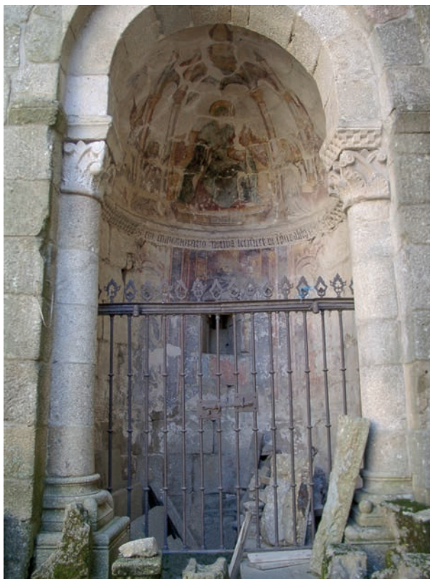
Fig. 3. Sé de Braga. Absidiolo setentrional, actualmente no exterior do edifício.
