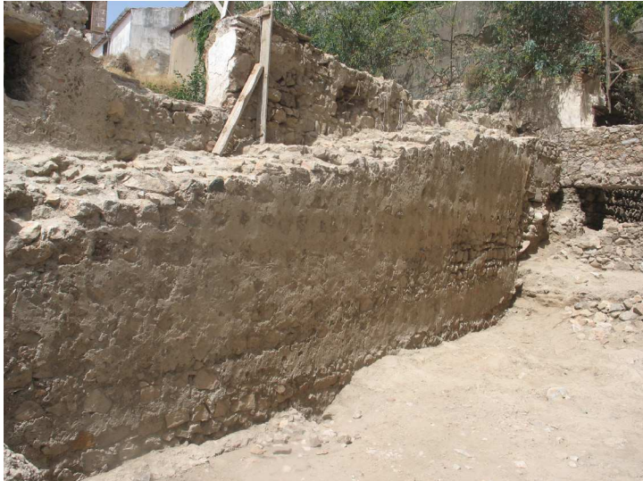
Figura 13. Barbacã [15] (face interna, oeste).
