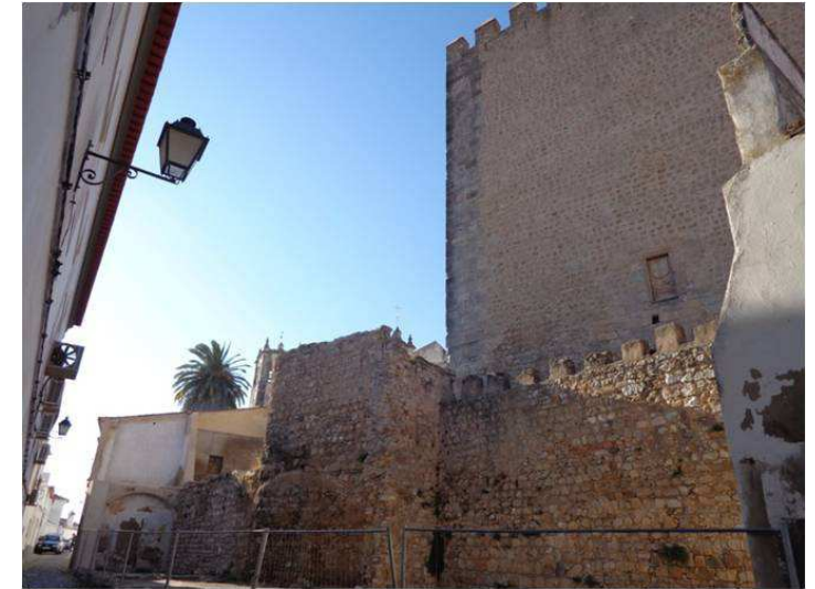
Figura 1. Vista da área de intervenção na Rua da Barbacã exterior às muralhas, após a demolição do edifício n.os 29-33.
