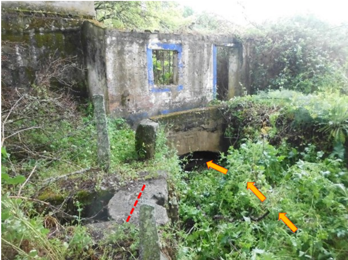
Fig. 4 - Imagem atual do Moinho, assinalando a entrada da água nos caboucos do moinho (amarelo) e a presença de uma meia mó a servir de passadiço num canal de saída da água, junto à comporta (vermelho).
