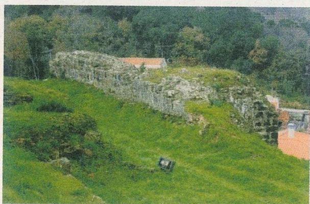
Foto III – Troço Norte da Barbacã (lado interior).
