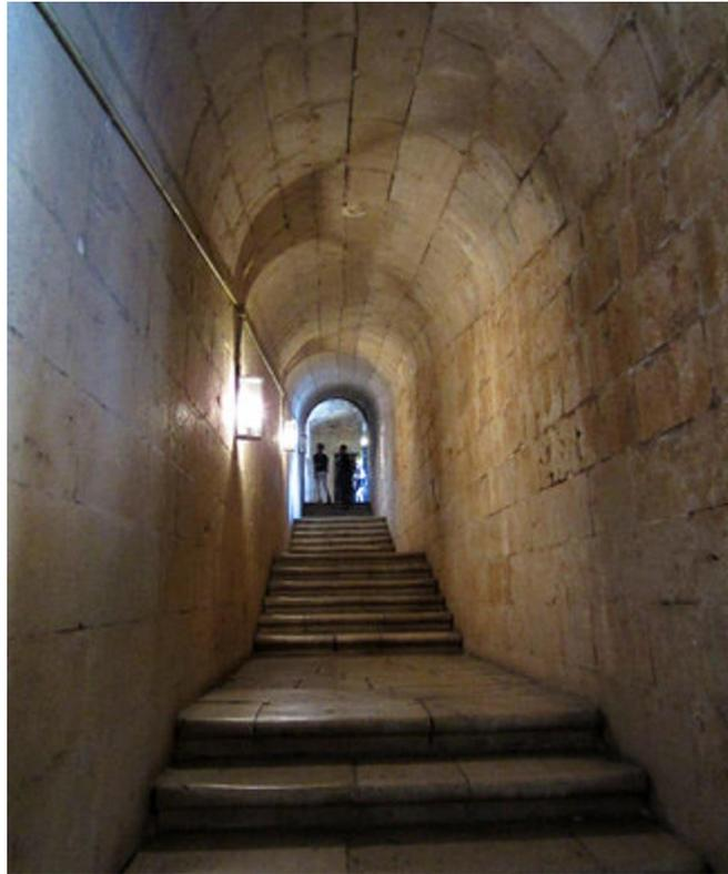
Fig. 217 – Escada no mosteiro dos Jerónimos construída na espessura do muro que divide a igreja do claustro (permitindo o acesso ao piso superior do claustro e coro alto).
