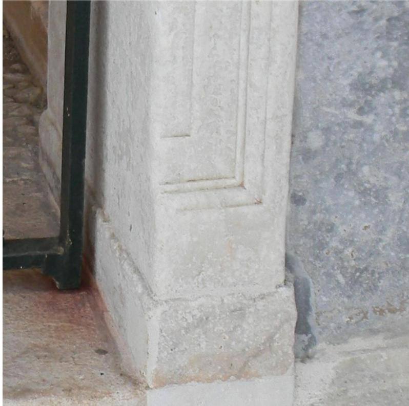
Fig. 123 – Pormenor da base de um portal da fachada do Paço de Vila Viçosa, vendo-se o remate em L. Fonte: Manuel Apóstolo.
