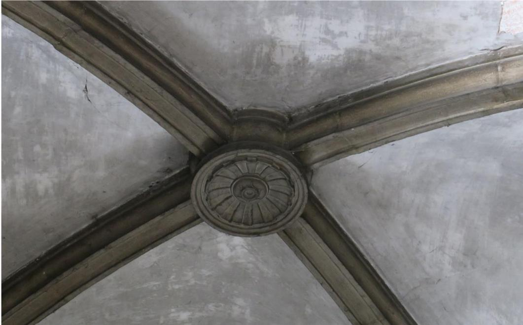
Fig. 97 – Detalhe do abobadamento do túnel de acesso ao Palácio Almada Carvalhais.
