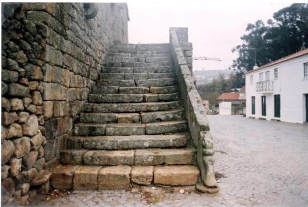
Fig. 166 – Escada do Paço da Loba, vendo-se na base do mainel um balaústre.
