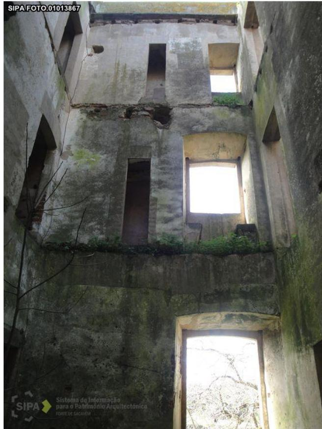
Fig. 196 – Interior da Torre do Carvalho, sendo visíveis à esquerda os vãos para o caracol e ao meio os vãos para os retretes.
