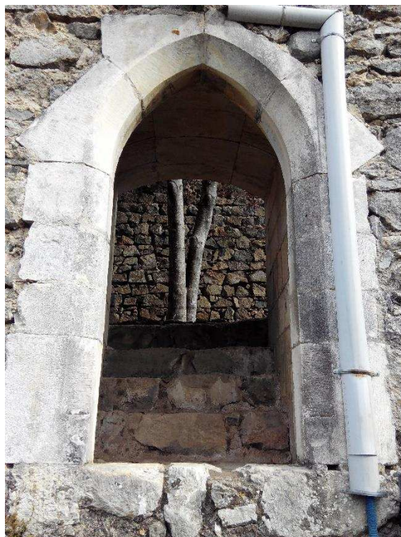
Imagem 15 – Porta da Traição, alçado exterior.
