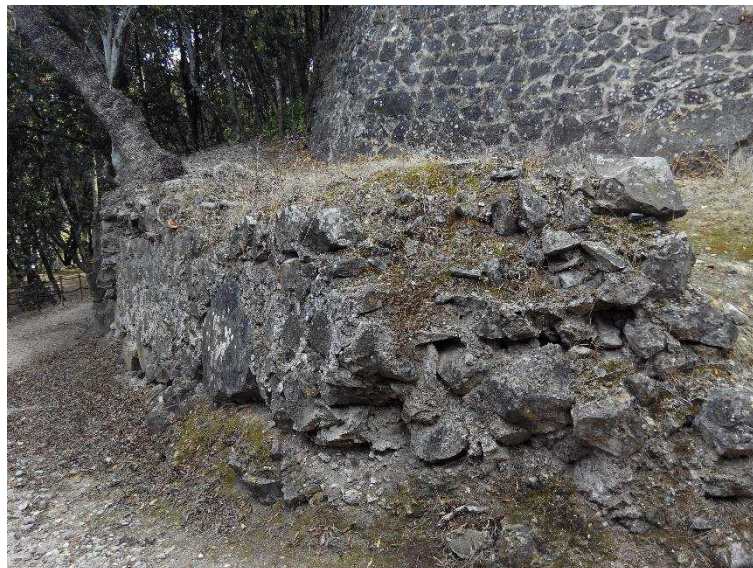
Imagem 12 – Estrutura paralela à muralha norte, junto da Porta Nova. Perspetiva oeste.
