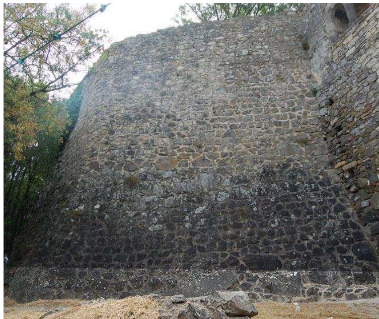
Imagem 10 – Setor anguloso e dotado de talude da muralha norte, alçado poente. Fotomontagem.
