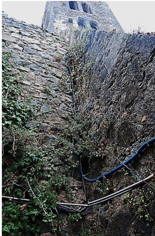
Imagem 9 – Contraforte adossado à Torre Buçaqueira, detalhe da zona de contato entre as duas estruturas.
