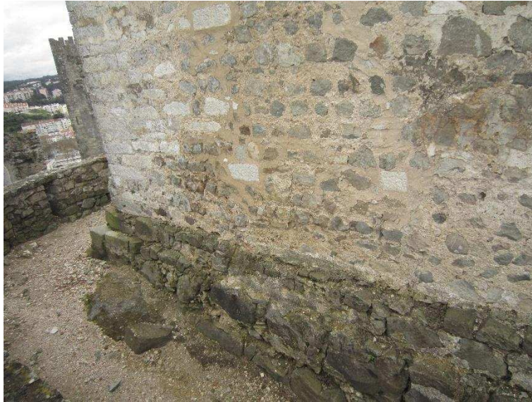
Imagem 19 – Torre de Menagem, pormenor da sapata escalonada, alçado norte.
