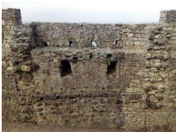
Edificação a sul da Porta da Traição.
