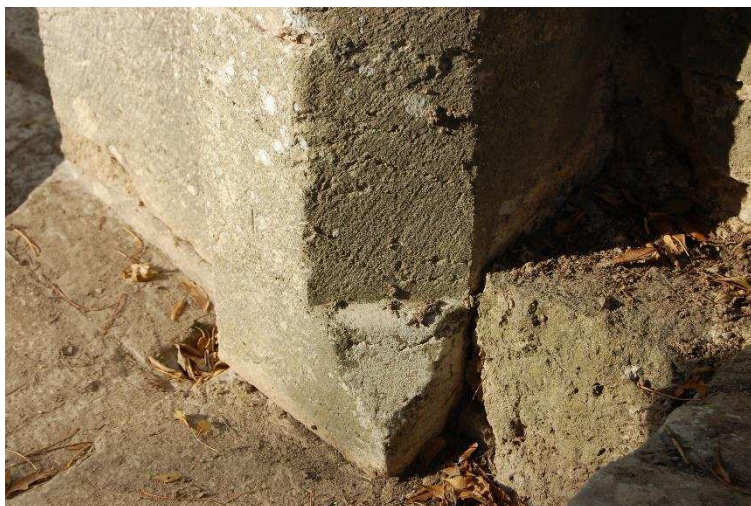
Imagem 17 – Vão de Porta do CJED V, pormenor da base da ombreira, em 'unha'.
