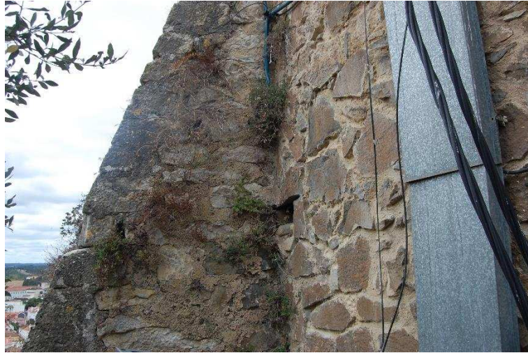
Imagem 13 – Contraforte adossado à fachada principal dos Paços Novos (primeiro, a nascente).
