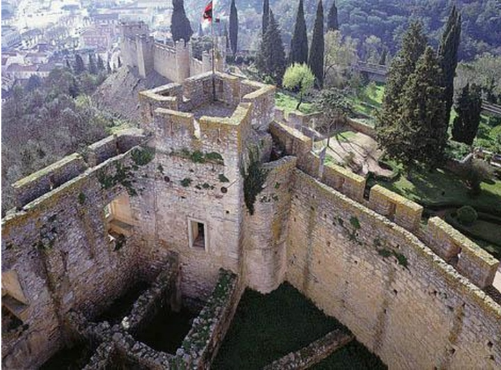
Castelo de Tomar - vista a partir da torre de menagem
