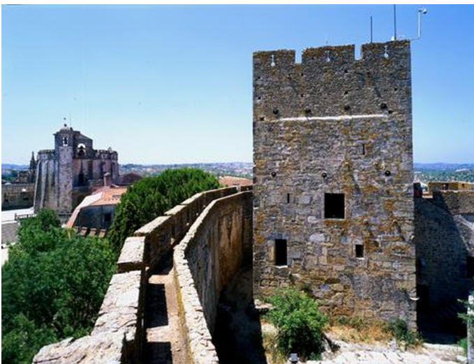
Castelo de Tomar – Torre de Menagem
