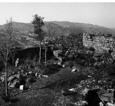
Pátio antes das intervenções da DGEMN. Fonte: arquivo IHRU.
