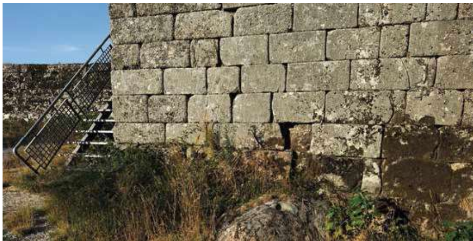
Pormenor do aparelho da base da torre e da muralha contígua.
