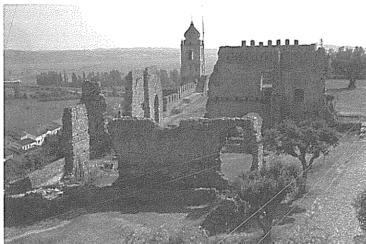
Fig. 12 - Paço Real do Castelo de Montemor-o-Velho, antes da recente intervenção.
