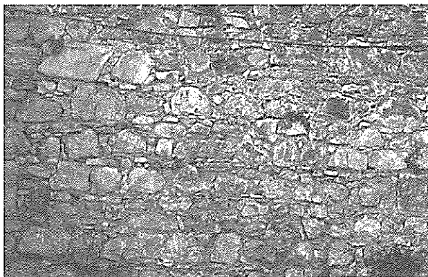
Fig. 4 - Pormenor do aparelho de construção da 1ª Fase.
