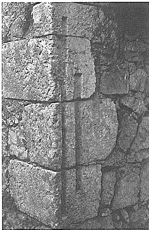
Fig. 11 - Medidas-Padrão do Castelo de Montemor-o-Velho - Vara e Còvado.
