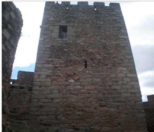
Figura 10. Torre de Menagem.
