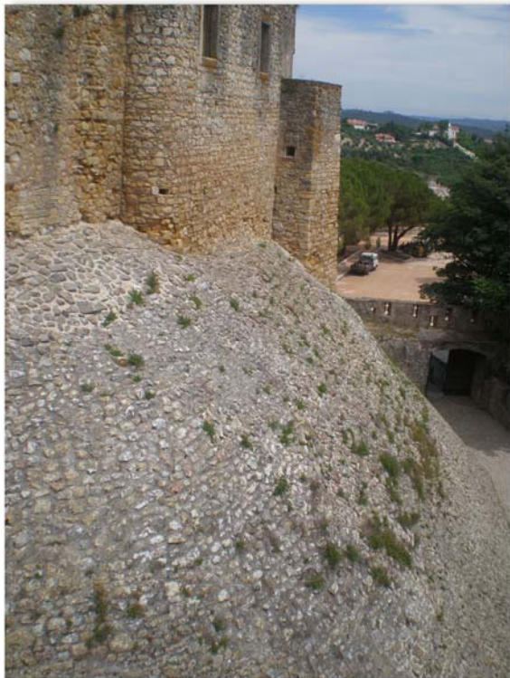
Figura 19. Alambor existente na muralha exterior do castelo de Tomar.
