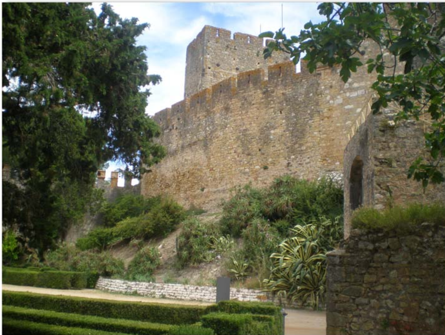
Figura 34. Muralha no plano superior, que contém a Torre de Menagem.
