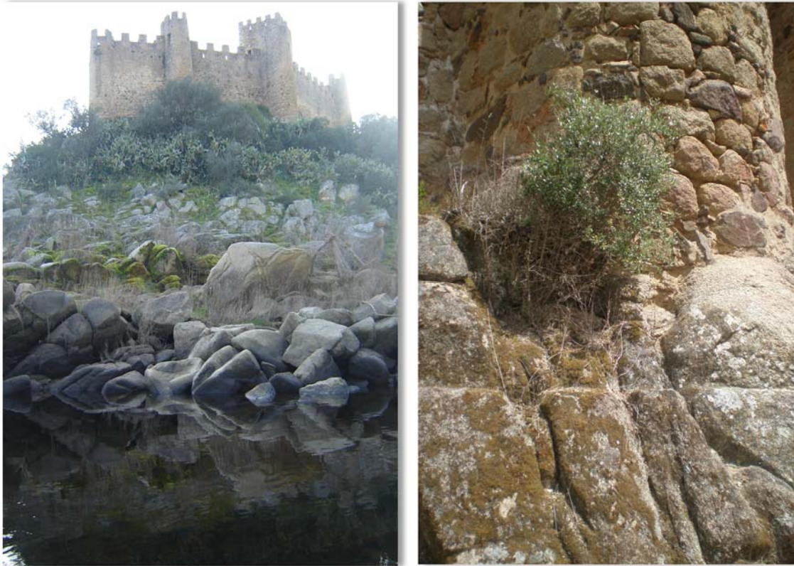
Figura 3. a) Afloramento rochoso sobre o qual foi erguido o Castelo. b) Base do Castelo assente no afloramento rochoso.
