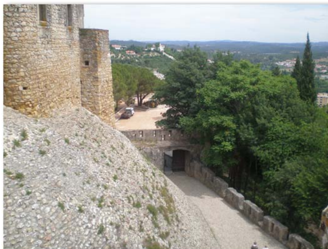
Figura 36. Alambor na face exterior da muralha.
