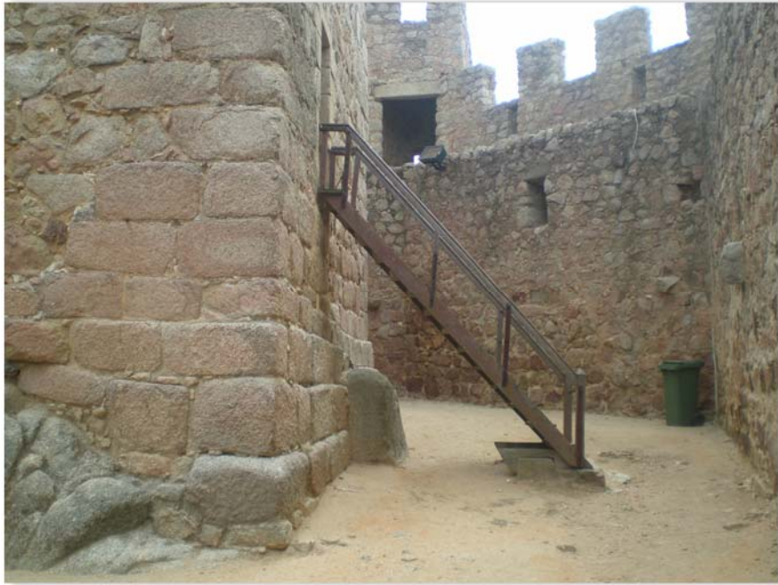
Figura 11. Escada removível de acesso à Torre de Menagem.
