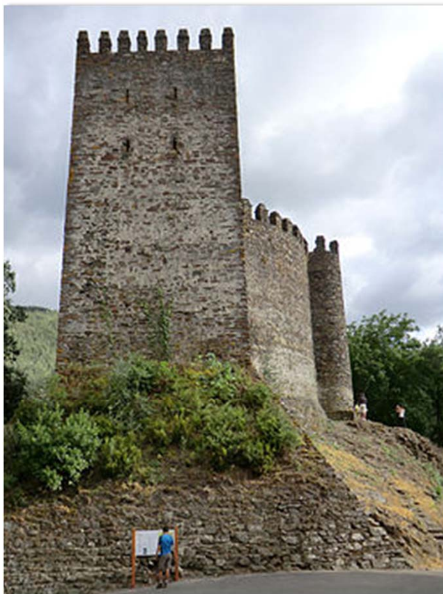
Figura 21. Alambor da Torre de menagem do Castelo da Lousã ou, também designado, Castelo de Arouce.
