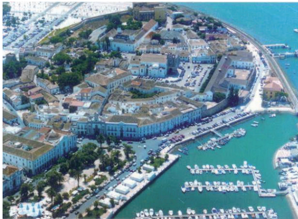
Fig. 4 – Vista aérea do centro histórico de Faro
