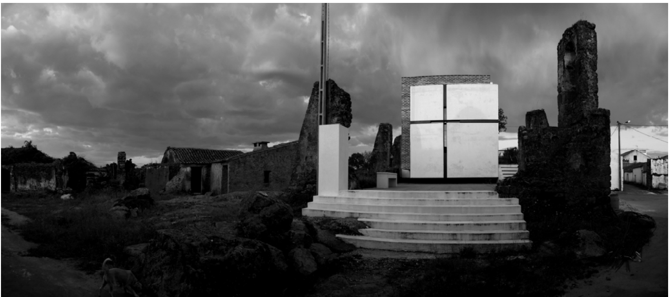
19. Vila Flor. Perspectiva geral da ruína (2009).
