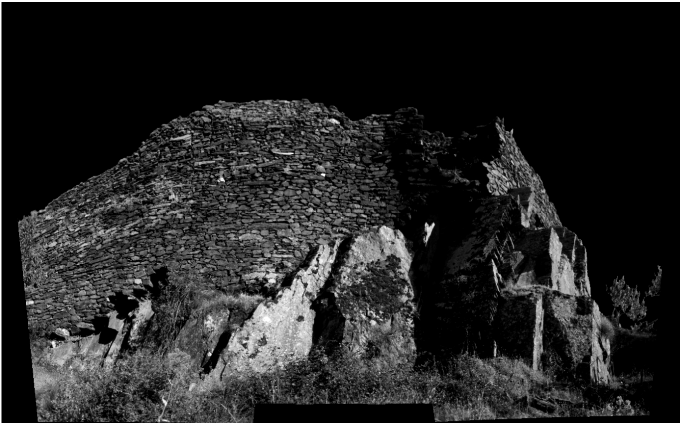
10. Aspecto actual da muralha a oeste (2009).
