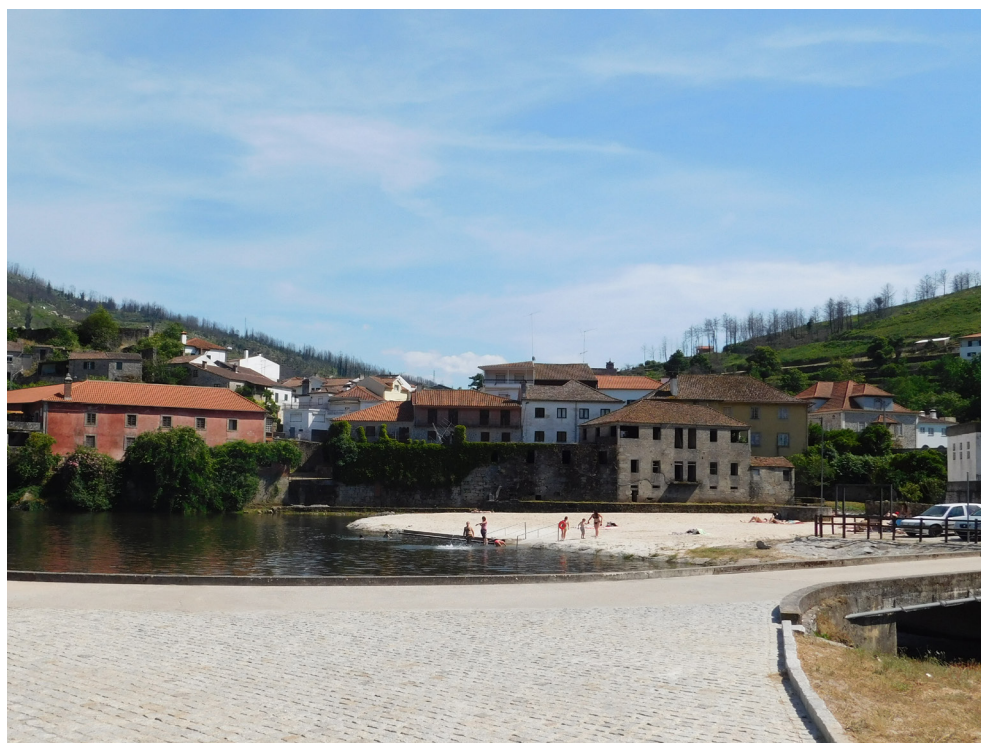
Imagem 22 - Vista do Edifício do Lagar da Praia Fluvial, Fachada Norte
