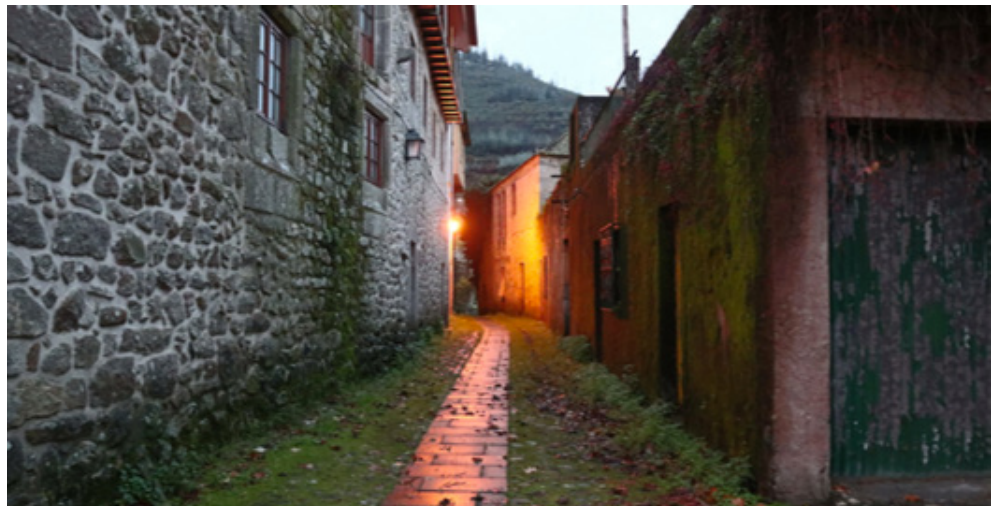
Fig. 135 - Fachada Sul do Edifício do Lagar
