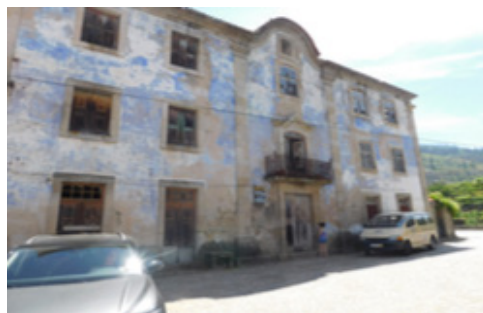
Primeira Imagem Esquerda Fig. 119 - Fachada Principal a Este do Solar
