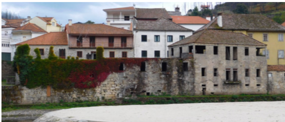
Fig. 134 - Fachada Norte do Edifício do Lagar
