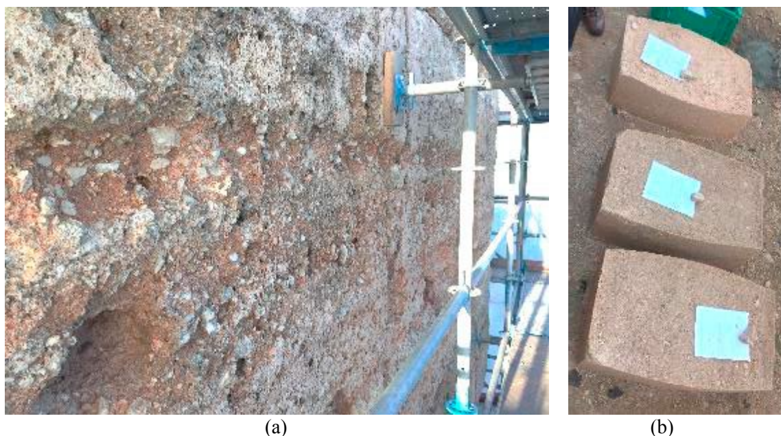
Figura 5. Superfície da taipa militar antiga (a) e provetes de taipa com diversas composições para a escolha da mistura a utilizar na reparação de lacunas na torre (b).
