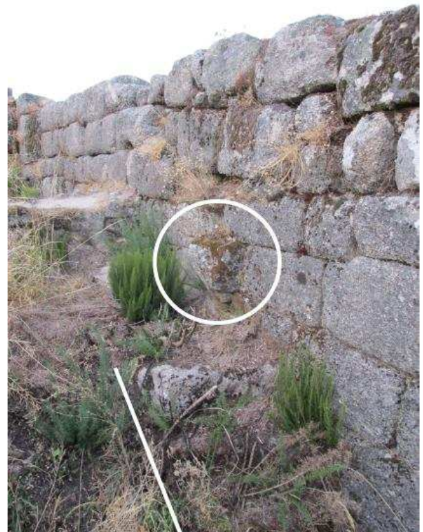
Fig. 27: Detalhe das escadas de acesso ao adarve a nordeste do recinto Sul. Situam-se a Este da capela, no interior das estruturas e no pano de muralha. Fotografia de Diana Carvalho.
