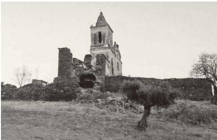
Fig. 133 – Convento do Alcance – fachada e corpo norte em 1998
