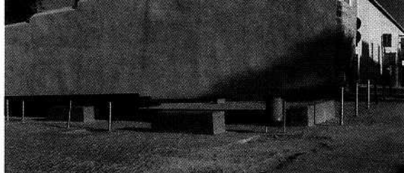
A muralha após a intervenção
