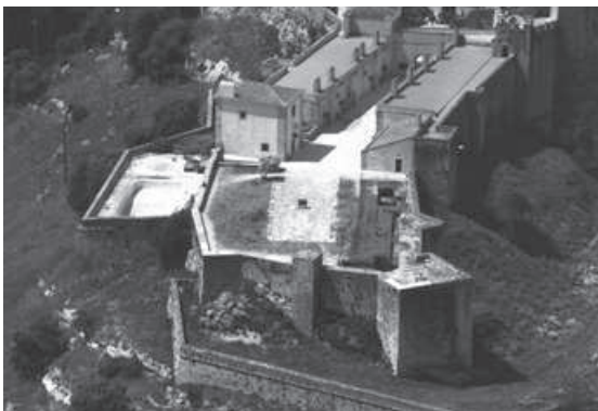
Figura 2 – Muralhas e Praça de Armas vistas de nascente, com escavações arqueológicas em curso.
