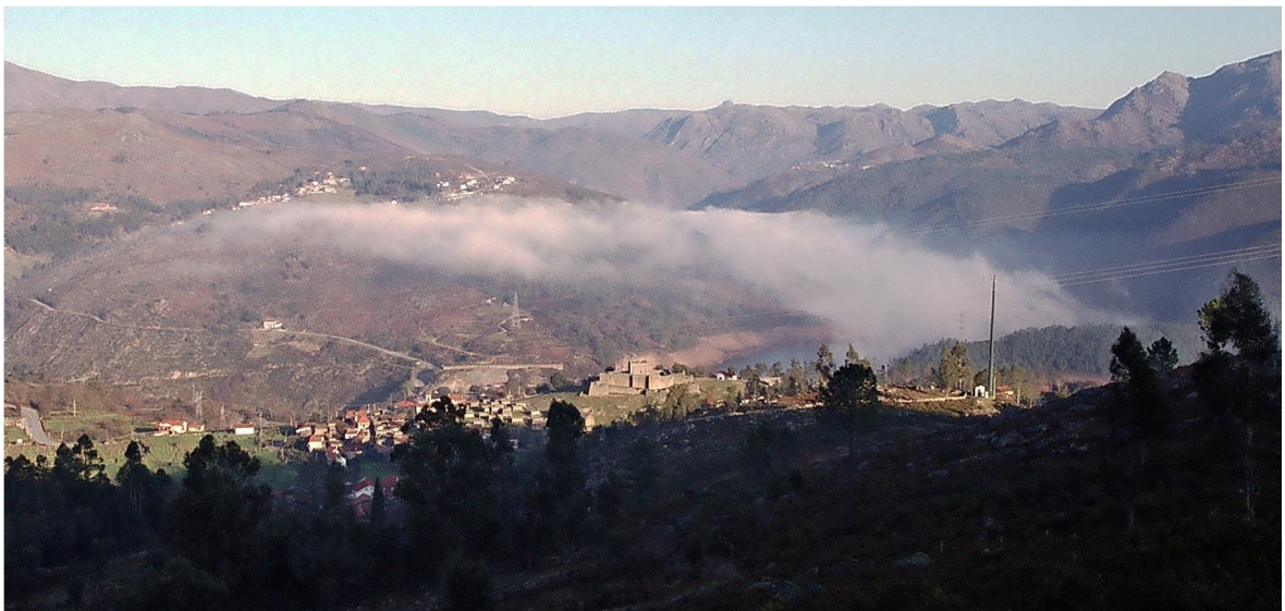
Fig.116 – Panorâmica do castelo de Lindoso, vista de Sul.
