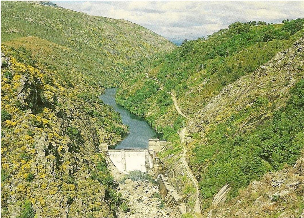
Fig.207 – Panorâmica da antiga barragem do Lindoso, c. 1990 (foto reproduzida de EDP, 1993:15).
