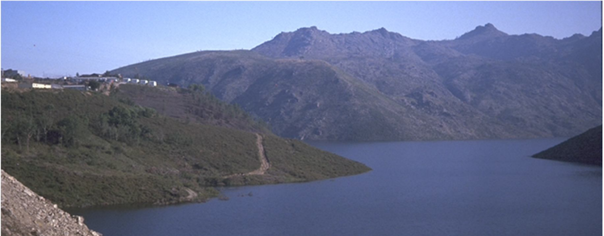
Fig.181 – Panorâmica da trincheira de Chão de Clérigo, sobre a foz do rio Cabril, vista de SE.
