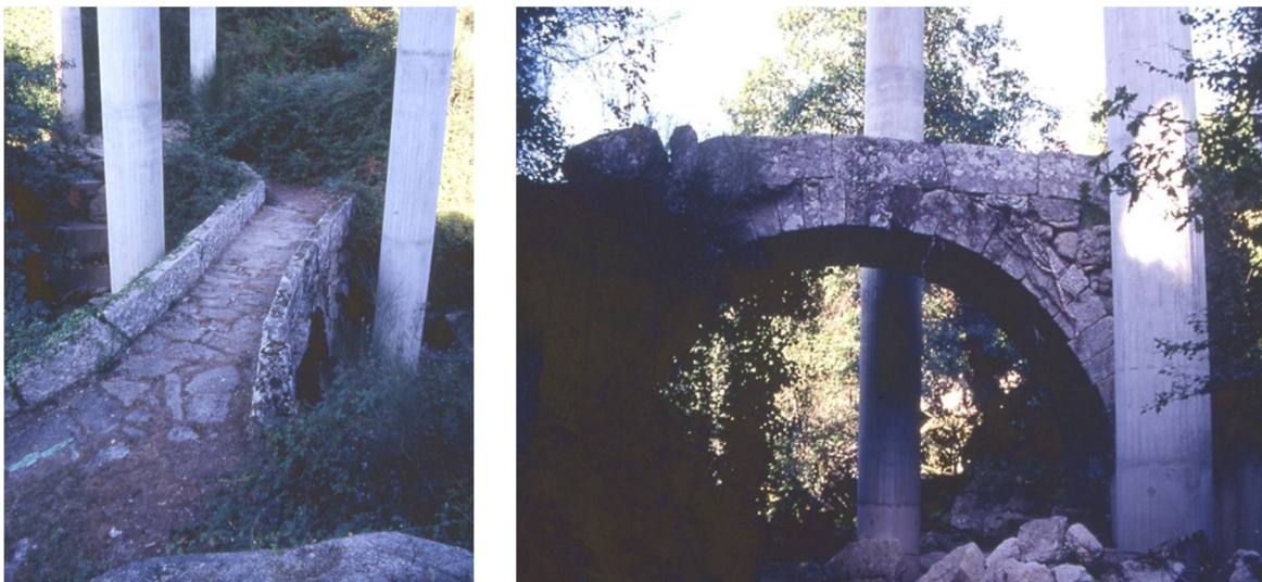
Fig.125 – Ponte Velha de Parada.
