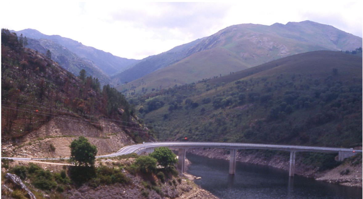
Fig.211 – Panorâmica sobre a nova travessia do rio Cabril.
