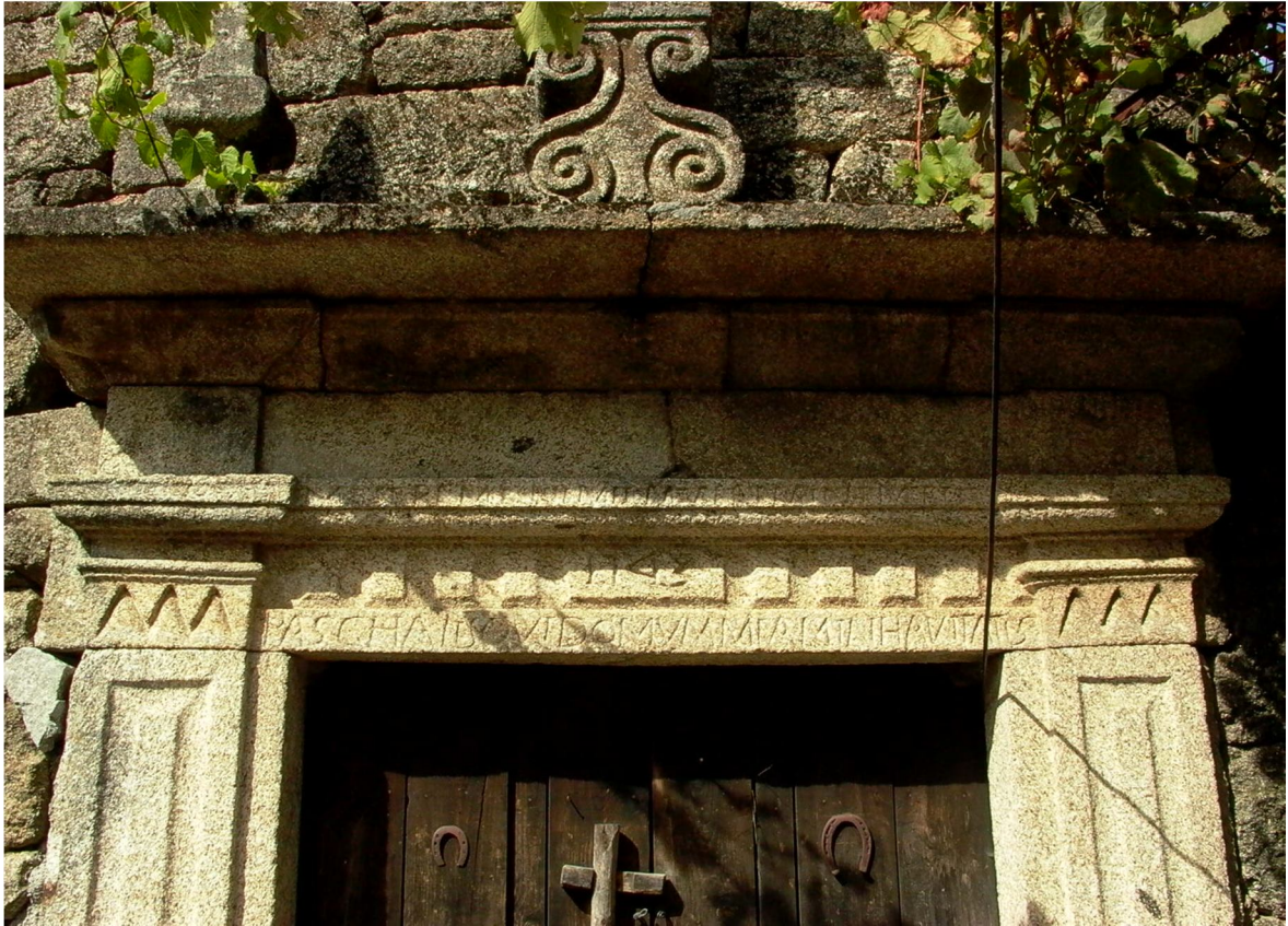
Fig.167 – Pormenor da casa anterior, com data 1743 gravada no lintel da porta.
