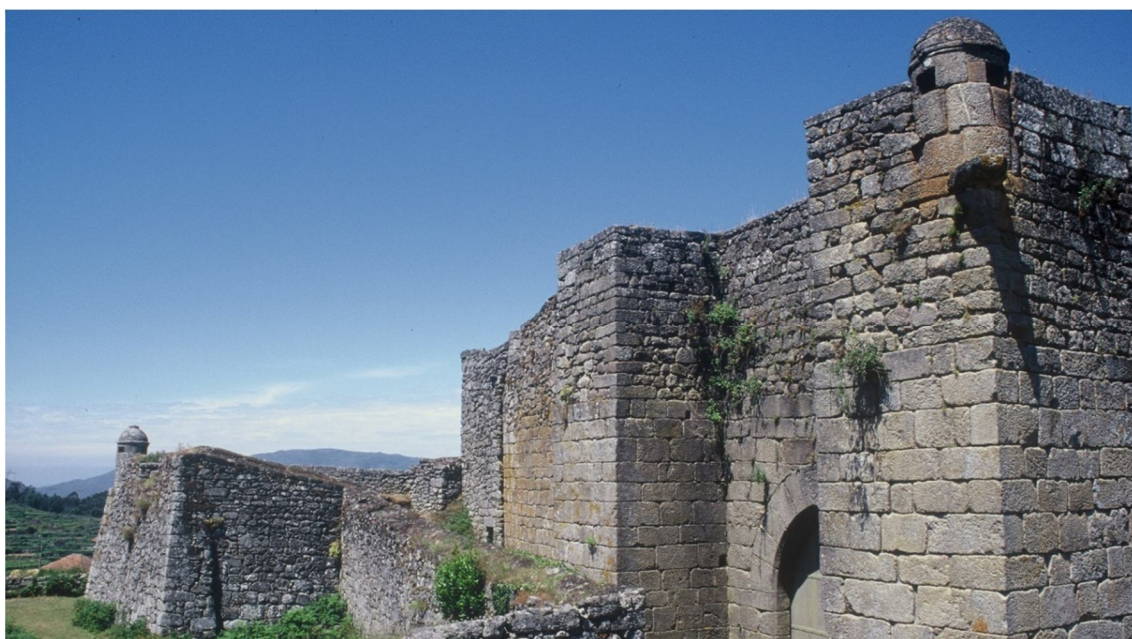
Fig.174 – Perspectiva do castelo de Lindoso, vista de SE, evidenciando-se o acréscimo sobre a antiga porta medieval.
