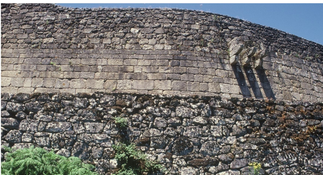
Fig.175 – Pormenor dos aparelhos construtivos, diferenciando-se, ao centro, a muralha medieval.
