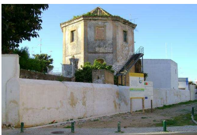
Anexo 2d – Troço nas traseiras da Casa de Fresco.
