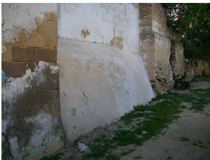
Anexo 2f – Troço nas traseiras da casa de Fresco.
