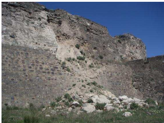
Fig. 23 – Troço Nascente: derrocada de materiais provocada pela perda de coesão, devido ao estado de degradação atingido.
