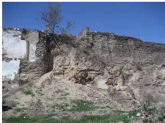
Fig. 23 – Troço Nascente: derrocada de materiais provocada pela perda de coesão, devido ao estado de degradação atingido.
