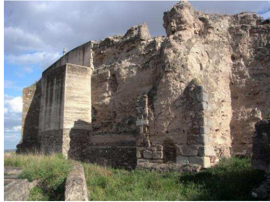
Fig. 9 – A antiga menagem (torre A), vista de Nascente: são visíveis, na sua base, vestígios de alvenarias posteriores à sua construção.
