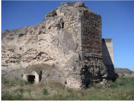
Fig. 9 – A antiga menagem (torre A), vista de Nascente: são visíveis, na sua base, vestígios de alvenarias posteriores à sua construção.
