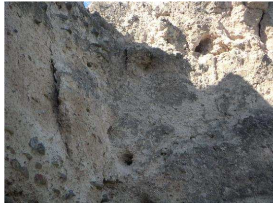
Fig. 21 – Muralha Norte, pelo exterior: presença de humidade nos paramentos e na torre, sendo visíveis, a partir da base, manchas com cerca de 6m de altura.
