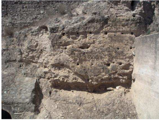
Fig. 19 – Extremidade Norte do troço Poente, pelo interior: pormenor da lacuna na base da muralha.
