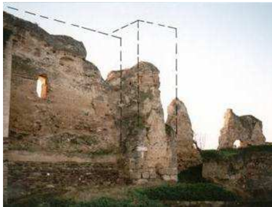
Fig. 21 – Muralha Norte, pelo exterior: presença de humidade nos paramentos e na torre, sendo visíveis, a partir da base, manchas com cerca de 6m de altura.
