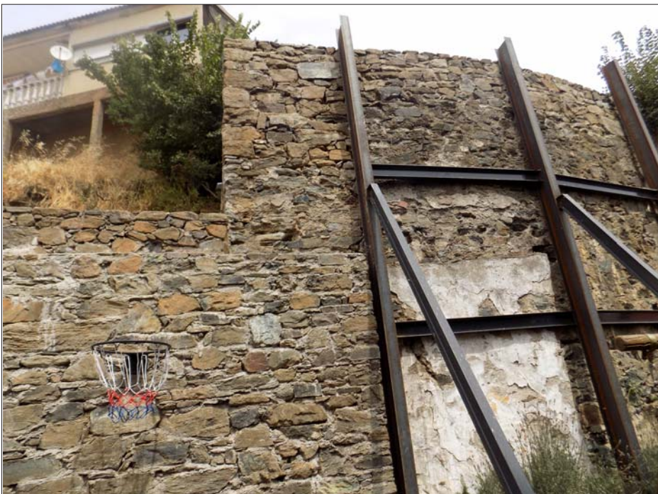
FIG. 13 – Vista final da muralha após a intervenção.
