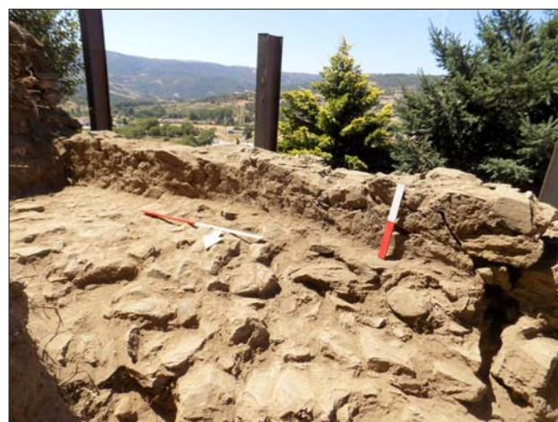
FIGS. 8 E 9 – Barbacã, adarve e arranque da estrutura ameadada. Em baixo, pormenor do adarve e da parte ameadada, construções em xisto.
