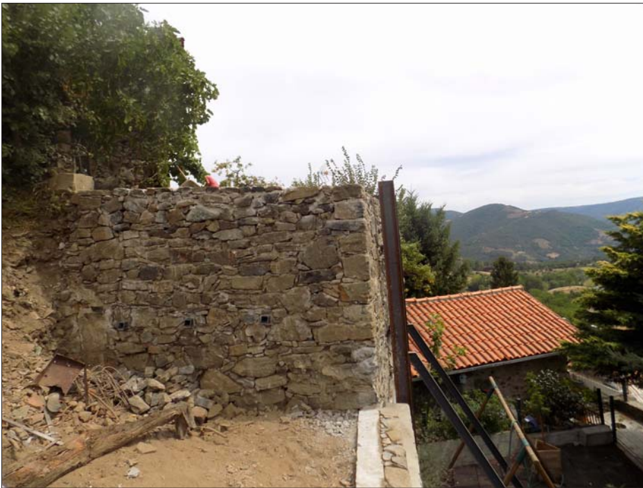
FIG. 12 – Vista final do alçado do troço B (área 2).
