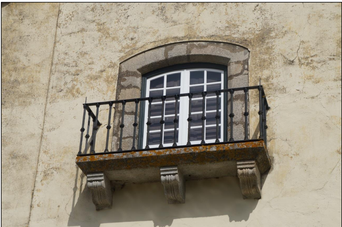
35. Pormenor do balcão da fachada Este
