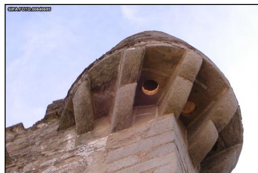
Ilustração 20. Base de um dos coruchéus com matacões
