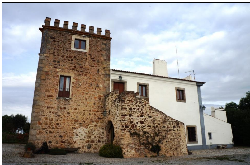
Ilustração 16. Vista exterior da Torre de D. Francisco
