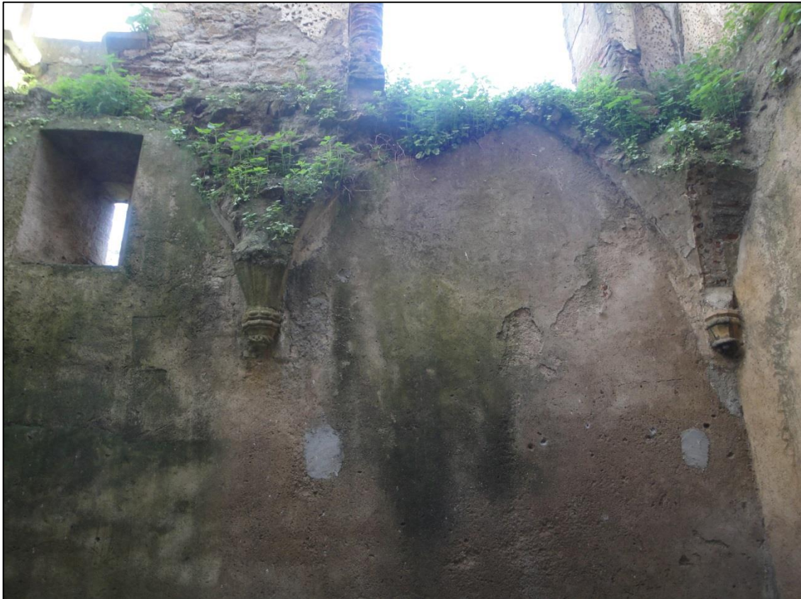
22. Vestígios de abóbadas no interior da torre
