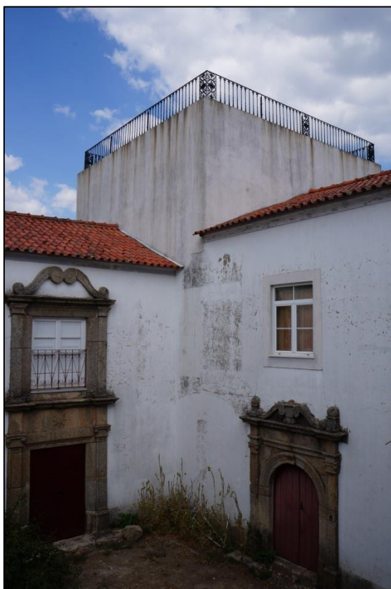
48. Topo da torre visto do pátio formado pelas alas anexas
