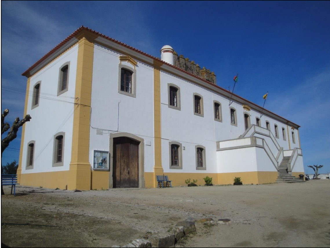
3. Conjunto da Torre de Colheiros e edifício anexo
