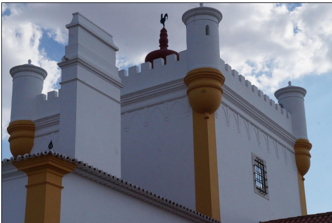
44. Vista do topo da Torre
