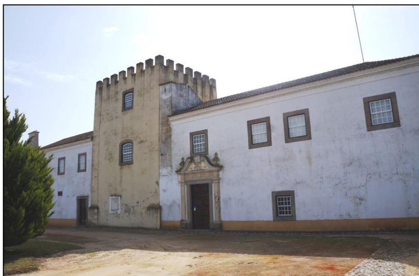
Ilustração 17. Vista exterior da Torre da Amoreira
