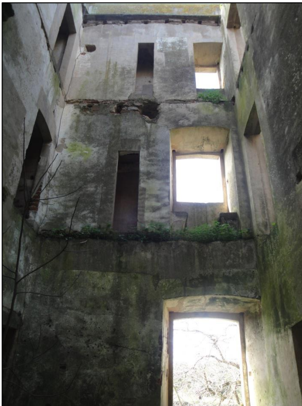
19. Interior da fachada Noroeste
