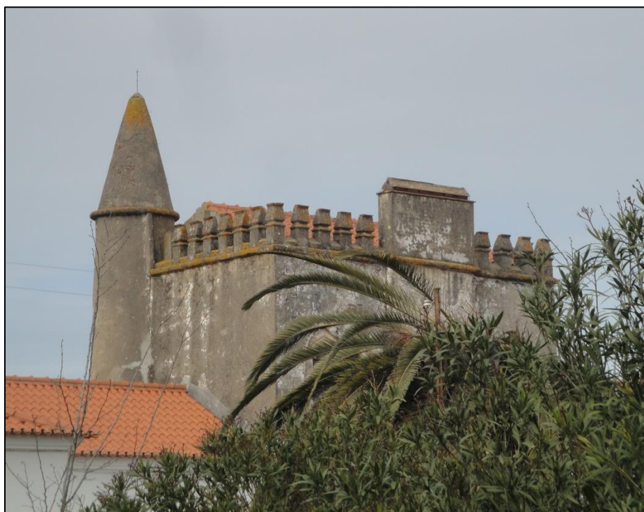
9. Topo da torre (cunhal Sudoeste)
