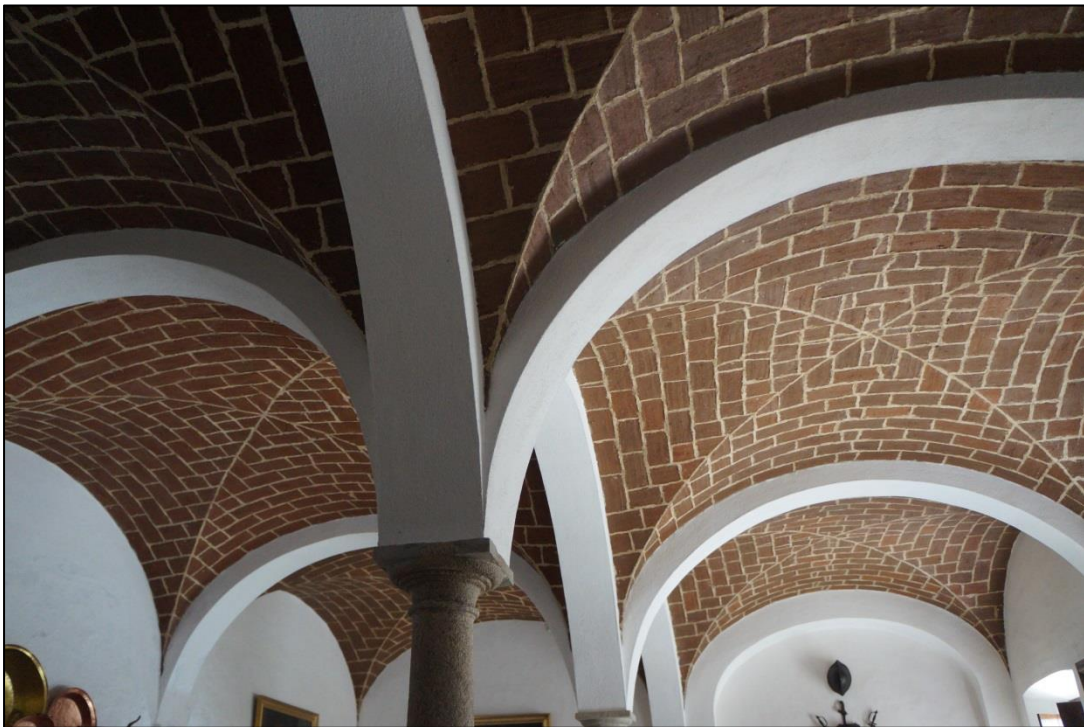
31. Abobadamento no teto da ala anexa a Este
