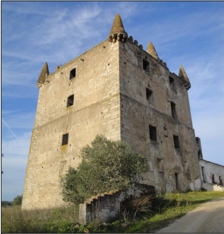
Ilustração 19. Vista exterior da Torre das Águias
