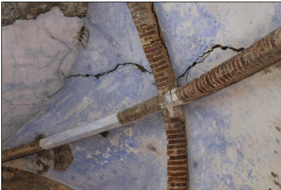
42. Vestígios de policromia no teto do primeiro andar da Torre de Cabedal
