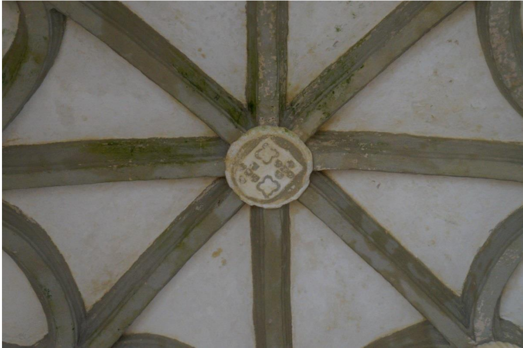
56. Pormenor da chave central da abóbada do primeiro andar
