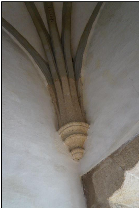
55. Pormenor da mísula da abóbada do primeiro andar
