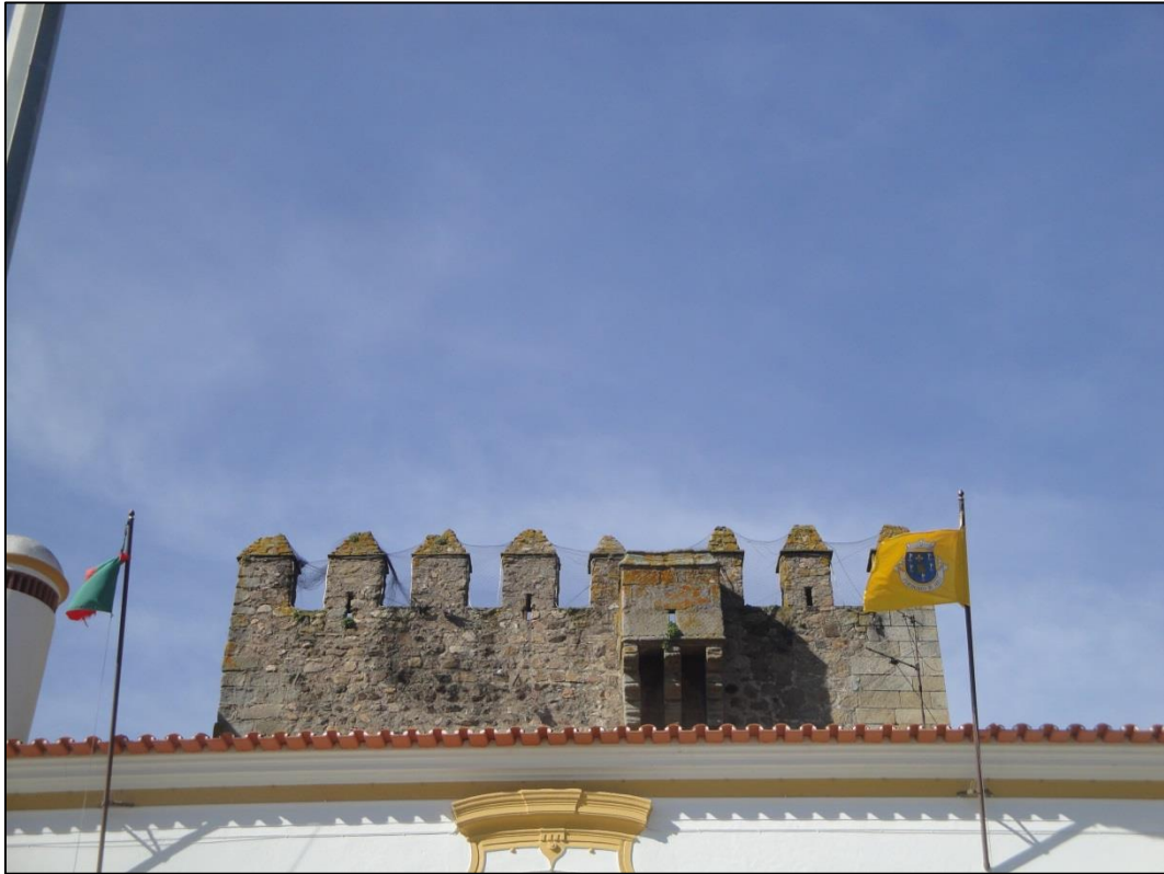
5. Balcão com matacões na fachada Este
