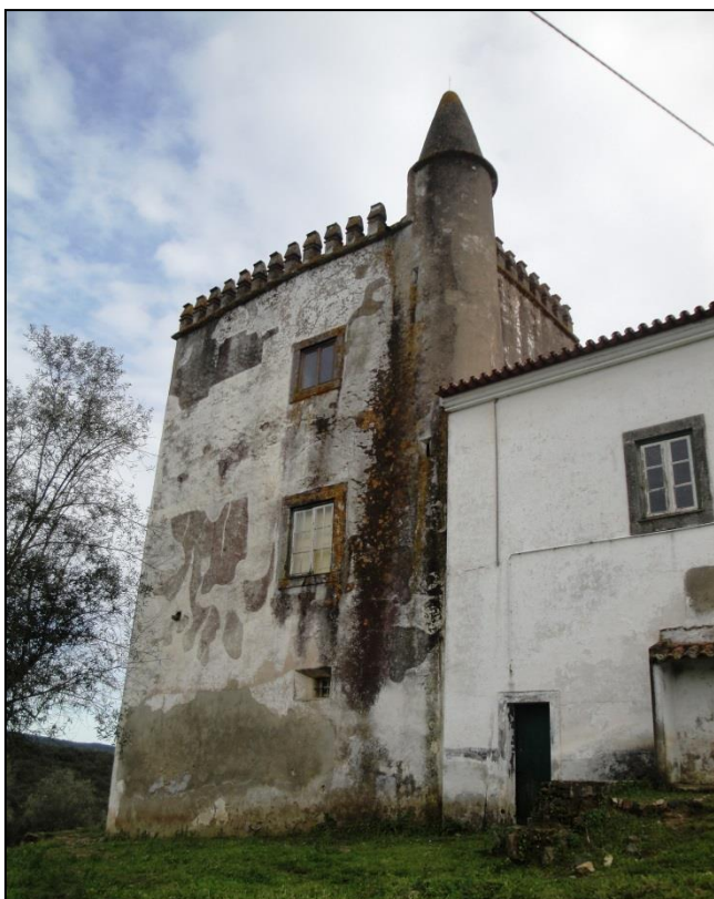
Ilustração 9. Vista exterior da Torre da Giesteira
