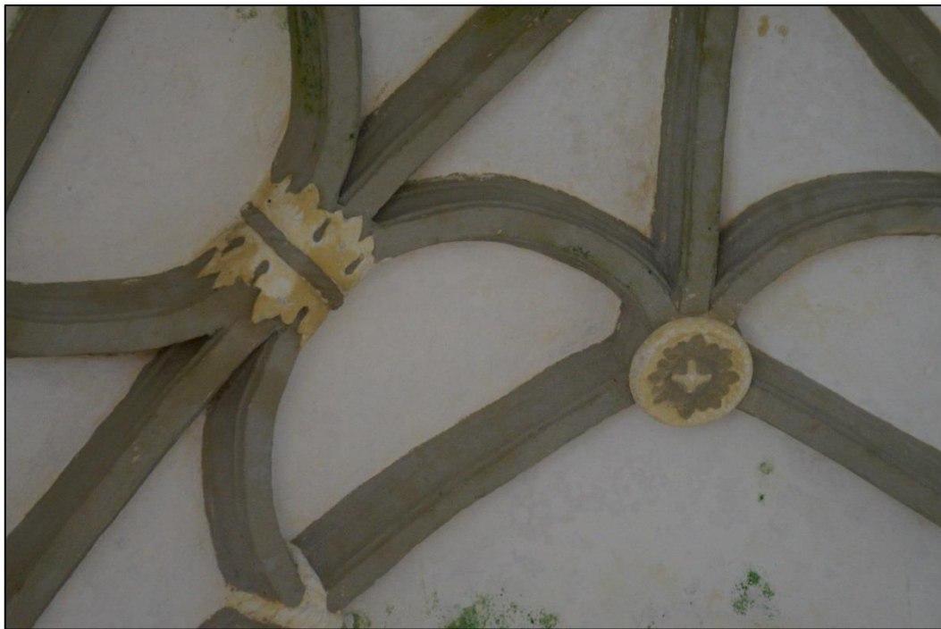
57. Pormenor decorativo da abóbada do primeiro andar
