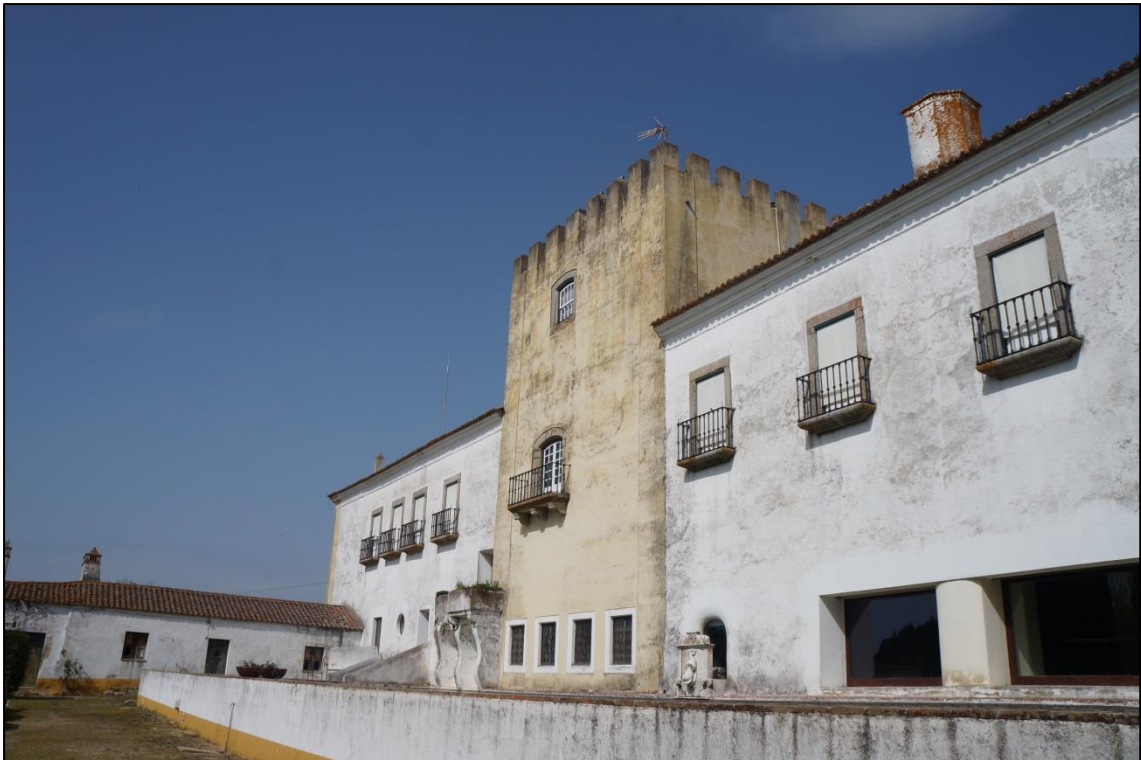
34. Fachada Este e tanque com espelho de água
