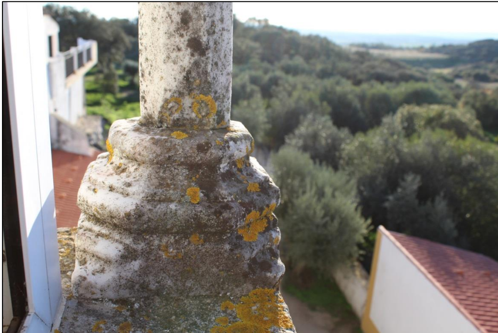
15. Pormenor do mainel da janela no cunhal Oeste
