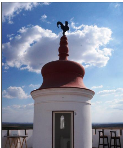
Ilustração 30. Torre cilíndrica no topo da torre para acesso à escadaria helicoidal
