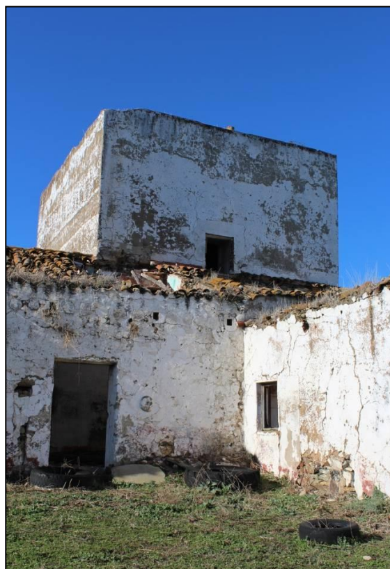
Ilustração 27. Exterior de Torre do Cabedal
