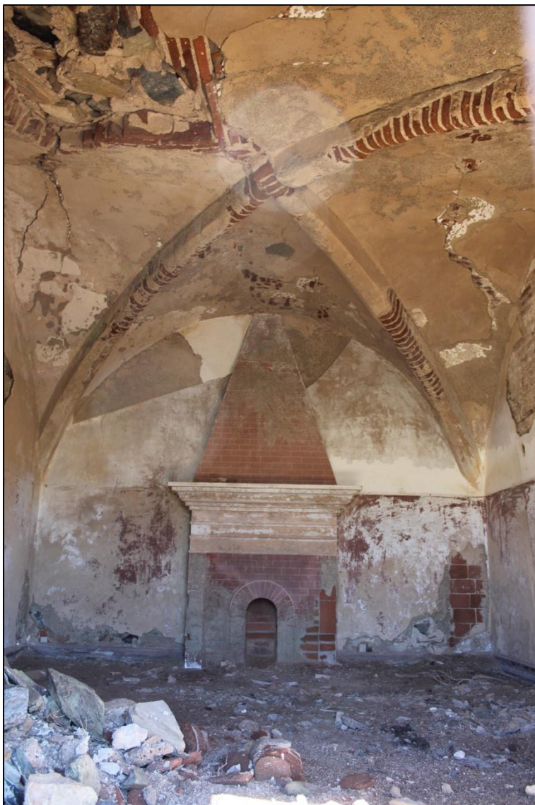
40. Interior do piso térreo da Torre de Cabedal
