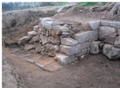
fig. 4 Vista geral da Muralha e torreão leste após limpeza dos níveis de aterro.
