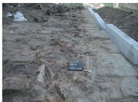
fig. 8 A Muralha, os trabalhos de limpeza do seu topo.
