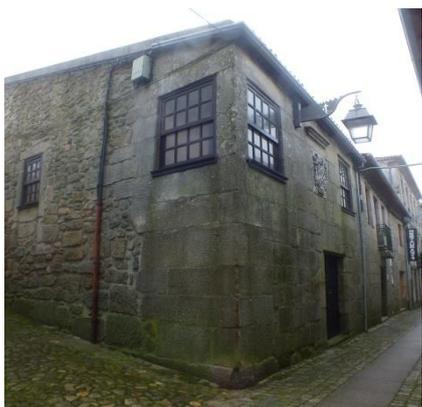
Fig. 179 Edifício em blocos de granito. Fonte: Autora, 2019.
