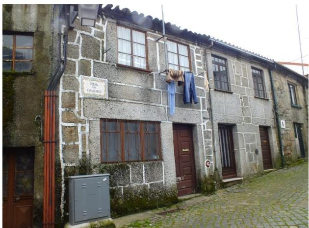
Fig. 170 Paredes de blocos em granito com juntas de argamassa pintadas a branco. Fonte: Autora, 2019.
