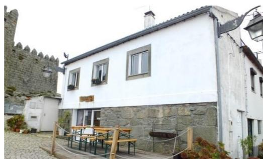
Fig. 182 Edifício revestido a blocos de granito e reboco. Fonte: Autora, 2019.
