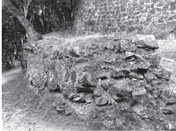
Figura 11 – Barbacã da muralha norte (vestígios remanescentes).
