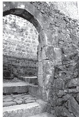
Figura 10 – Alambor do Último Reduto (porta a norte do conjunto). 2015
