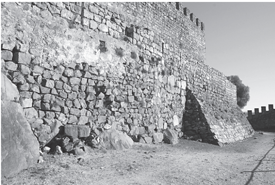
Figura 9 – Alambor do Último Reduto (interrupção a oeste do conjunto).
