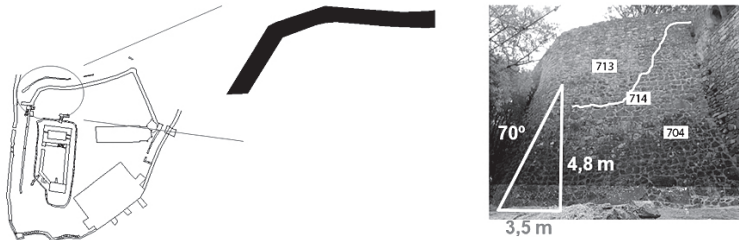
Figura 4 – Planta do núcleo A, à esquerda, com destaque para o setor de muralha norte junto da Porta Nova, ao centro. Talude, à direita (leitura estratigráfica parcial e cálculo de inclinação).
