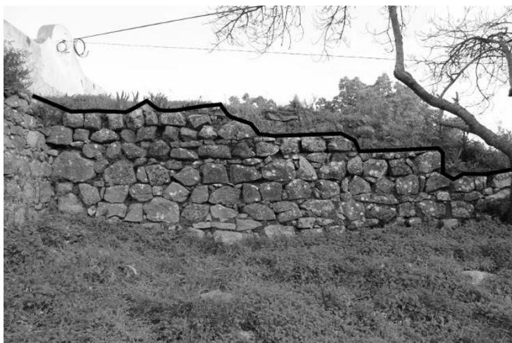
Figura 31 – Alçado Oeste com a parte negativa da destruição (linha a negro).
