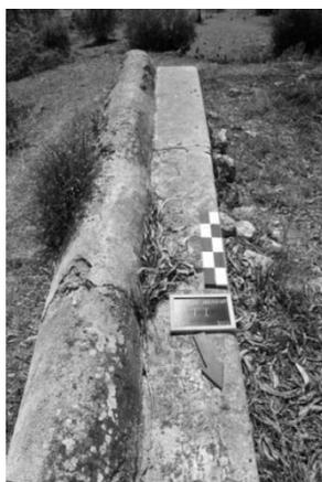
Figura 37 – Camada de cimento sobre o paramento Oeste da torre.
