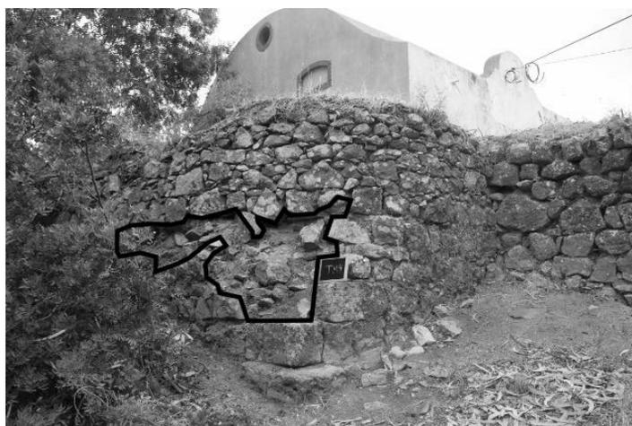
Figura 50 – Alçado do troço de muralha 2 com a parte negativa da destruição (linha a negro).
