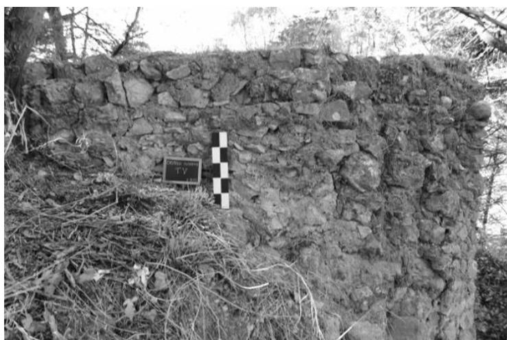
Figura 180 – Parede sem a face exterior.
