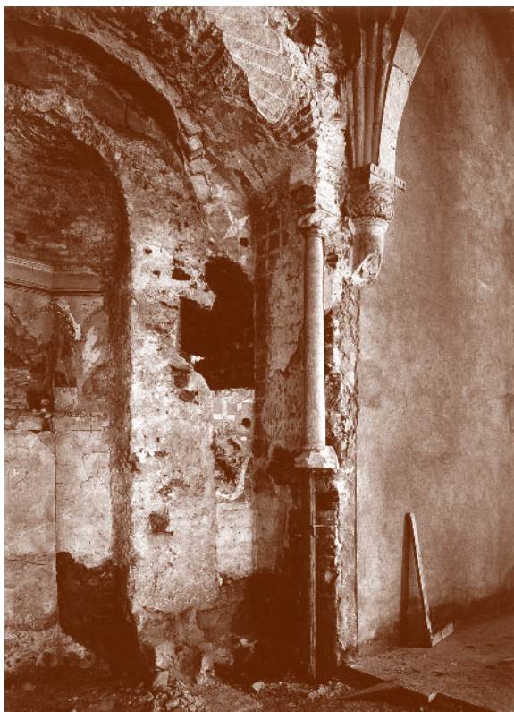
Fig. 4. Obras de restauro no mihṛāb na década de quarenta do século XX (fotografia da DGEMN).
