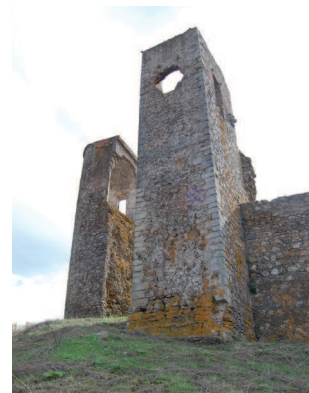
Fig. 7 - Torre de Menagem da praça forte.
