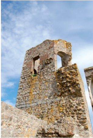
Fig. 8 - Janela em tijolo rasgada no alçado sudoeste da torre de menagem, datável do séc. XVII.
