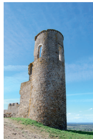
Fig. 3 - Torre cilíndrica onde se observam janelas com lintéis em arco contracurvado.
