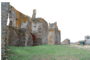
Fig. 4 - Paredes, menos espessas que o pano de muralha anterior, construídas nos finais do século XVI, inícios do século XVII.
